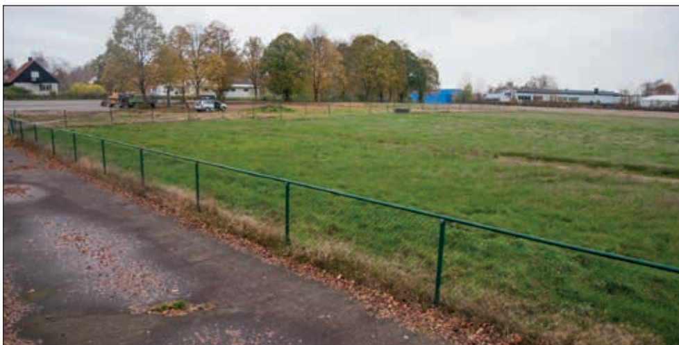
Fig 2. Del av förundersökningsområdet innan påbörjad schaktning. Foto mot nordväst. Foto: Leif Häggström, (Fotonr: 2015-13-1).
