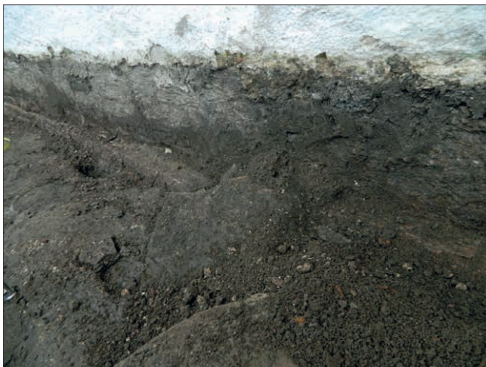
Fig. 6. Murparti på kyrkans södra sida. Dagermuren har här sträckt sig ett skift under nuvarande markyta och har bestått av väl tillhuggna och stora stenar. Dagermuren vilar på en groundsula. Foto: Ing-Marie Nilsson, (Fotonr 2015-5-29).
