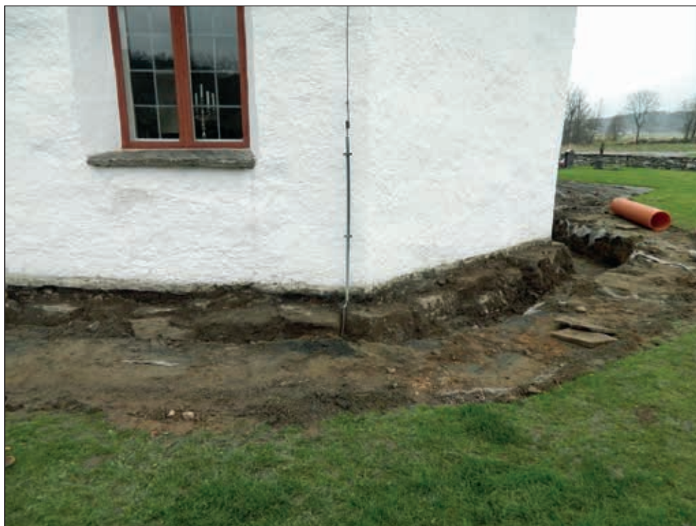
Fig. 8. Korpartiet sett mot norr som visar korttillbyggnadens grundläggning. Foto: Ing-Marie Nilsson, (Fotonr 2015-5-34).
