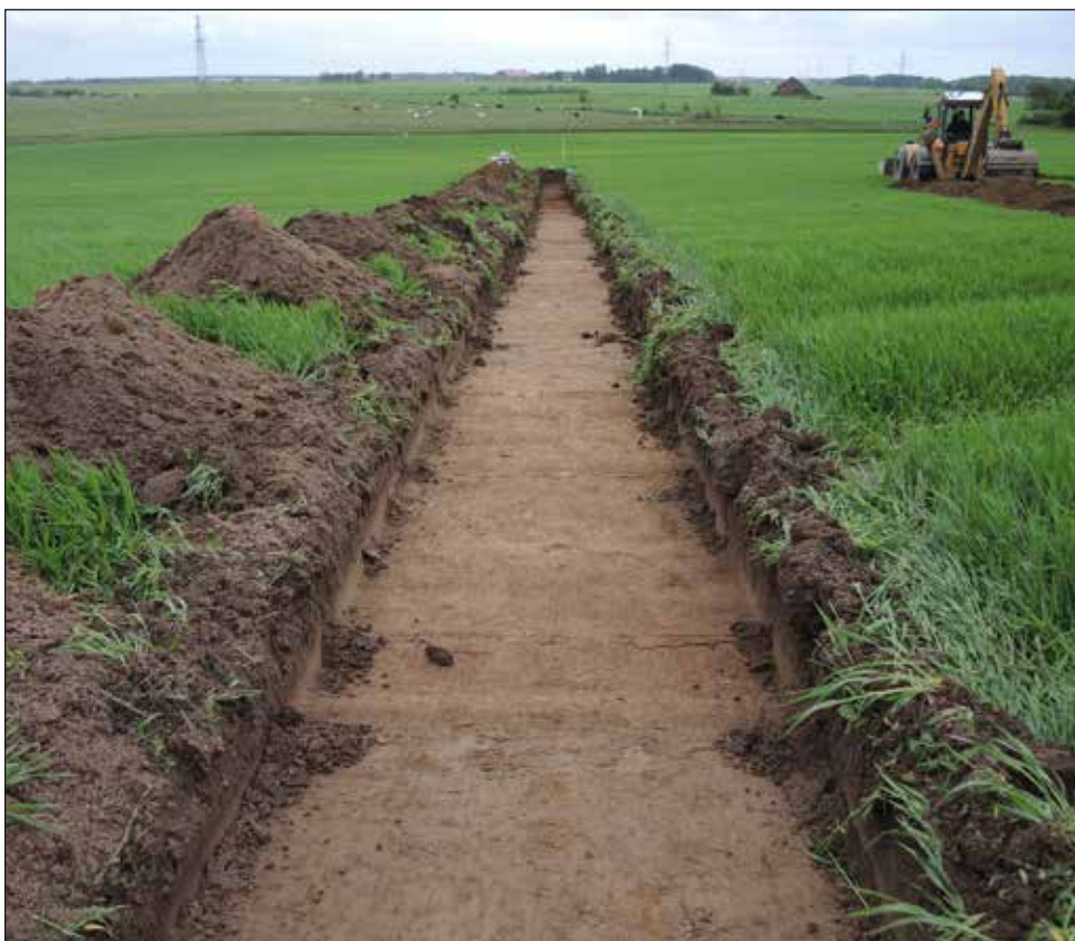
Bild 1. Schakt OS 813. Mot söder. (Foto 2015-41-02). Foto Mats Nilsson.
