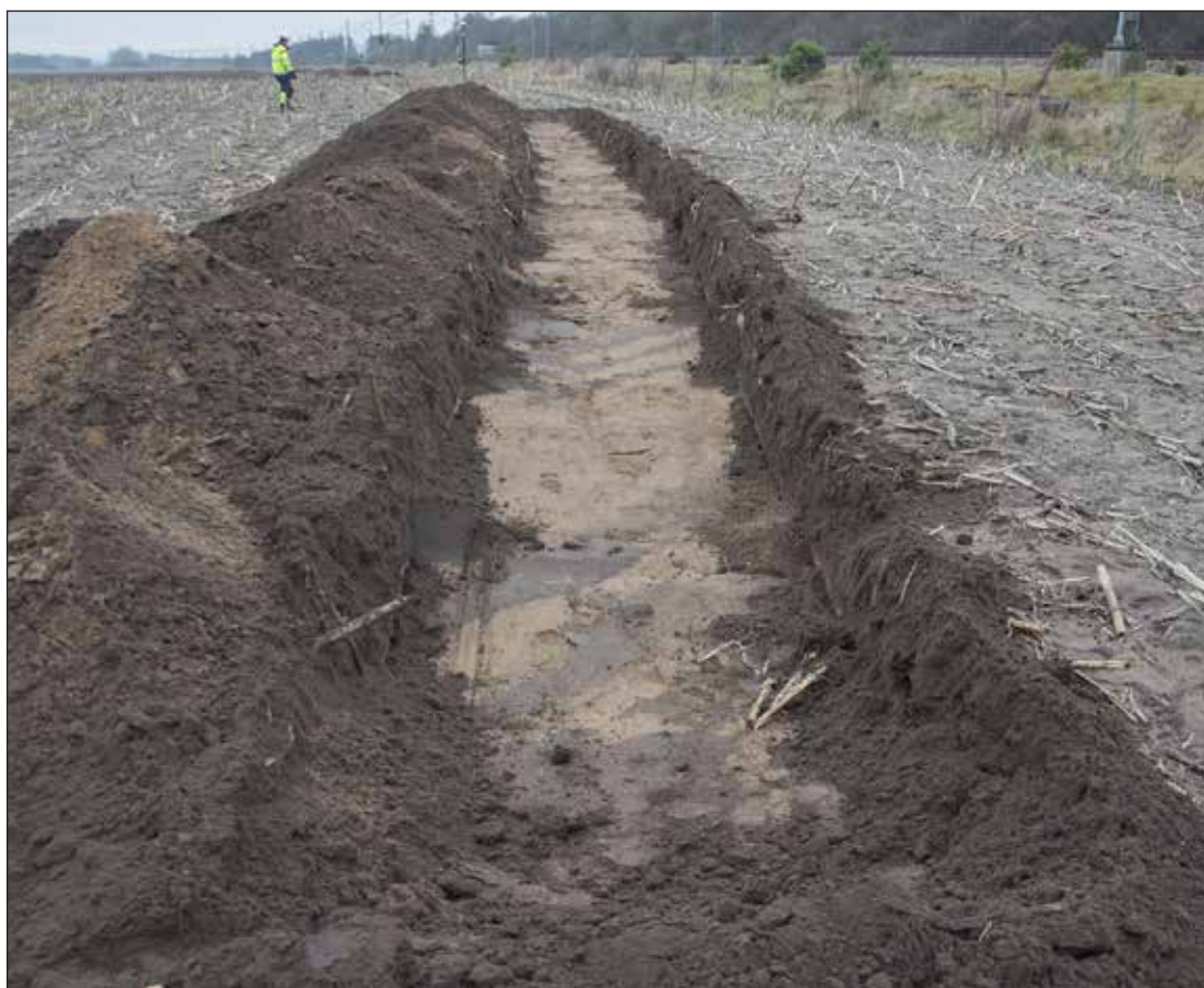
Figur 2. Schakt 370 mot söder. Delsträcka 1. Foto: Mats Nilsson. (Fotonr. 2017-1-2).
