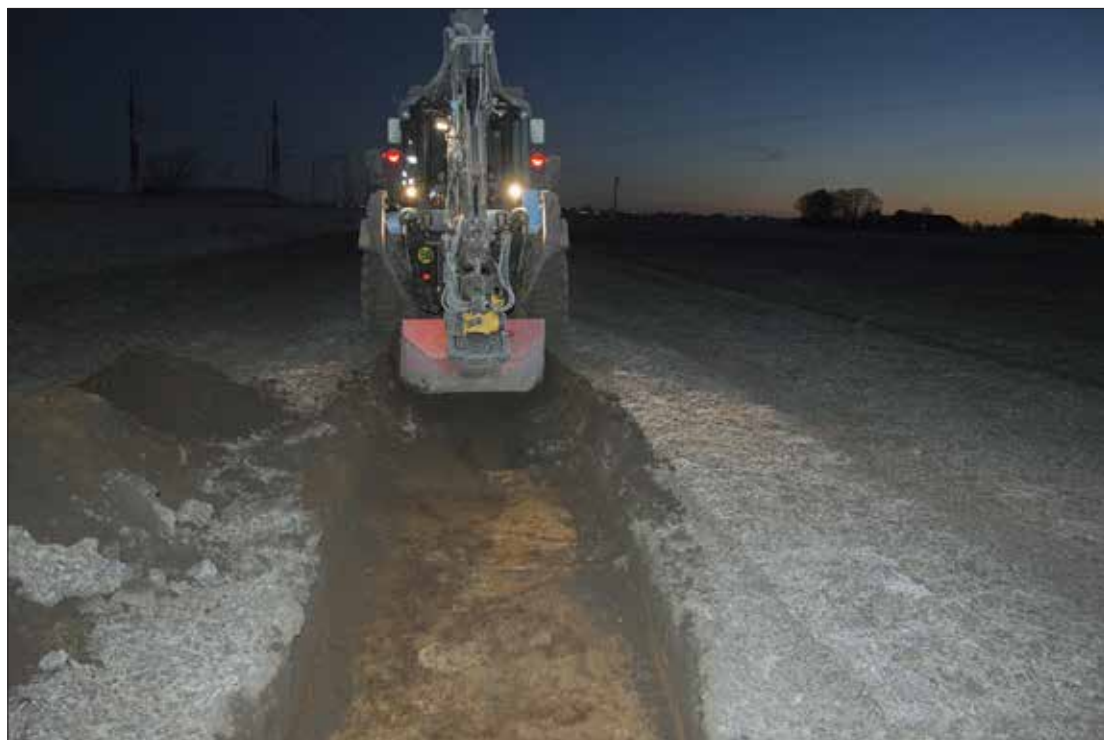
Figur 4. Schakt 505. Arbetsbild mot norr. Delsträcka 7. Foto: Mats Nilsson. (Fotonr: 2017-1-12).
