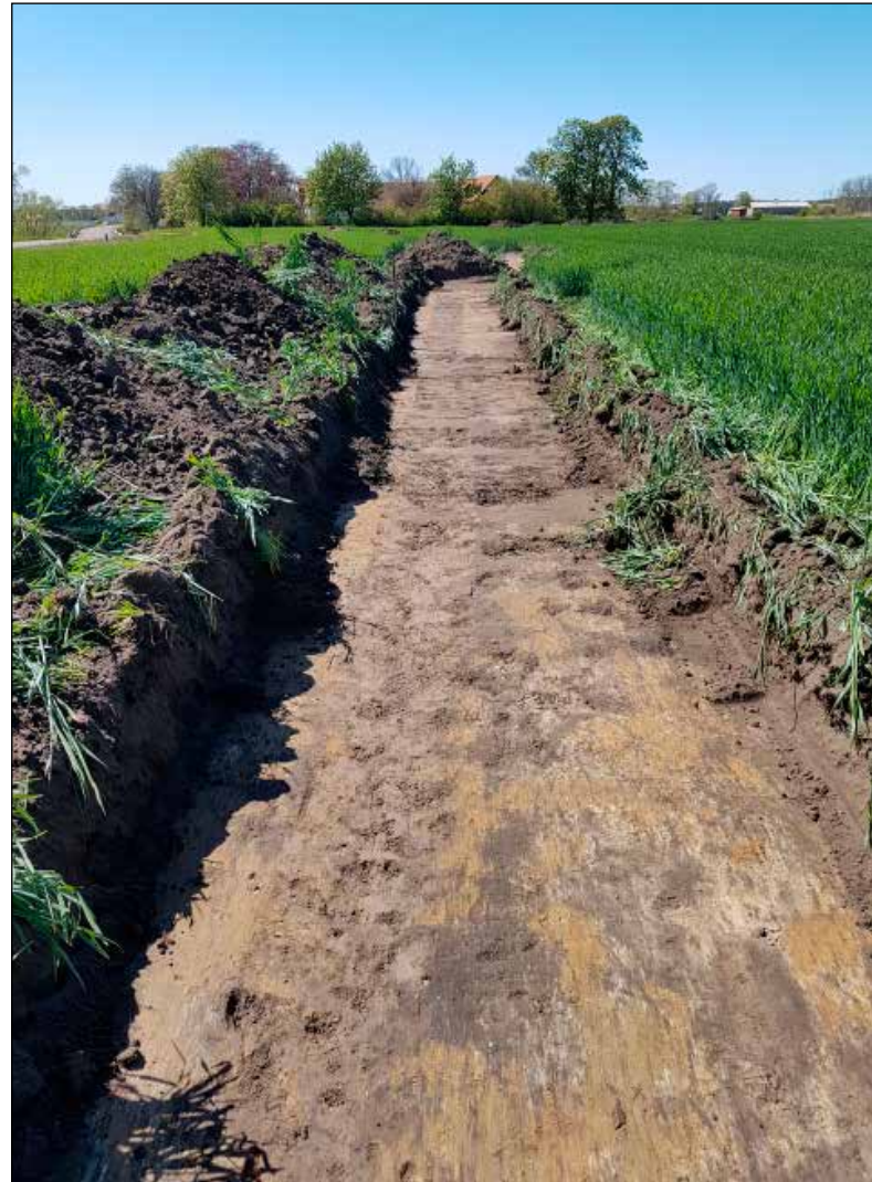
Figur 4. Schaktet OS298. Området innehåller rikligt med dräneringar. Mot väst. Foto: Ola Kadefors. (Fotonr. 2020-34-3).
