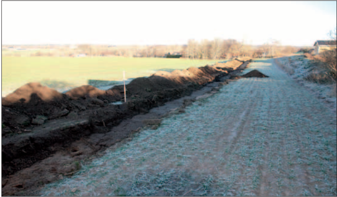
Fig. 10. Schakt 1111 med den stora mörkfärgningen 1073 mot öst. I höjd med den ensamliggande dumphögen syns djupschakt 1107 och strax bakom syns den skarpare östra kanten. Fotonr: 2014-6-11 Fotograf: Stina Tegnhed
