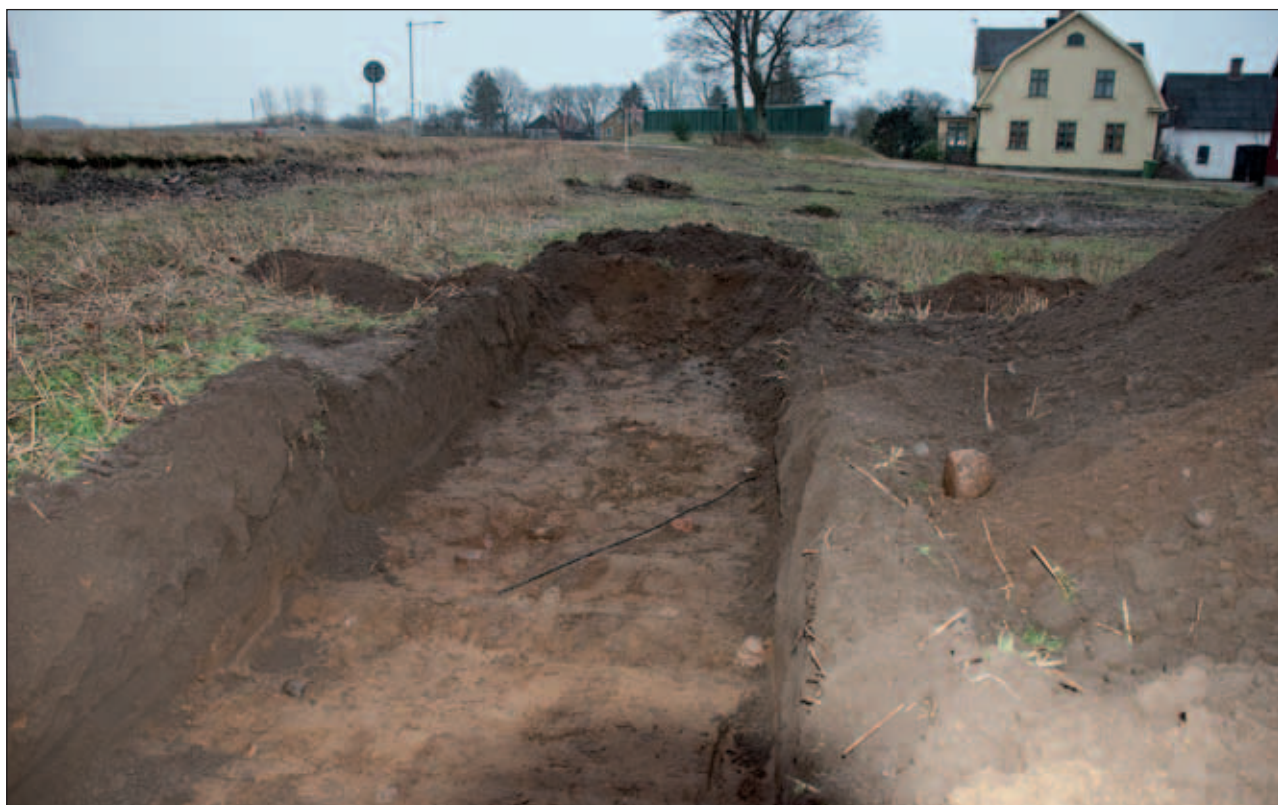
Fig. 15. Telekabeln till fastighet Tjärby 104. Mot S. Fotonr: 2014-6-34 Fotograf: Stina Tegnhed
