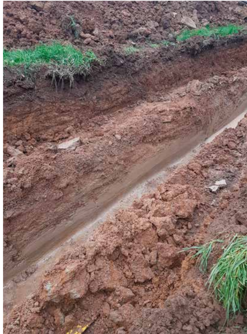
Fig 3. Profilbild av ledningsschaktet mot öst visande överst ett gräsbeväxt matjordslager, med ett underliggande siltigt sandlager. Under detta vidtog ett lerlager. Foto: Mats Nilsson. (Fotonummer 2020-76-07).
