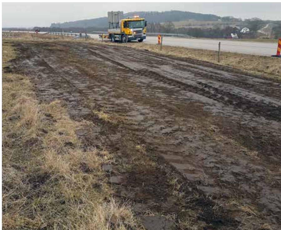
Figur 15. Översiktsbild av schakt 444 mot nordöst efter igenläggning. Fotonr. 2021-12-32. Foto: Mats Nilsson.
