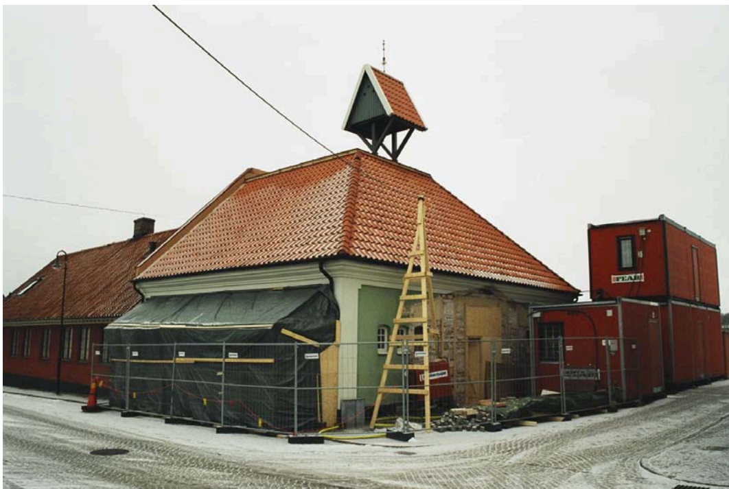
Spruthuset under renovering, Mars 2005. De gamla portöppningarna återställs.
