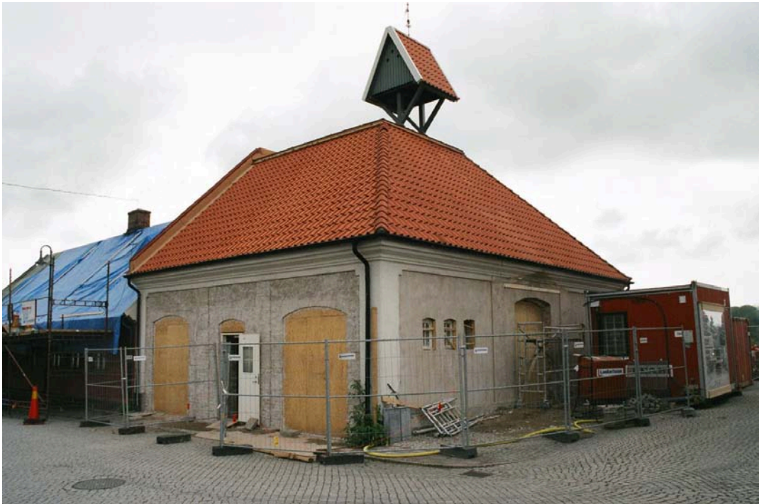
Fasaden på väg att återskapas med ny puts och lisener runt portöppningarna. Maj 2005.
