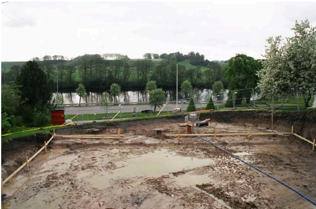
Grundläggning för den nya byggnaden pågår. Vy mot norr med Köpingelandet i bakgrunden. Maj 2005.
