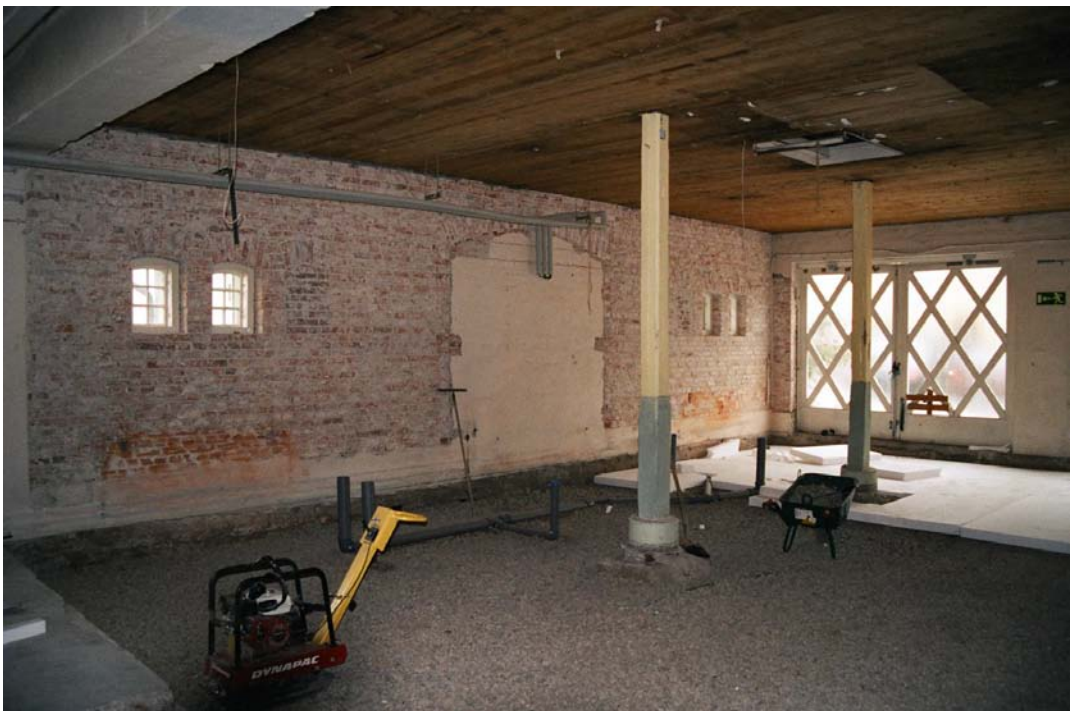
Spruthusdelen efter att betonggolvet tagits bort. Isolering och avlopp läggs på avjämningen av makadam. Augusti 2004.
