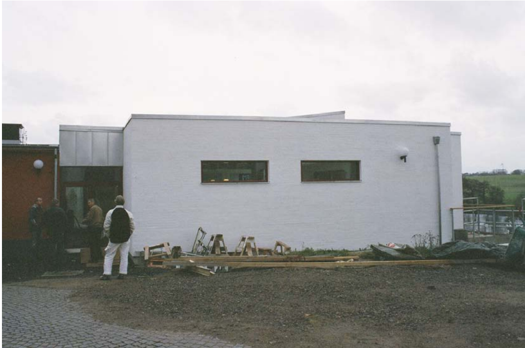
Fasad mot öster. November 2006.
