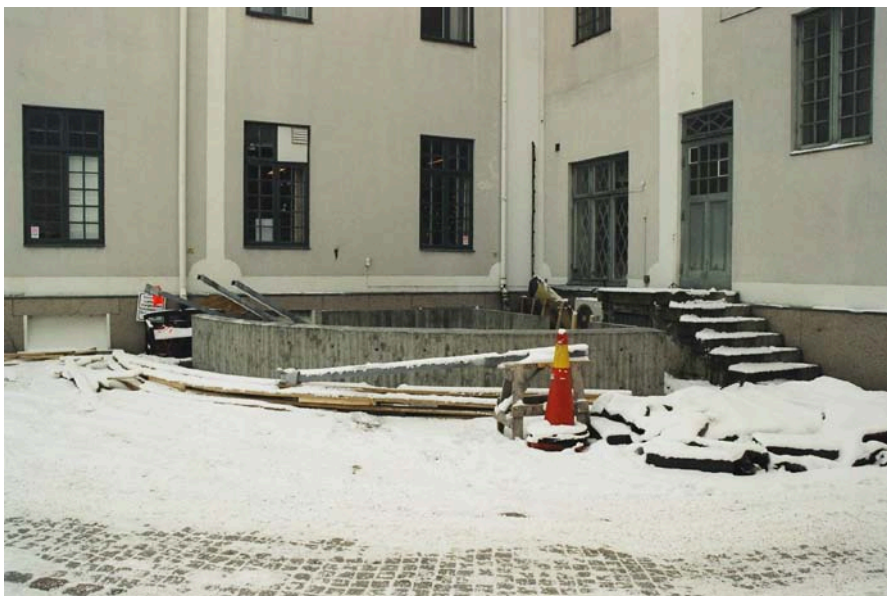
Grunden gjuten. Till höger trappan som senare togs bort. Mars 2005.
