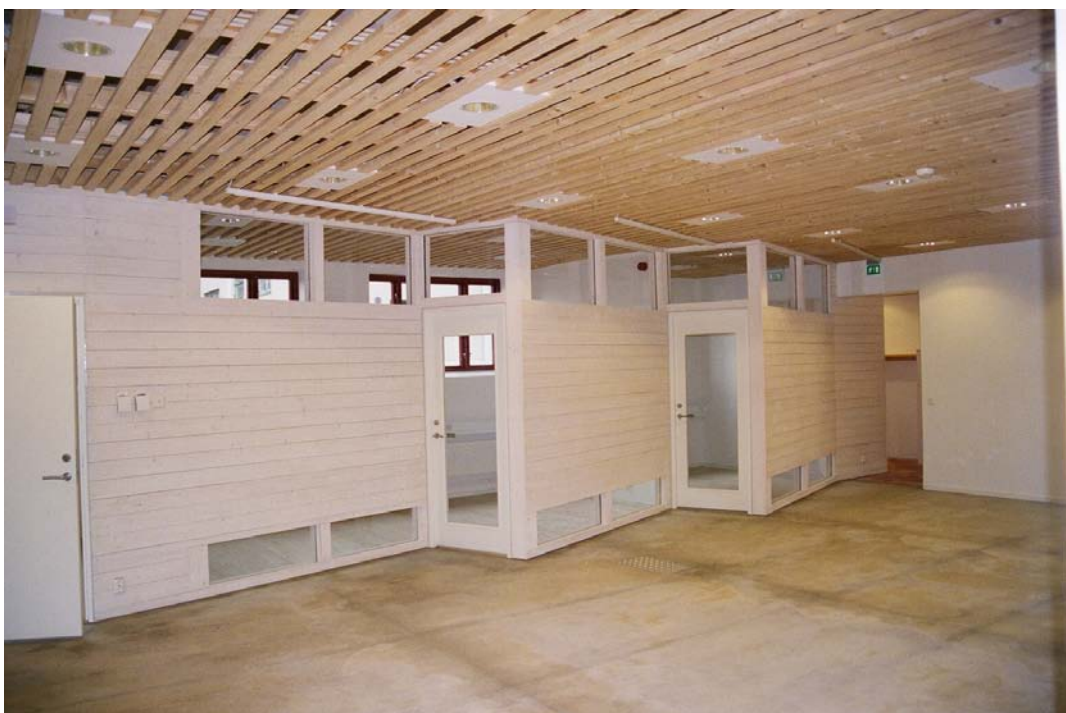
Interiör med kontorsrum efter renoveringen. November 2006.
