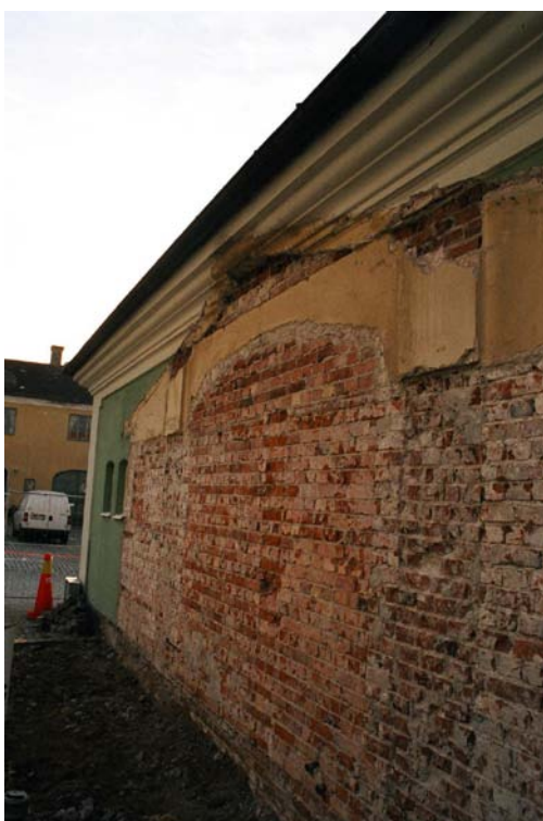
Sedan WC-utbyggnaden rivits kunde den ursprungliga portöppningen mot öster återskapas. Spår av äldre kalkputs med gul färg fanns över stickvalvet.
