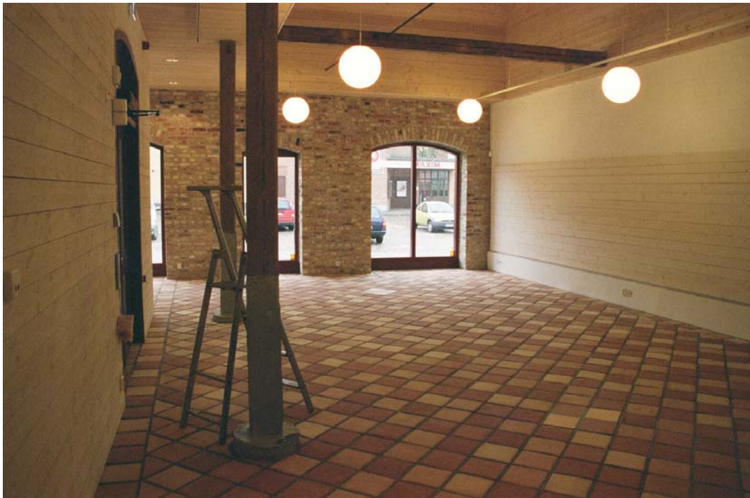
Interiören efter renoveringen. Vy mot söder.
