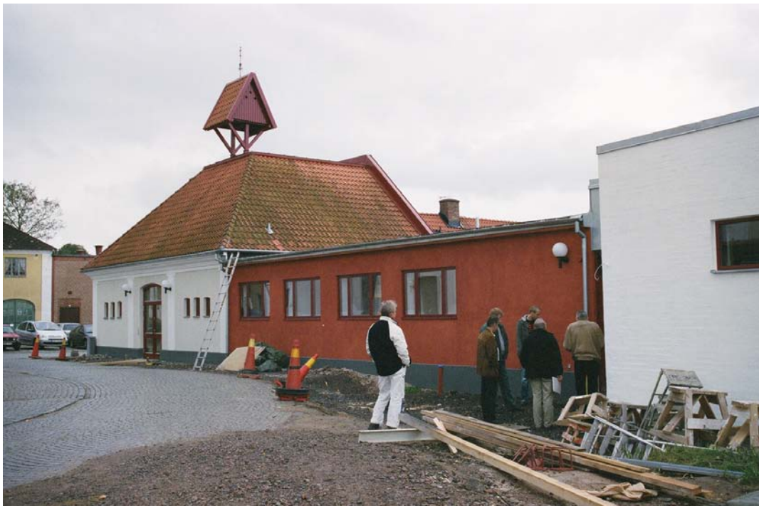
Tillbygganden efter renovering. Fasad mot öster. November 2006.
