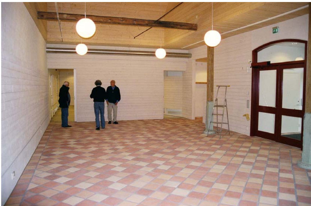
Interiör slutbesiktning. Vy mot norr. Notera det vackra golvet med handslaget tegel. November 2006.
