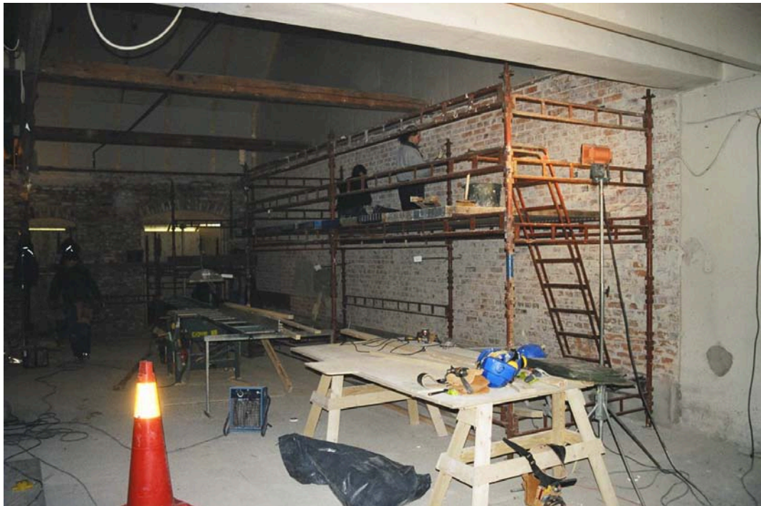
Västra väggen repareras. Mars 2005.
