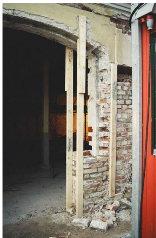
Sedan WC-utbyggnaden rivits kunde den ursprungliga portöppningen mot öster återskapas. Spår av äldre kalkputs med gul färg fanns över stickvalvet.
