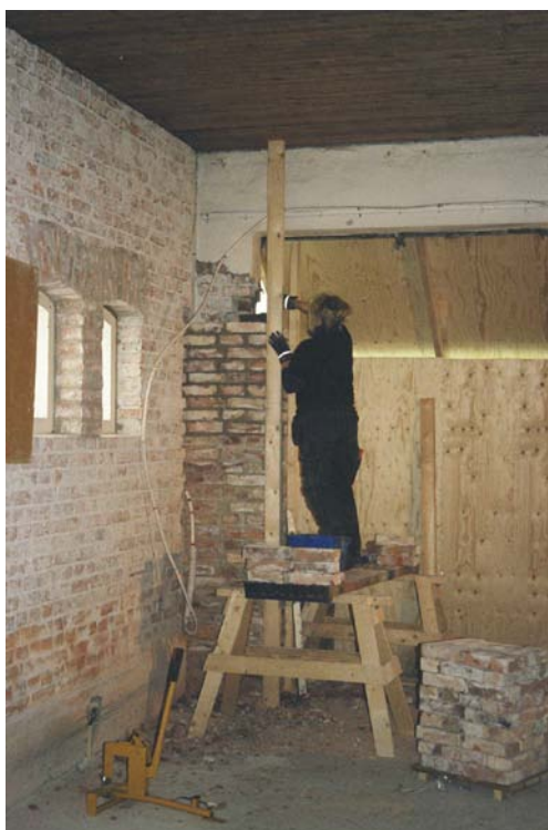
Uppmurning av valv med begagnat tegel i södra väggen. Den på 50 talet tillkomna betongvalvet behölls men murades över. Th fogas tegel i en återupptagen fönsteröppning.
