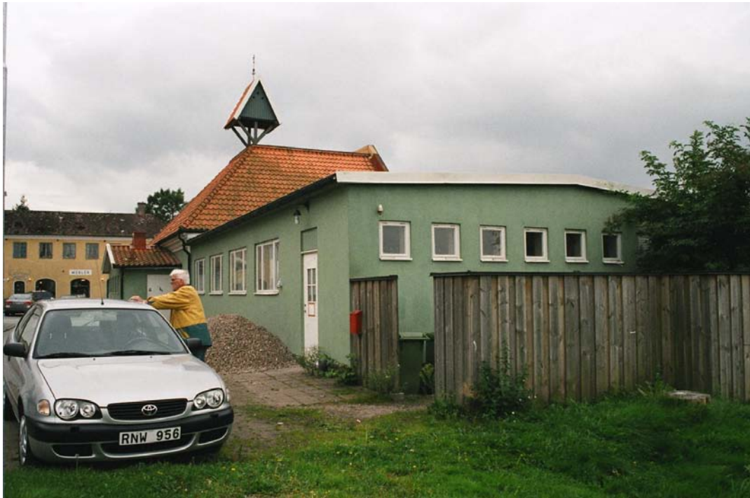
Brandstationen före ombyggnaden. Vy mot söder från slänten ned mot Lagan. Till vänster byggledare Ingvar "Cheeta" Johansson.
