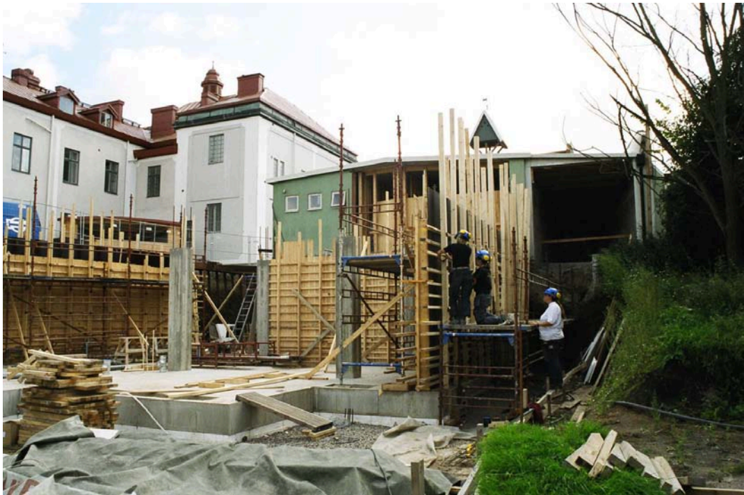
Väggar gjuts. September 2005.
