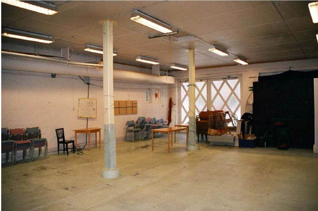
Brandstationen före ombyggnaden. Interiör. Vy mot sydost.
