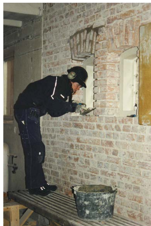
Uppmurning av valv med begagnat tegel i södra väggen. Den på 50 talet tillkomna betongvalvet behölls men murades över. Th fogas tegel i en återupptagen fönsteröppning.
