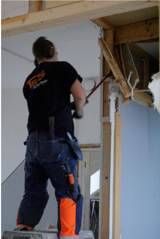
Rivning av vägg.
