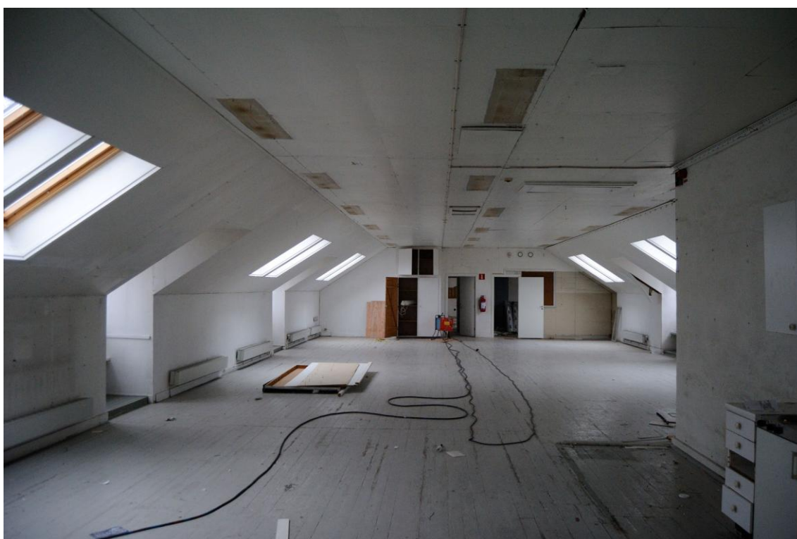
Vinden före renovering. Vy mot söder.
