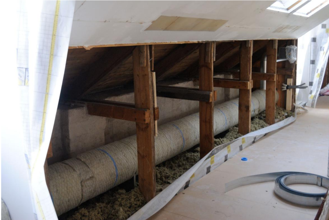
Utrymmet bakom stödbenen vid takfoten har använts för ventilation och andra installationer.
