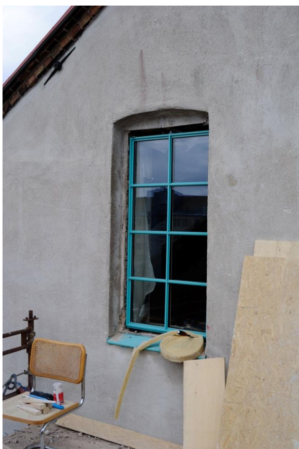
Ett av de nya fönstren.
