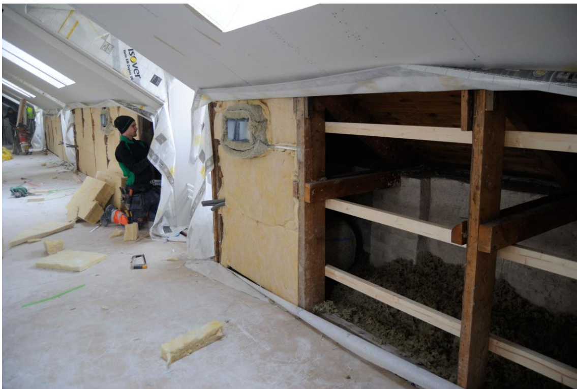
Väggpartiet vid takfoten isoleras.
