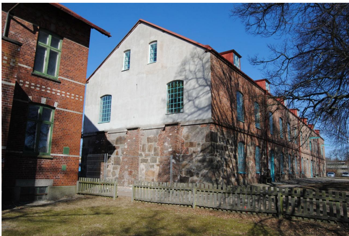
Södra gaveln efter renoveringen. Vy från sydost. April 2013.
