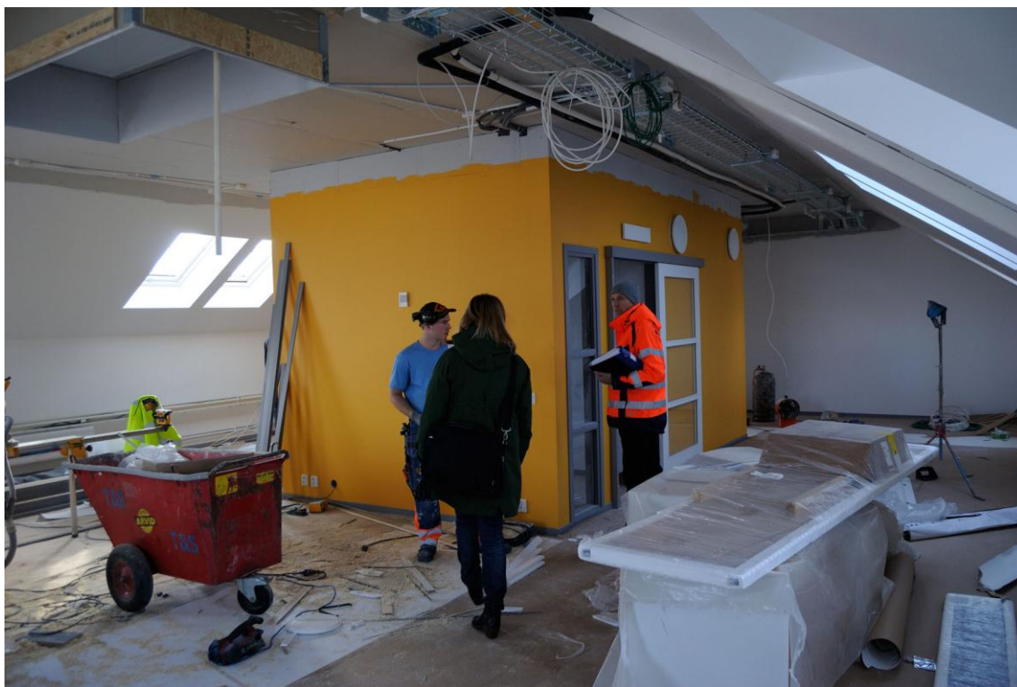
Den "gula boxen" i norra delen under färdigställande. Mars 2013.
