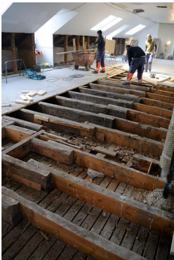
Frilagt bjälklag. Bjälkarna är skarvade med bultar på mitten.
