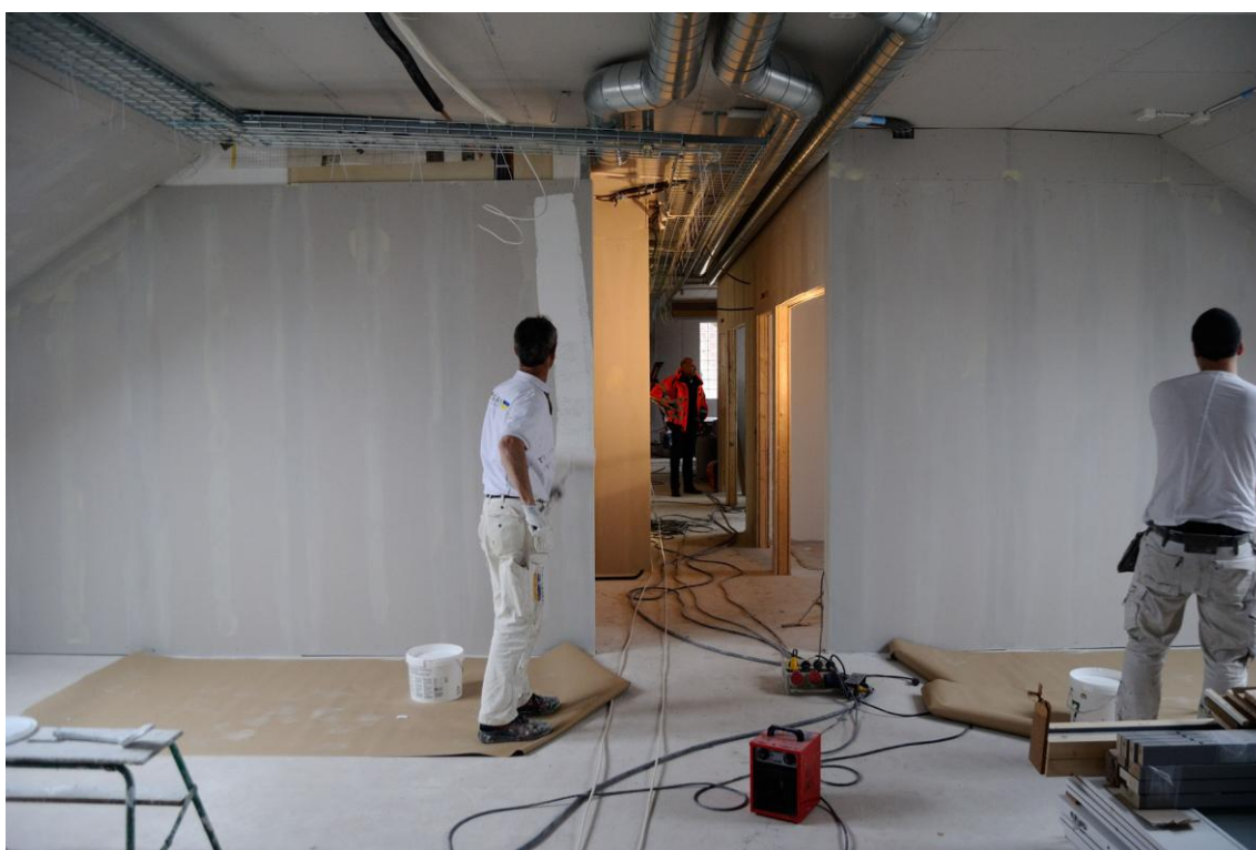
Väggarna får en första strykning målarfärg. Februari 2013.
