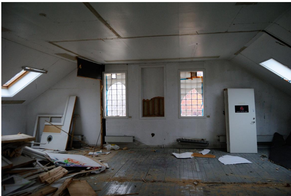
Väggar nedrivna vid södra gaveln.
