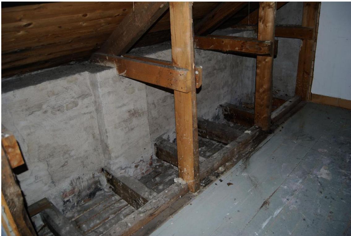
Stödbenen till takstolen. Hela takkonstruktionen uppfördes efter branden 1936.
