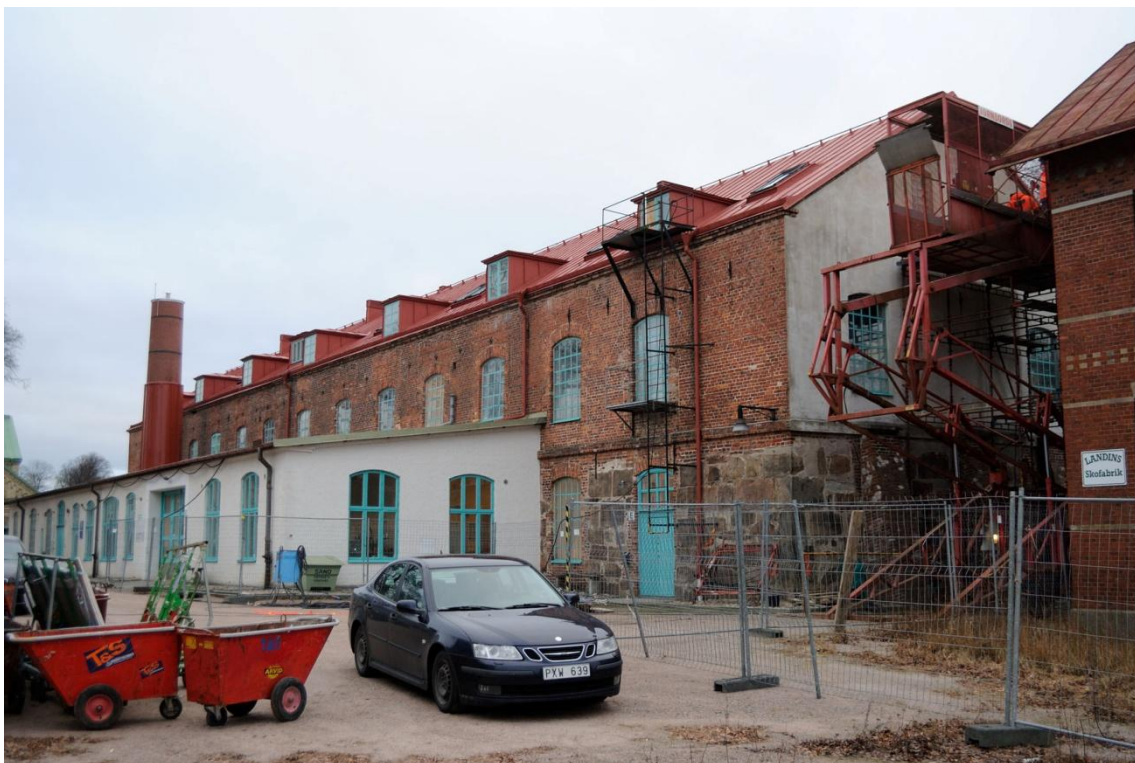
Vy från sydväst. Bygghiss uppsatt på södra gaveln.
