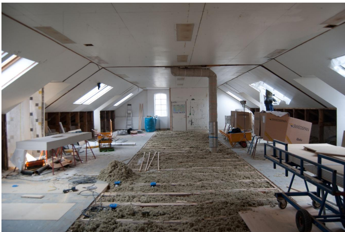
Bjälklaget isolerades med mineralull. Golvet riktades och gipsades. Januari 2013.
