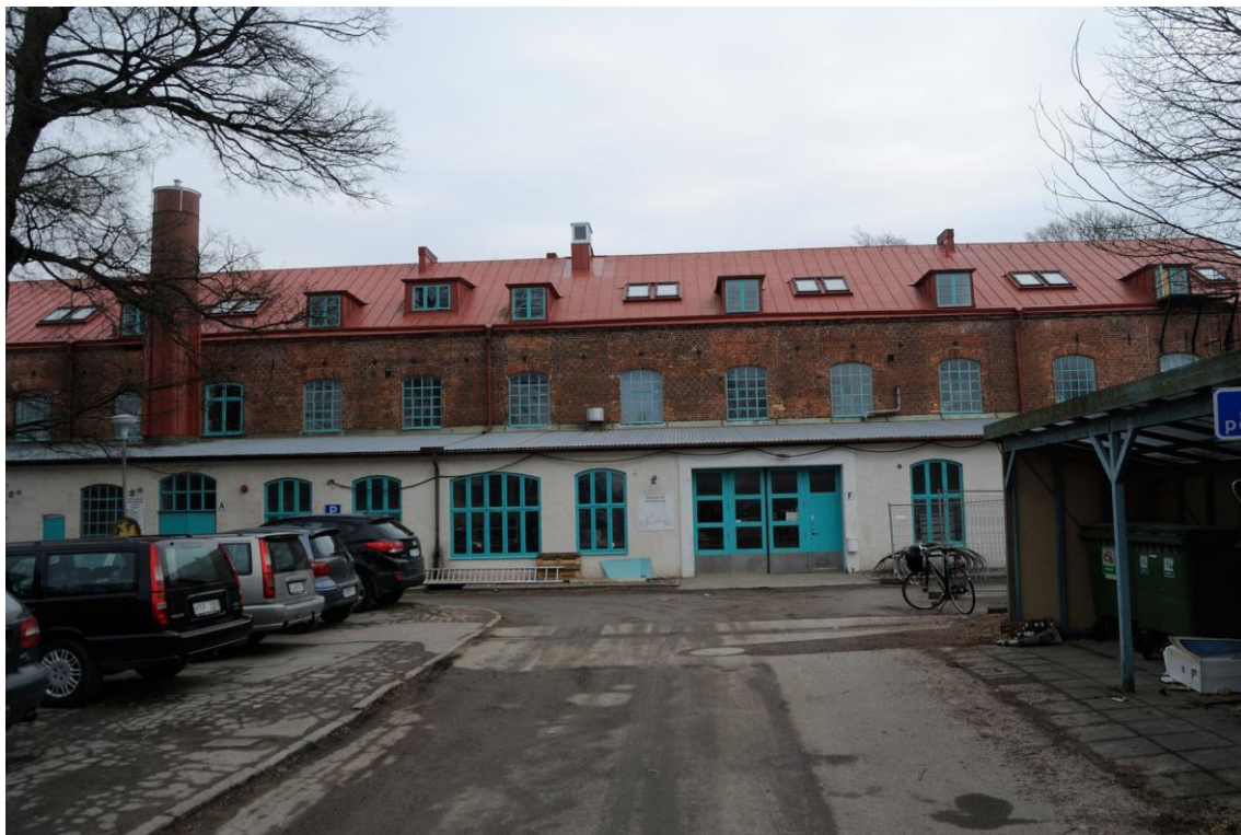
Den nya ventilationshuven har fått en central placering på huskroppen. Mars 2013.
