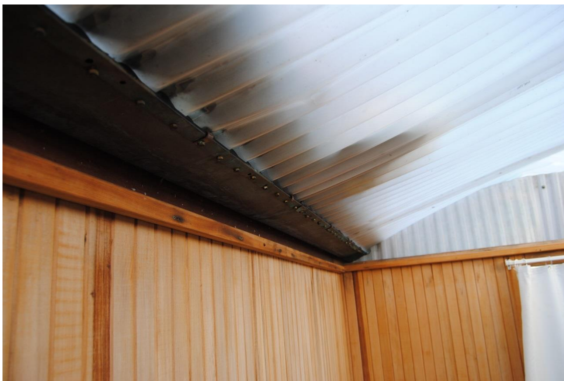
Befintlig kopparränna och fäste före renovering sett inifrån.
