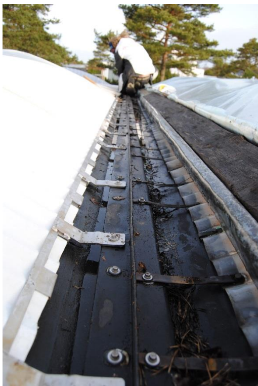
Ny takinfästning till vänster och äldre till höger.
