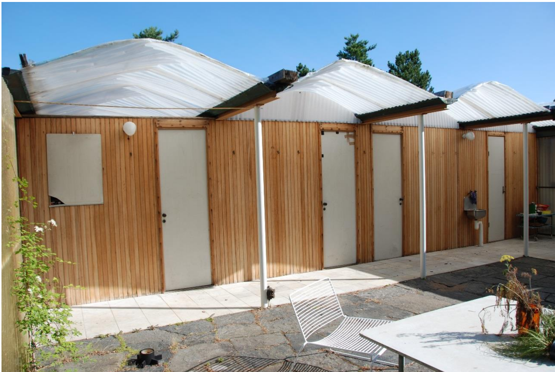
Taket kring solgården före renoveringen.
