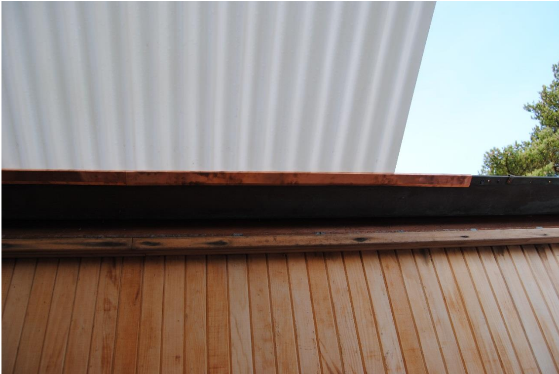
Test av de nya kopparblecken som ska monteras för att dölja den nya infästningen, efter att det skadade taket demonterats.
