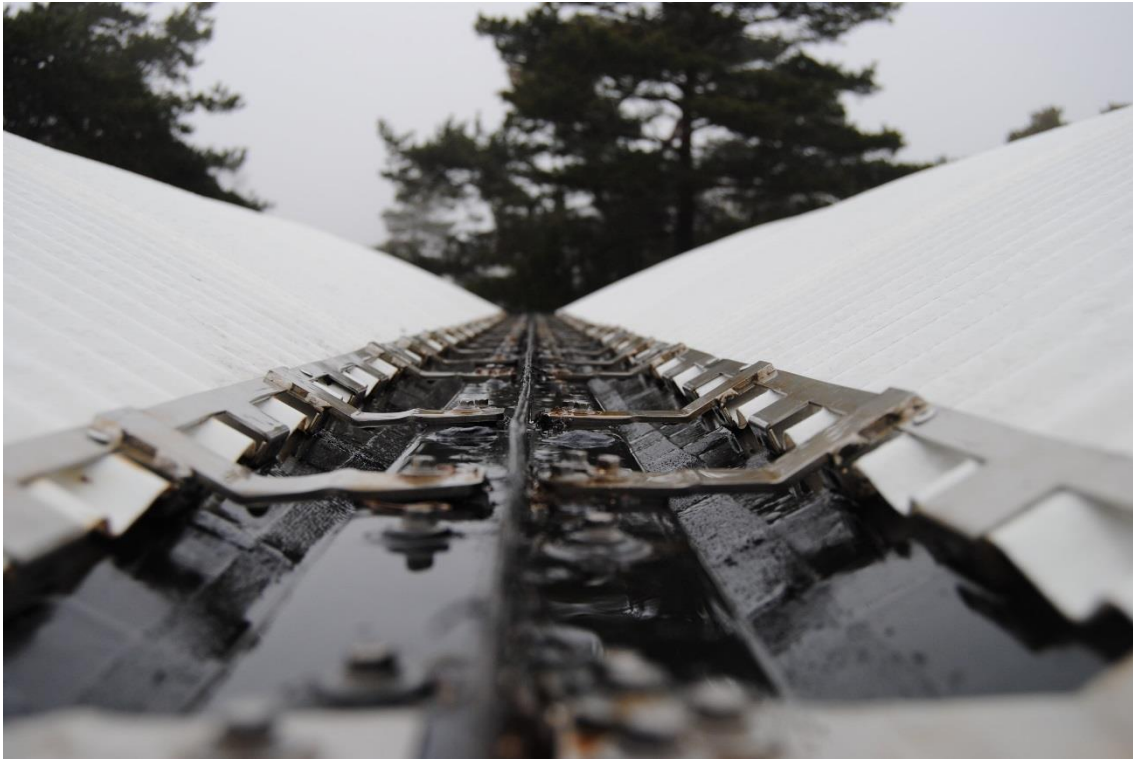
Tak färdigmonterat i nya infästningar.
