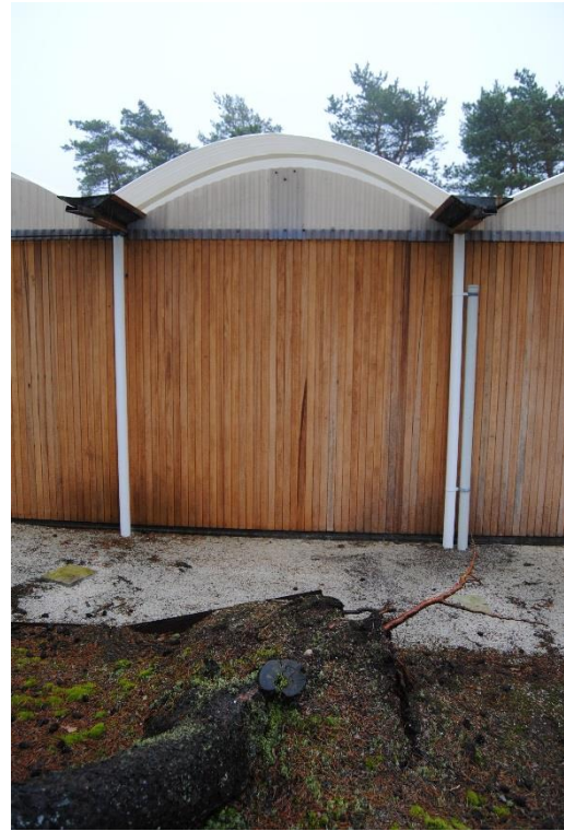
Byggnadens norra sida.
