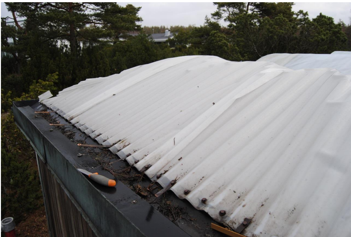
Taket på byggnadens nordvästra hörn under demontering.
