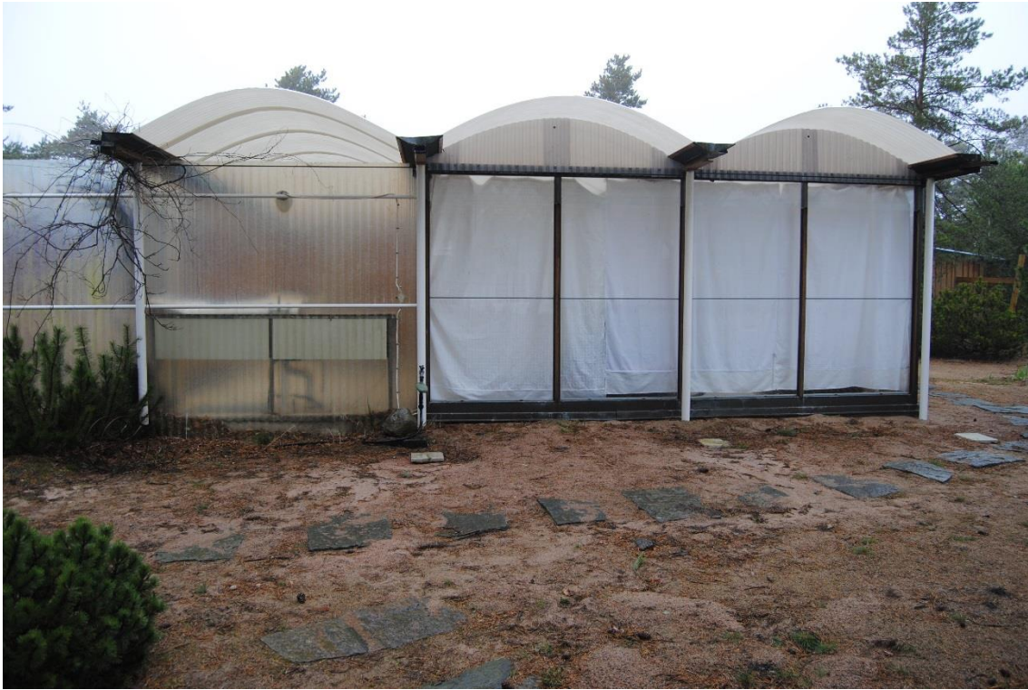
Nytt tak på byggnadens södra sida.
