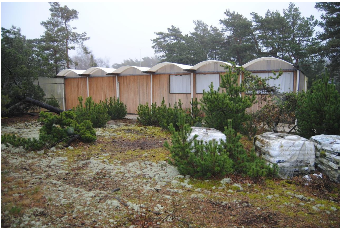
Det färdiga taket på norra sidan.
