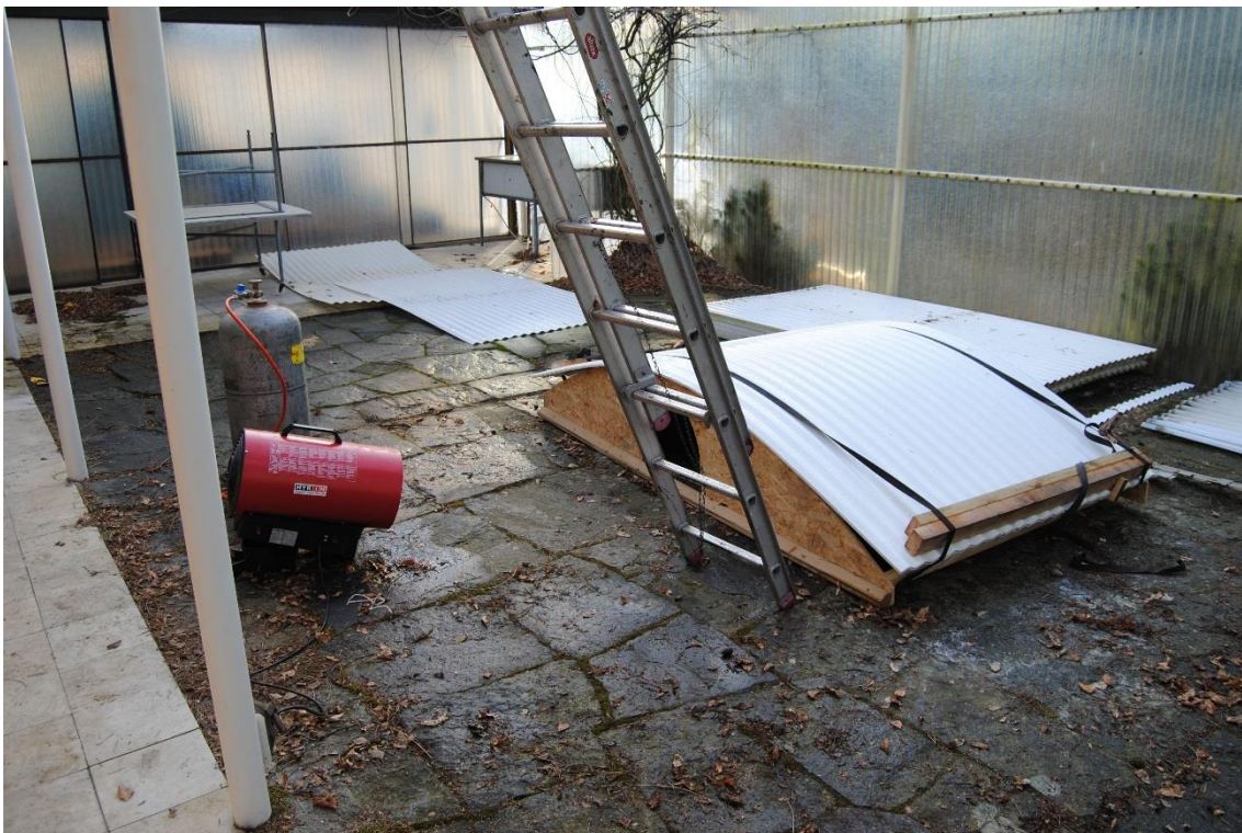
De nya takskivorna är hårdare och har bättre hållfastighet än de tidigare. För att lättare kunna böja dem under montering gjordes försök att värma dem med hjälp av gasolbrännare och en jigg.
