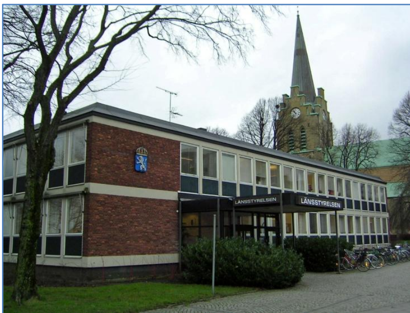
Landstatshuset mot öster. Det nuvarande entrépartiet ändrades och till- byggdes 1990.
