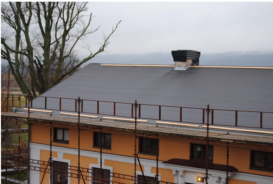
Ny underlagspapp på norra sidan.
