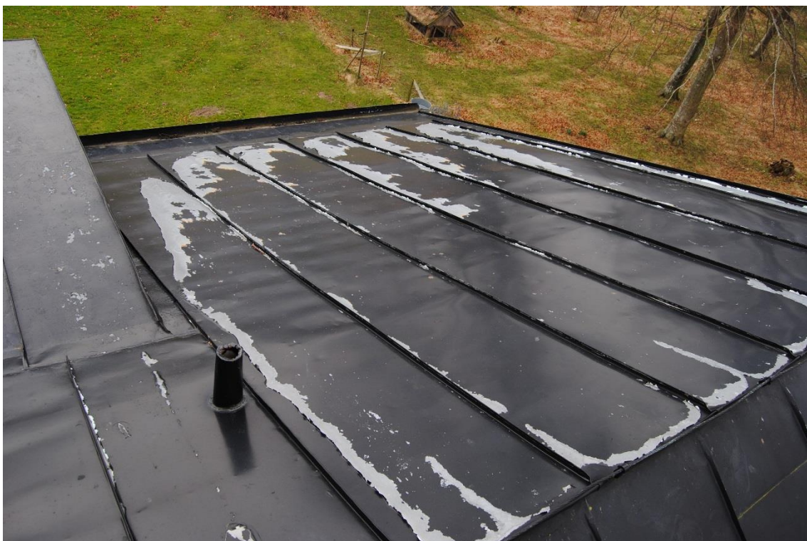
Södra takfallet med bandtäckning med förmålad plåt, innan föreliggande omtäckning.
