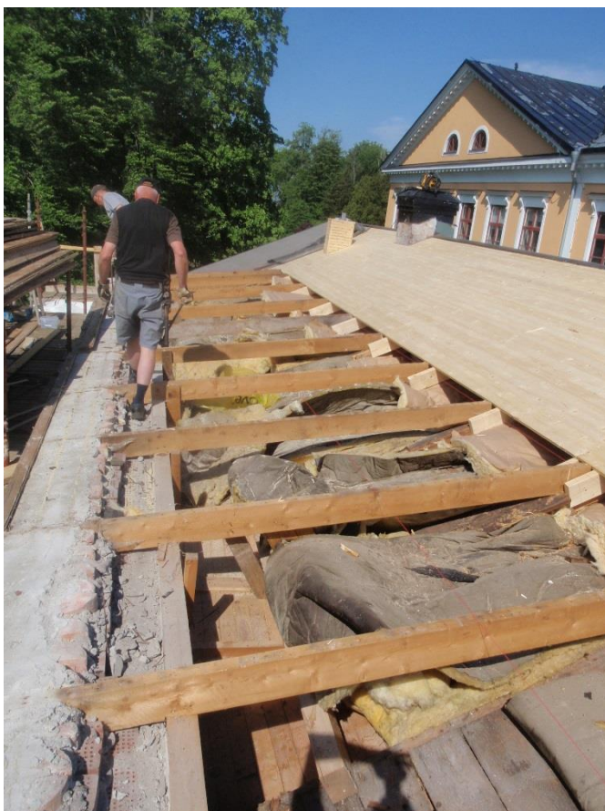
Ny panel läggs på södra takfallet (foto Pergus Bygg AB).
