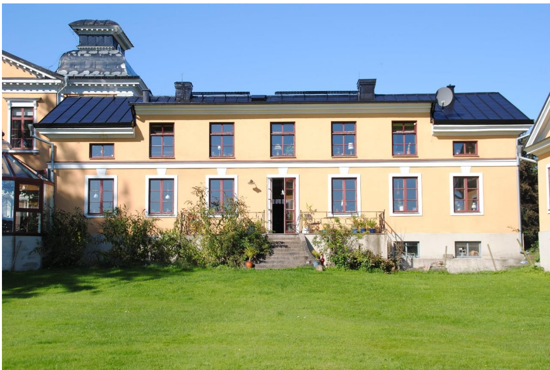
Det färdiglagda taket på södra sidan.
