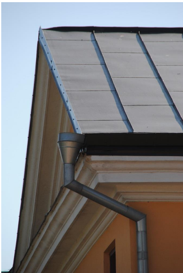
Tidigare utbytt stuprör på flygelbyggnadens nordöstra hörn, efter takomläggningen.
