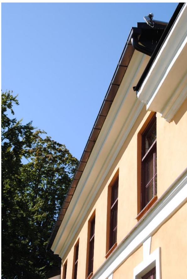
Ny fyrkantsränna på kupan på södra sidan.
