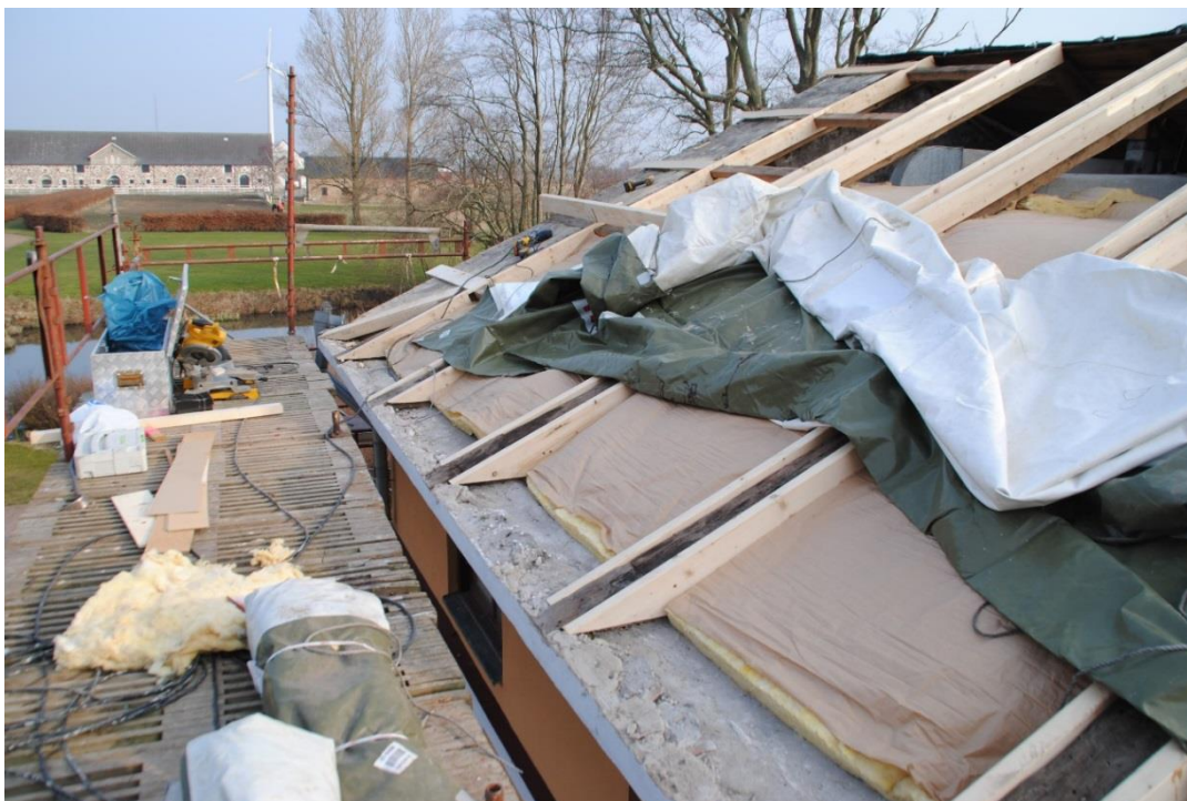
Demontering och lagning på norra sidan. (foto Charlotte Skeppstedt, Kulturmiljö Halland).
