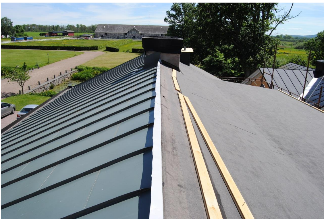
Det norra takfallet med ny täckning till vänster i bild.
