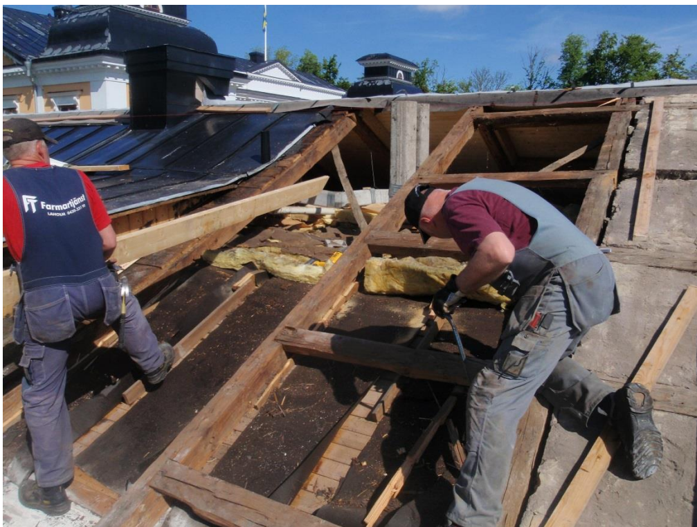
Demontering på södra takfallet (foto Pergus Bygg AB).
