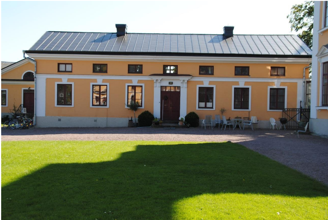
Det färdiga taket från norr.
