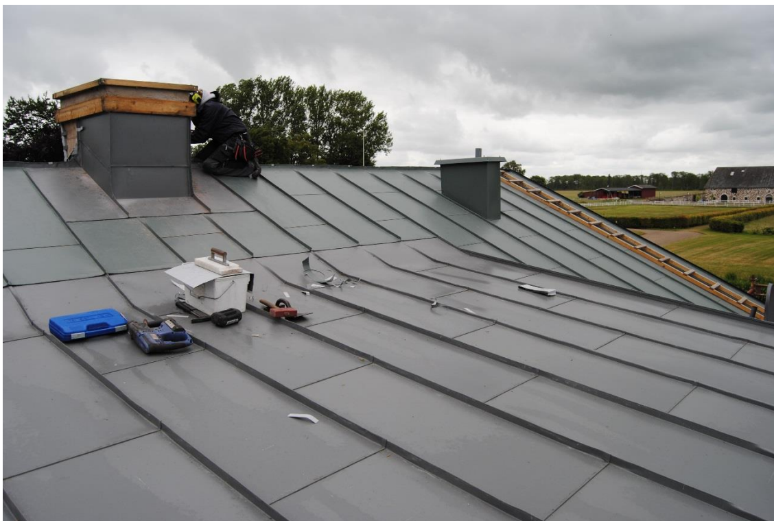
Södra takfallet med ny plåt.
