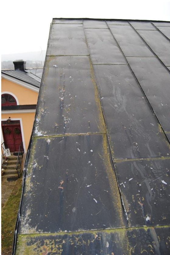
Norra takfallet med skivtäckning, innan föreliggande omtäckning.
