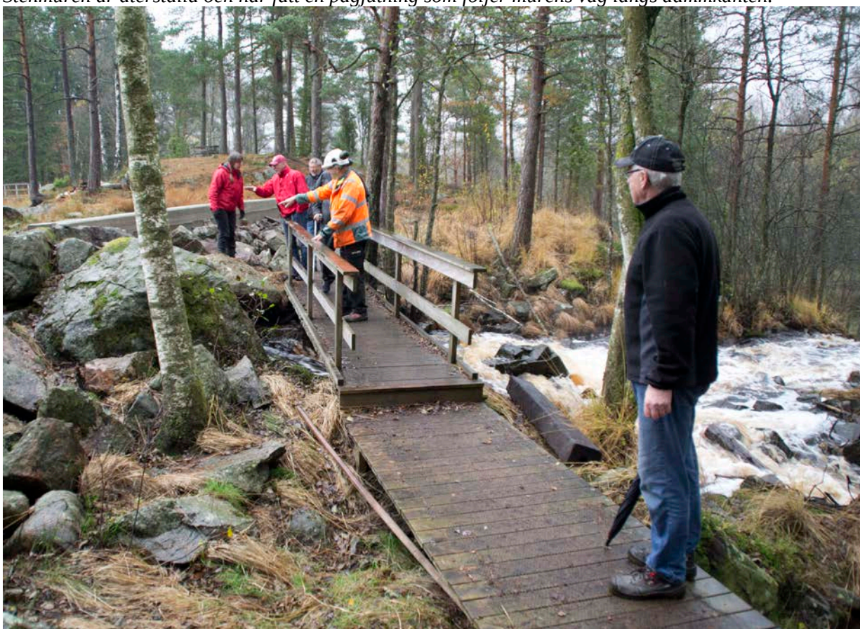
Slutbesiktning av vallen (till vänster) med fallet nedanför (till höger).
