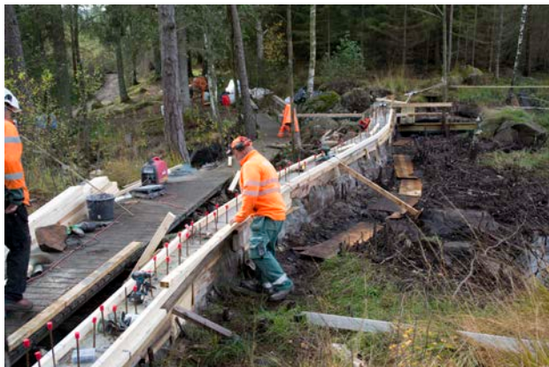
Stenmuren har återskapats och en träform byggts ovanpå för gjutning av betongvall.
