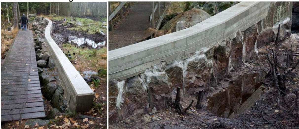
Stenmuren är återställd och har fått en pågjutning som följer murens väg längs dammkanten.
