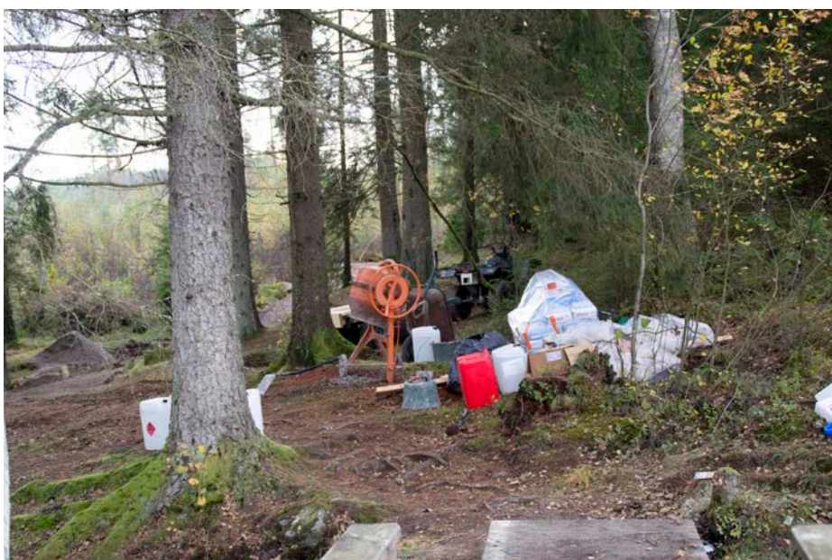
För att kunna forsla materialet uppför den branta sluttningen byggdes en liten grusväg, vilken skymtar mellan träden bortom byggarbetsplatsen
