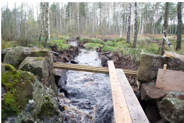
Stenmuren har återskapats och en träform byggts ovanpå för gjutning av betongvall.
