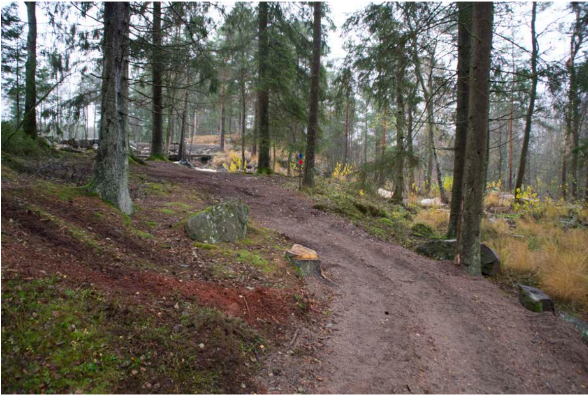
Den nya vägen upp till dammen.
