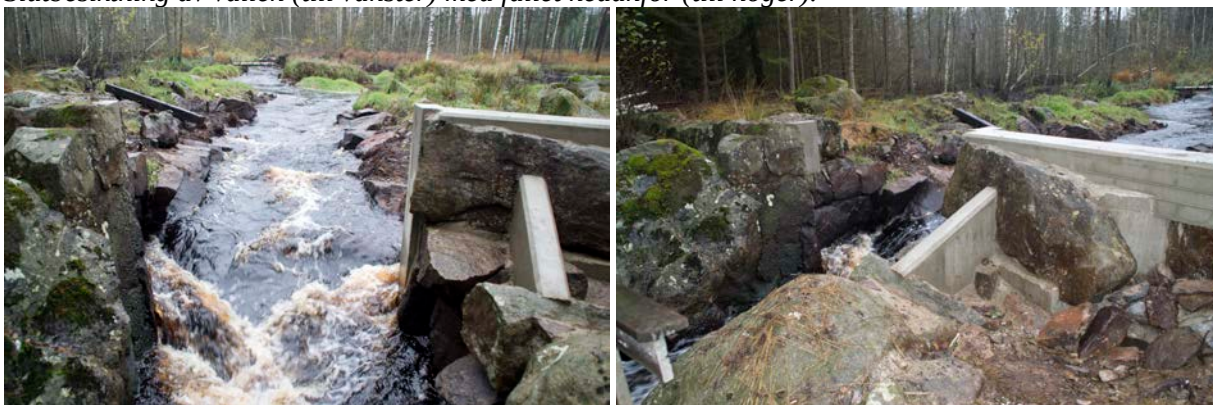
Öppningen i vallen är nu iordningställd för att en dammlucka ska kunna återskapas på platsen, för att det åter ska kunna bli en damm ovanför fallet.
