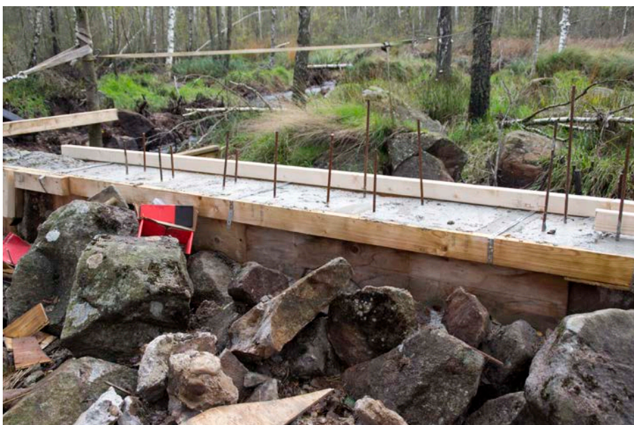
Betongvallen ska armeras för att stå emot vattnets krafter.
