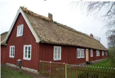
Halmtaken på bostadslängans norra sida samt östra längans östra sida, södra delen, före omläggning.
