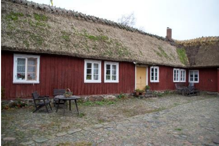
Fasaden på bostadslängan mot gården var rötskadad.
