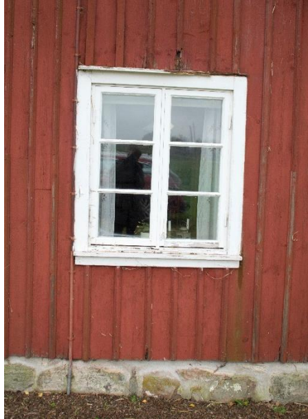
Fasaden på bostadslängan mot gården var rötskadad.
