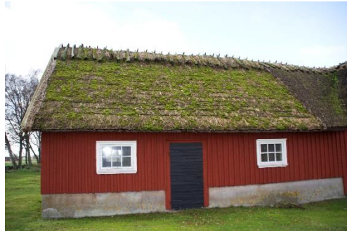
Halmtaken på bostadslängans norra sida samt östra längans östra sida, södra delen, före omläggning.
