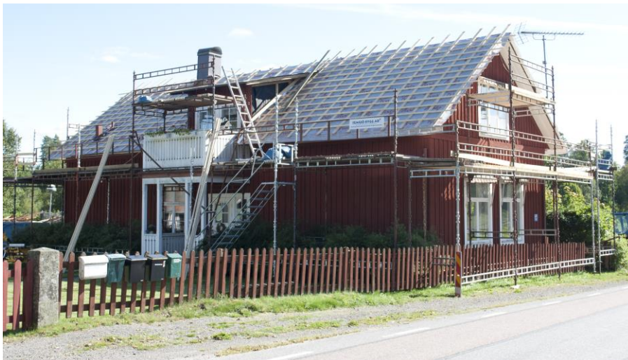
Taket läggs om, har täckts med underlagspapp och läktats.
