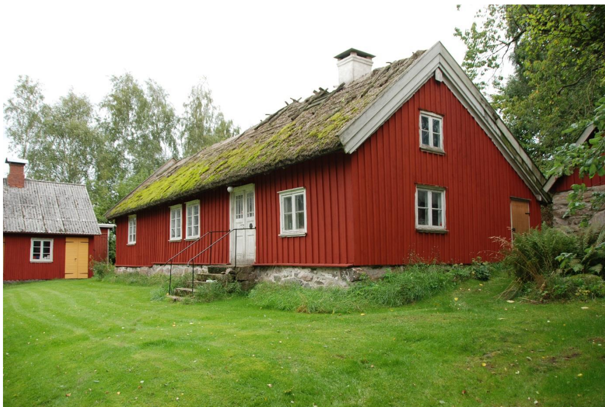
Manhuset före renoveringen med uthuset till vänster i bild.
