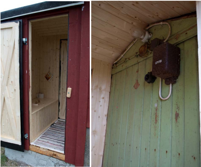
Det lilla utedasset söder om södra längan har i stort återskapats, på samma grund, med innerväggen bevarad. Det är byggt på samma sätt som tidigare, med två ingångar.
