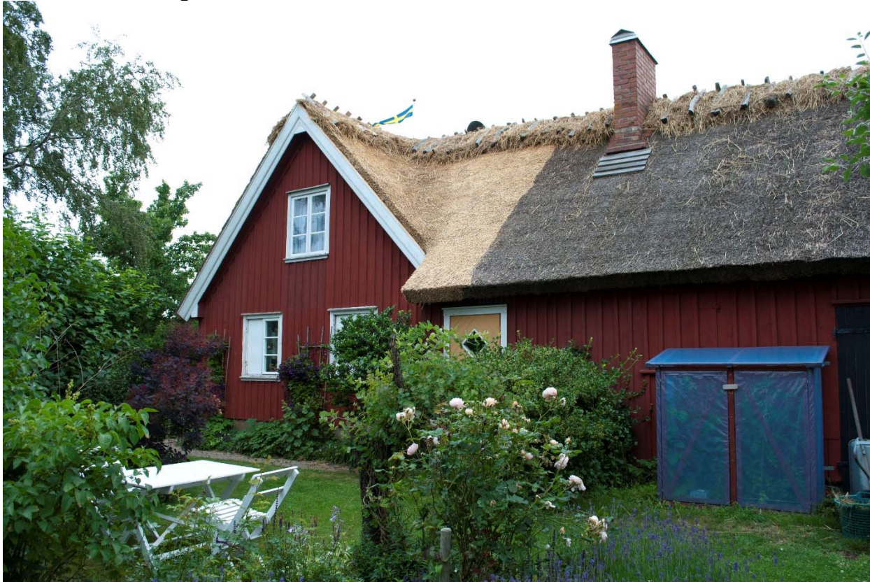
Rännan mellan bostadshuset och den västra längan har lagts om.
