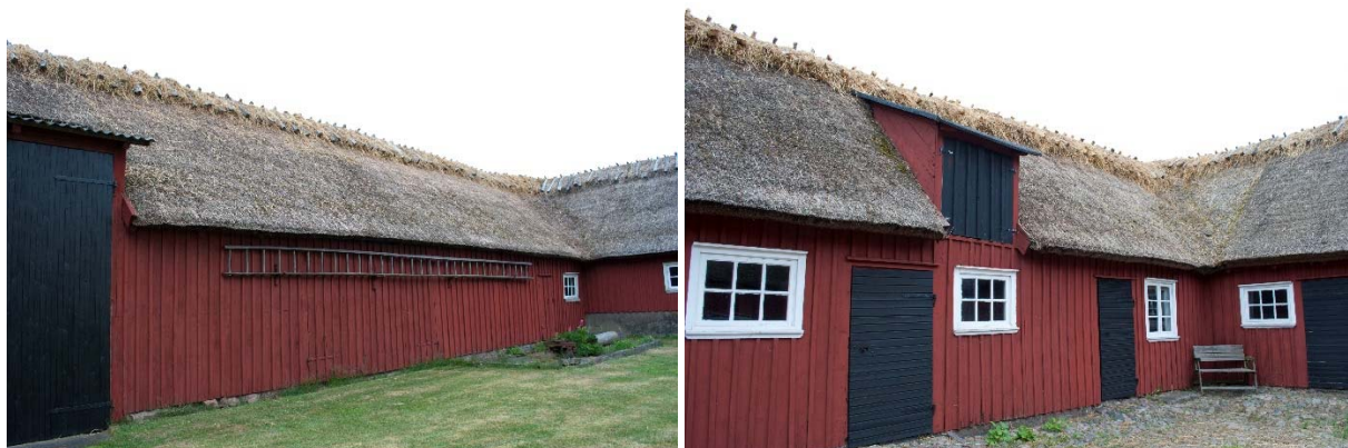
Större delen av taken har fått ny ryggning. Här södra längan mot söder och mot gården.
