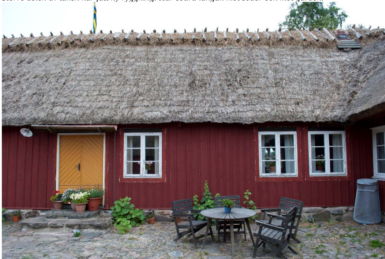
Bostadslängan mot gården har fått ny ryggning. Fönsterrenovering pågår varför fodren saknas. Uppe till höger syns resterna av den sönderblåsta skorstenen, vilken föreningen har för avsikt att återskapa.
