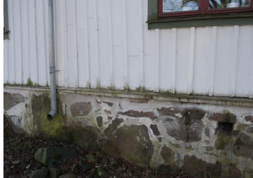
F f a var dropplisten vittrad och på norra sidan även rötskadad.
