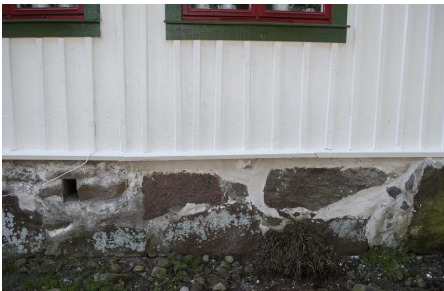
En bit av dropplisten fick bytas på norra sidan, liksom lite av panelen.
