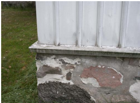
F f a var dropplisten vittrad och på norra sidan även rötskadad.
