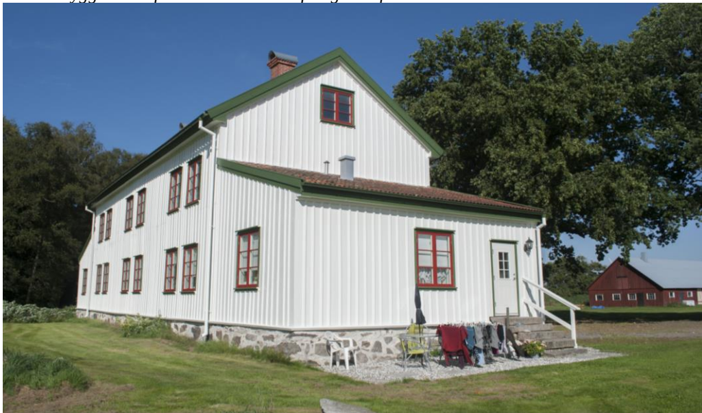
Manhusbyggnadens baksida och östra gavel, efter genomförda arbeten.
