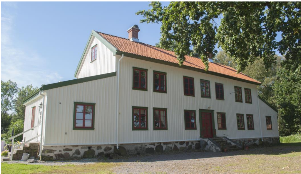
Manhusbyggnadens framsida mot norr efter genomförda arbeten.
