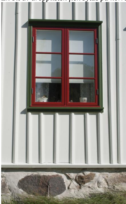
Fönstren har också målats om och en stor del av kittet fick bytas på södra sidan. Hängrännor och stuprännor har nu målats.
