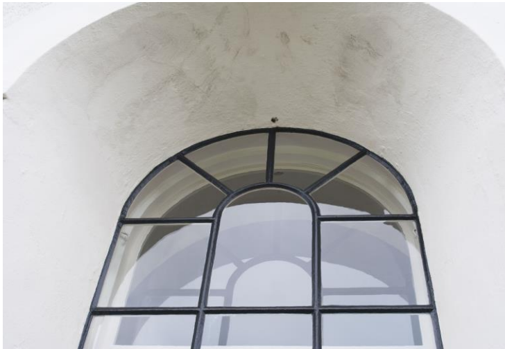
Detaljer av de nyrenoverade fönstren. Det kan ännu dröja en period innan fukten i murarna torkat ut.
