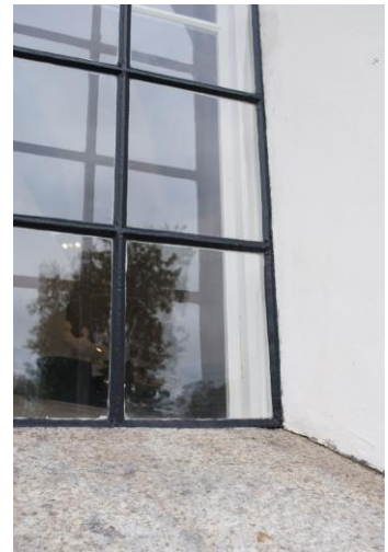
Detaljer av de nyrenoverade fönstren. Det kan ännu dröja en period innan fukten i murarna torkat ut.
