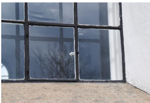
Detaljer av skadorna på fönstren. Den svarta färgen på bågarna är nästan borta i de nedre delarna – kitt och den röda rostskyddsfärgsyns tydligt.
