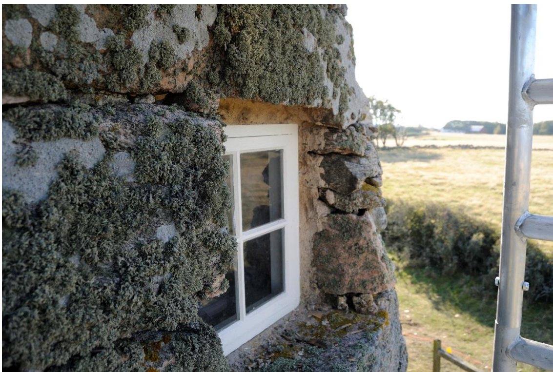
Fönster mot norr efter målning. Muren har ännu ej fogats. Stora delar av stenen på norrsidan var täckt av lavar och alger.
