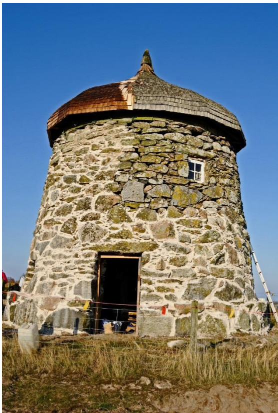
Oktober 2015. Fogning och spåntäckning pågår samtidigt.
