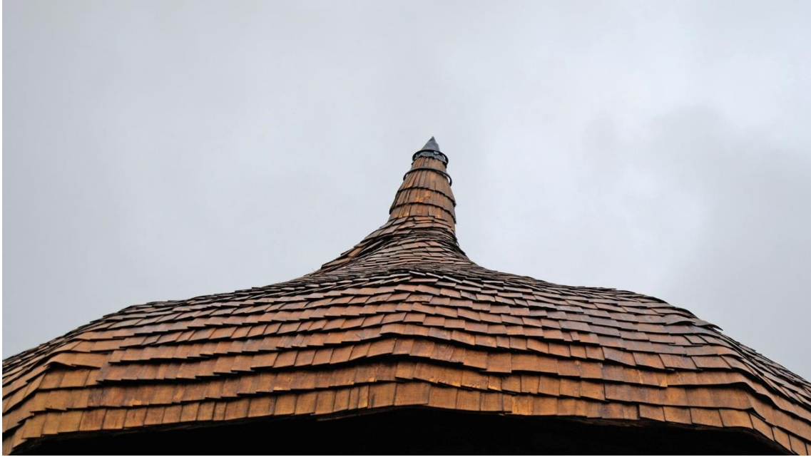
Hättan efter omtäckning. Spånen har strukits med Roslagsmahogny.
