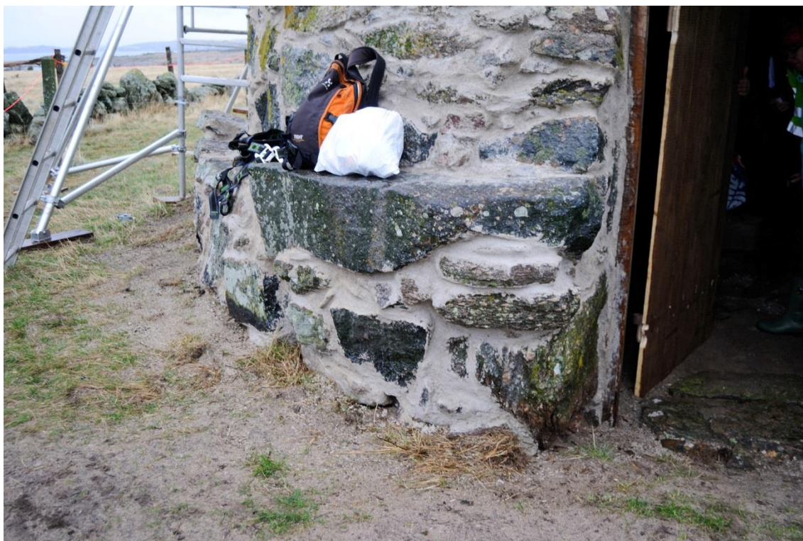
Efter restaureringen. Ett par nya stenar har ersatt den förlorade delen.
