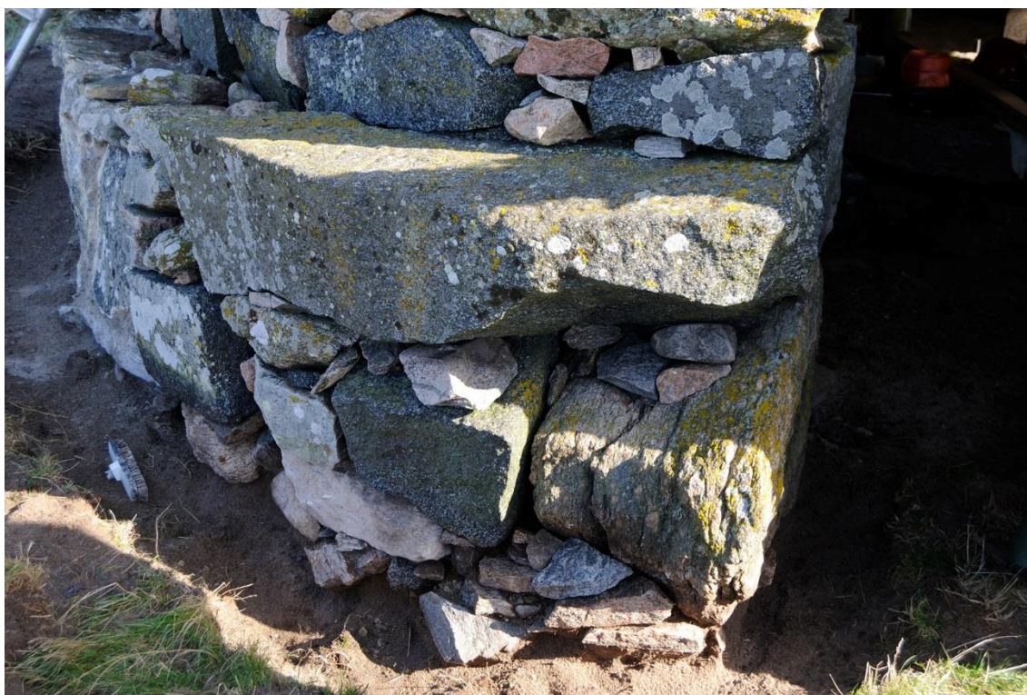
Hörnstenen vid västra ingången, före restaureringen. Den nedre delen har någon gång, troligen genom frostsprängning, gått förlorad.
