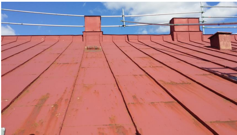
Skorstenarna samt en ventilhuv på takfallet på gårdshuset.
