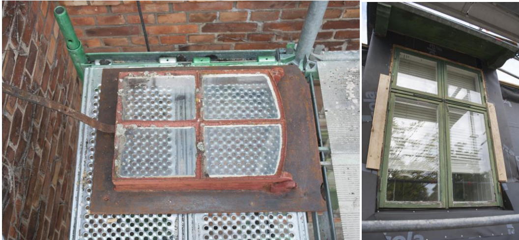
Takfönstret i gjutjärn togs ned och renoverades. Fönstren i takkuporna behölls, men en del material runt kuporna fick bytas och förstärkas.
