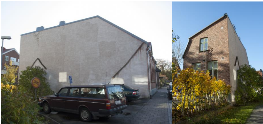
Brandgaveln har fått behålla sin silhuett trots att skorstenarna idag saknar funktion.
