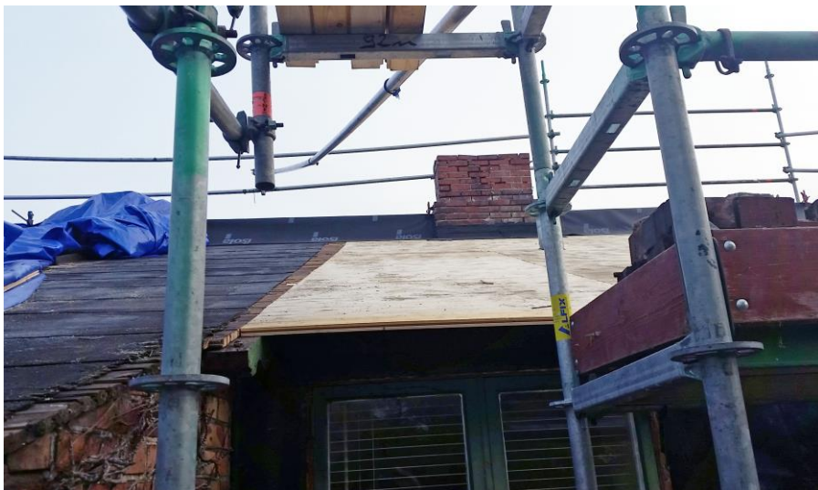
En stor del av råsponen fick bytas på takfallet på gårdshuset. Foto: Magnus Nord, Erlandssons Bygg AB.
