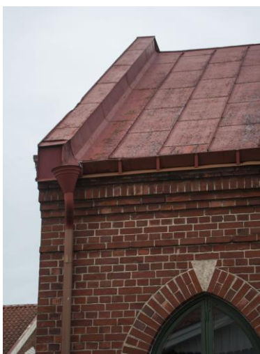
Färgen flagnade från taket, men i övrigt var det svårt att med blotta ögat se att taket var dåligt.
