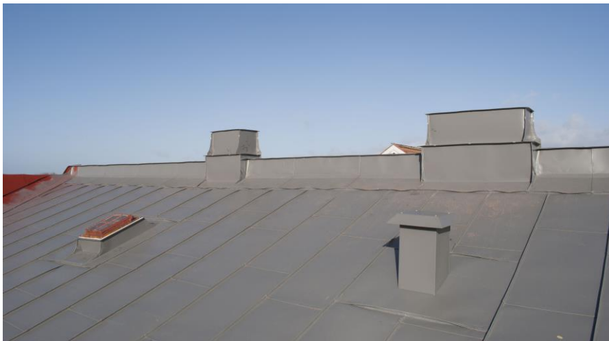
Skorstenarna har åter klätts in i plåt, då de var av sentida modell, saknar funktion. Det lilla takfönstret är återplacerat på sin plats.
