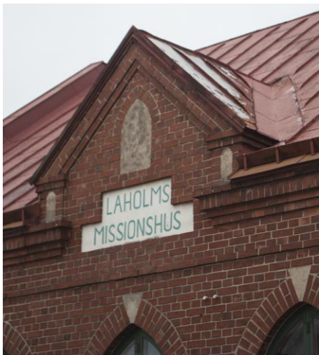
Färgen flagnade från taket, men i övrigt var det svårt att med blotta ögat se att taket var dåligt.
