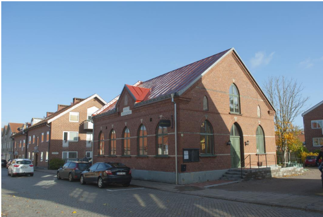
Missionshuset sett från Ryssgatan. Takfallet mot gården är målat och färdigt.
