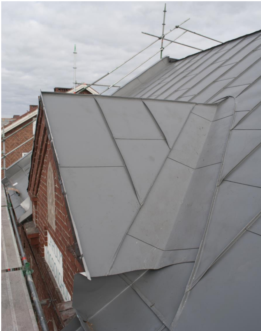
Taket lades på samma sätt som tidigare, falsad slätplåt, men med en förprimad plåt.
