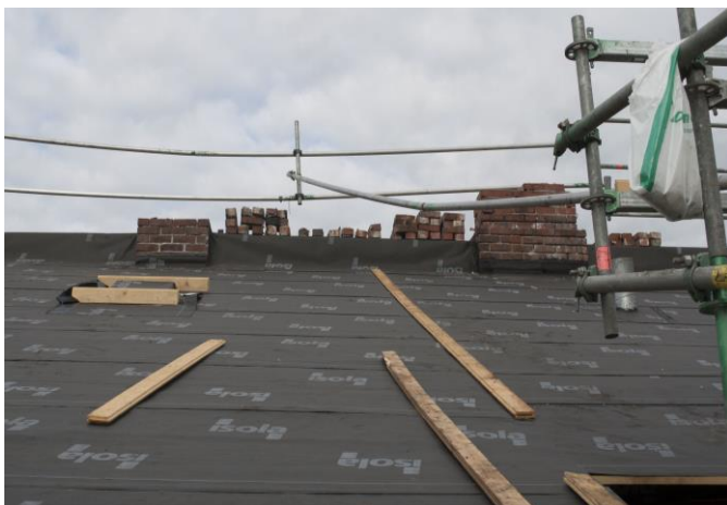
Skorstenarna togs ned till fast mur.
