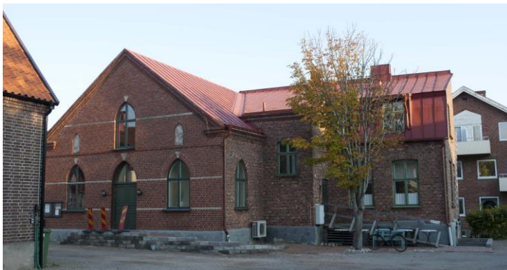
Missionshuset är byggt i vinkel med ett gårdshus med brutet sadeltak.
