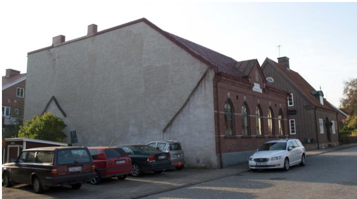
Den norra gaveln utgörs av en brandvägg där två skorstenar bryter taklinjen.
