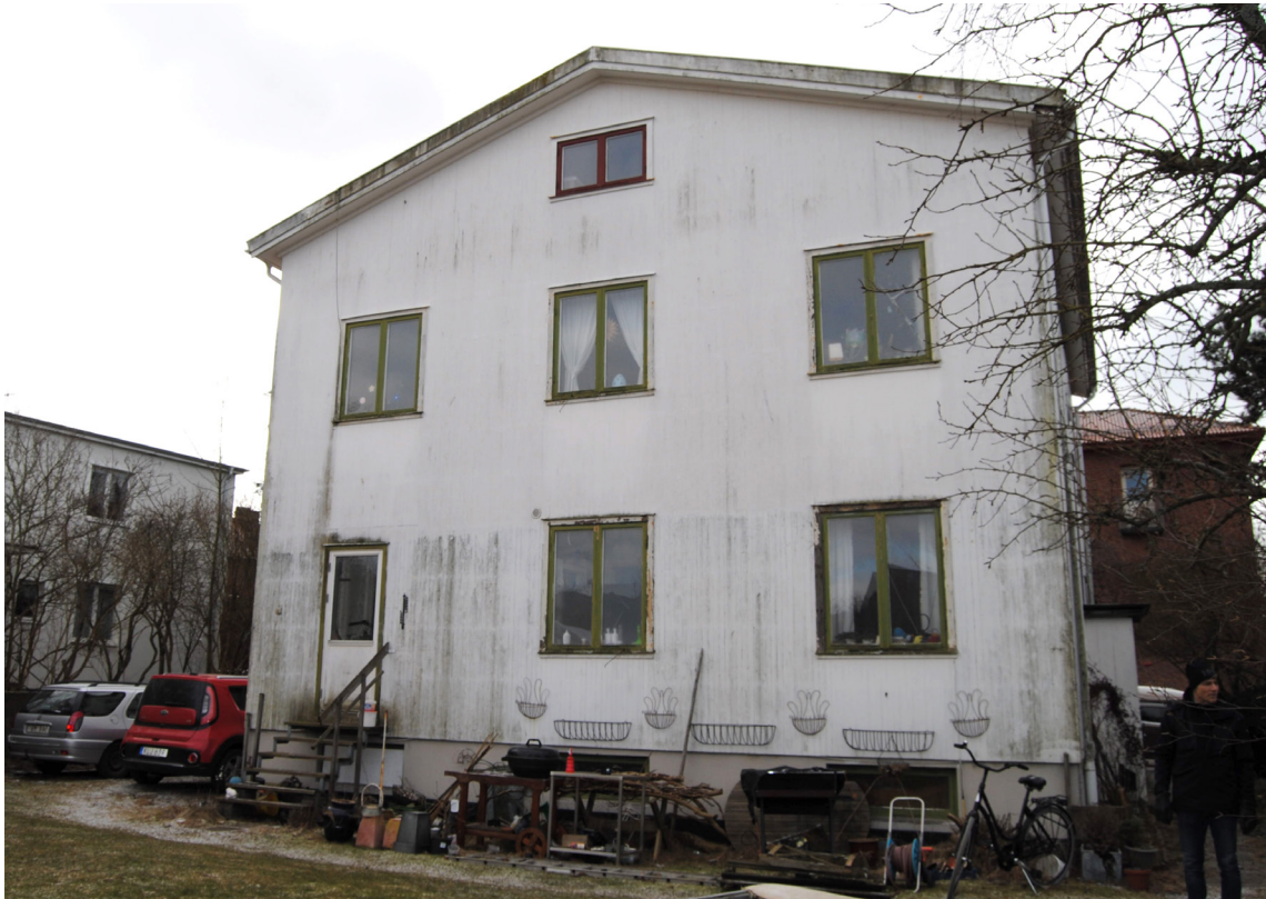
Byggnadens trädgårdssida, mot norr. en altandörr har tagits upp och ersätter ett fönster.
