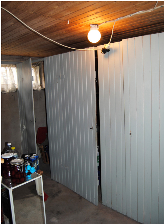
Platsbyggda förråd för varje lägenhet.
