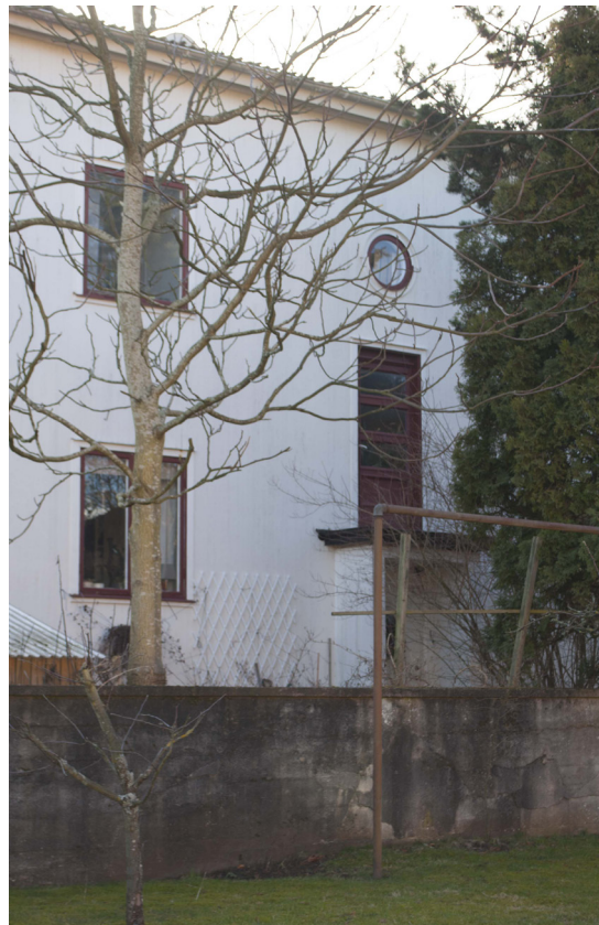
Entrén till byggnaden ligger mot väster. En liten balkong ovanför dörren har tagits bort men balkongdörren finns kvar.
