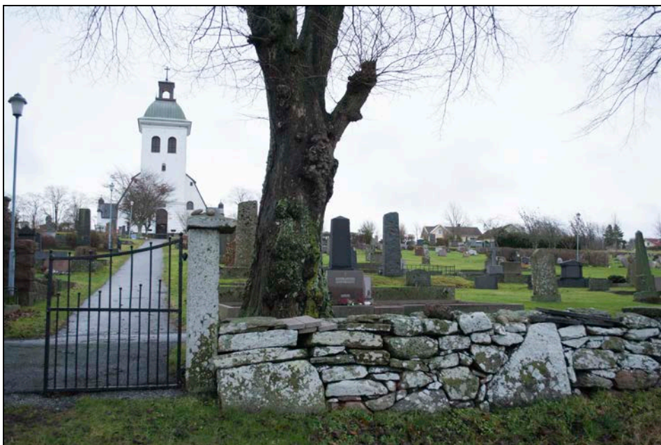
Den norra delen av muren närmast grinden var i något bättre skick än den södra, men hade sjunkit ihop en del.
