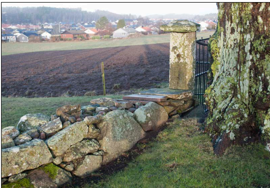
Den norra delen av muren närmast grinden var i något bättre skick än den södra, men hade sjunkit ihop en del.
