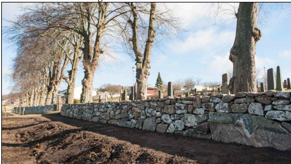
De stora stenarna har lagts i botten av muren.
