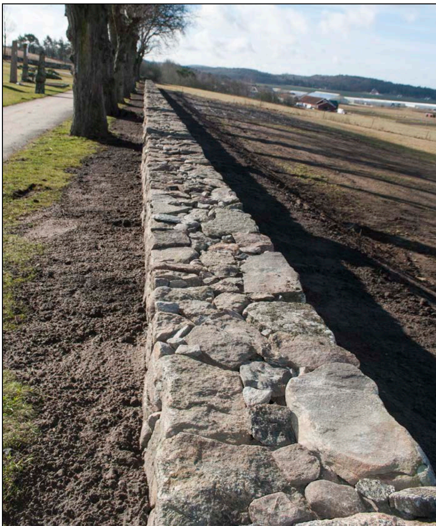
Ovansidan är nu rak och stabil. Trädkransen är intakt.
