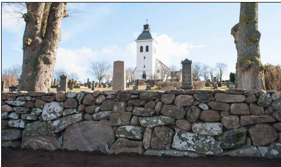
De stora stenarna har lagts i botten av muren.
