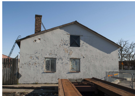
Södra gaveln med två bevarade tvåluftsfönster.
