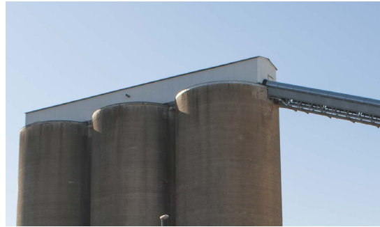
Det finns även ett transportband från kajkanten i väster som leder in materialet i silorna.
