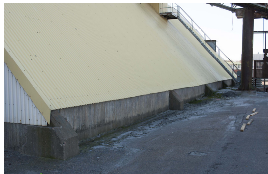
På de utskjutande betongplintarna vilar stålstommens balkar.
