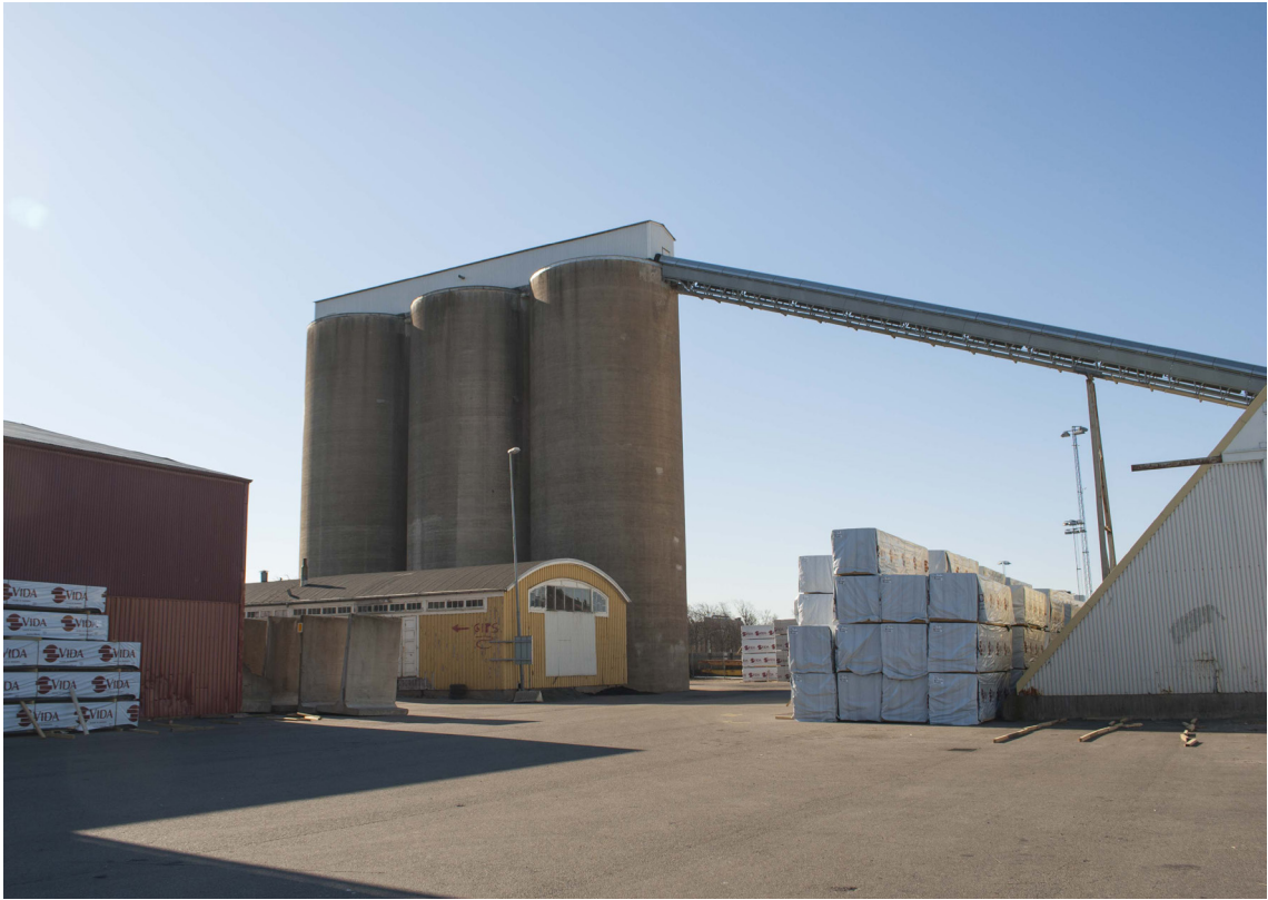
Varvshuset framför betongssilorna. Sandladan skymtar till höger.
