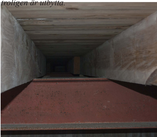
Varvshuset byggdes ursprungligen ute på Hooken men flyttades till nuvarande plats på 1950-60-talet. Trästommen vilar på stålbealkar som vilar på en gjuten betonggrund.
