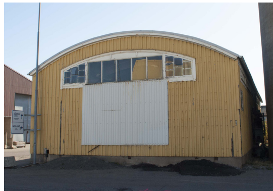
På gavlarna finns välvda småspröjsade fönster. De mittersta är utbytta till större glaspartier.
