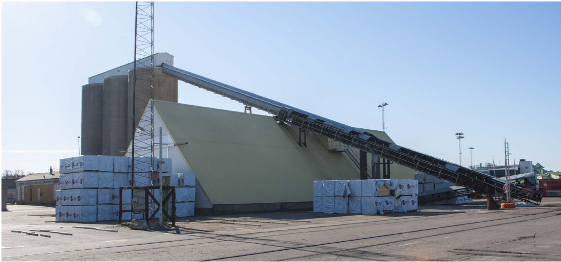
Sandladan med transportband till silon bakom.
