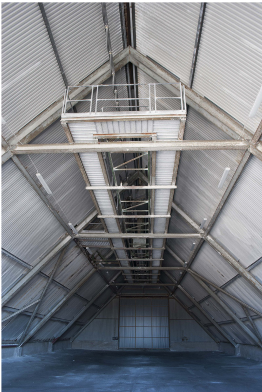
Byggnaden består av en betongsockel och en stålstomme klädd med korrugerad plåt, med stora skjutportar på gavlarna.
