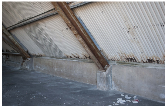
På de utskjutande betongplintarna vilar stålstommens balkar.
