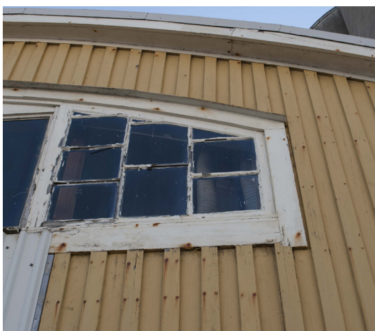
Gavlarnas spröjsade fösnter kan vara i originalutförande, medan mittenpariterna troligen är utbytta.
