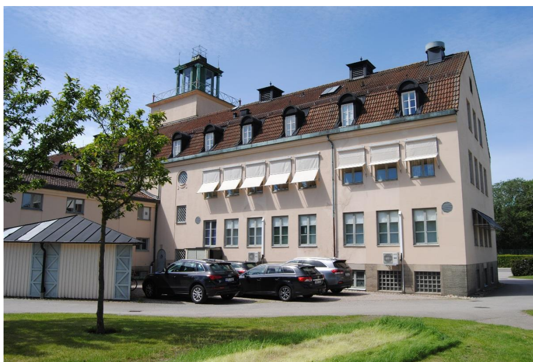
Sydöstra fasaden där tillbyggnaden är tänkt att placeras.
