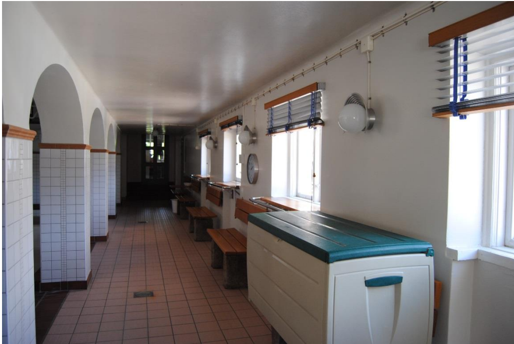
Gång längs bassängens sidor. Fönsterna bildar ljusinsläpp i simhallen.
