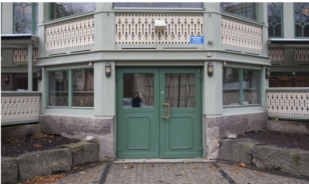
Dörrar och fönster avses bytas till mer anpassade. Även fönster vid sidan av den utskjutande verandan avses bytas.
