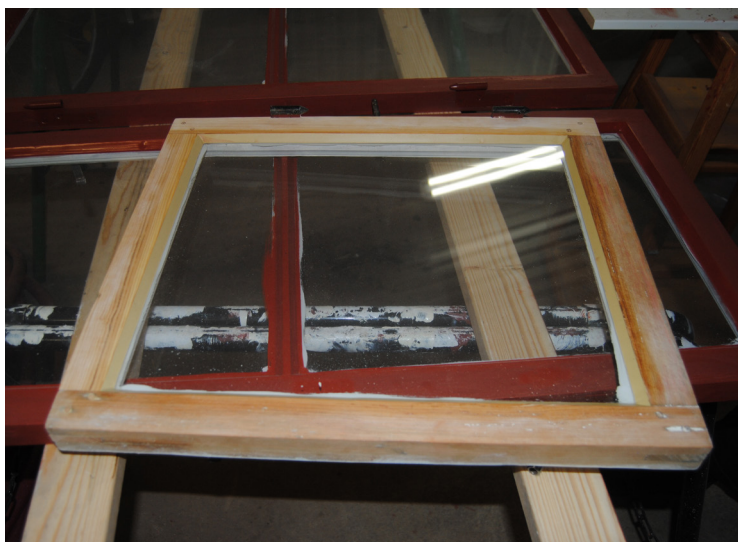
Ovan: Fönsterbåge som rengjorts från färg och kittats om. T.h: Här syns en av de trälagningar som utförts på bågarna där nytt trä fogats in. Större sprickor har fyllts i med linoljekitt.
