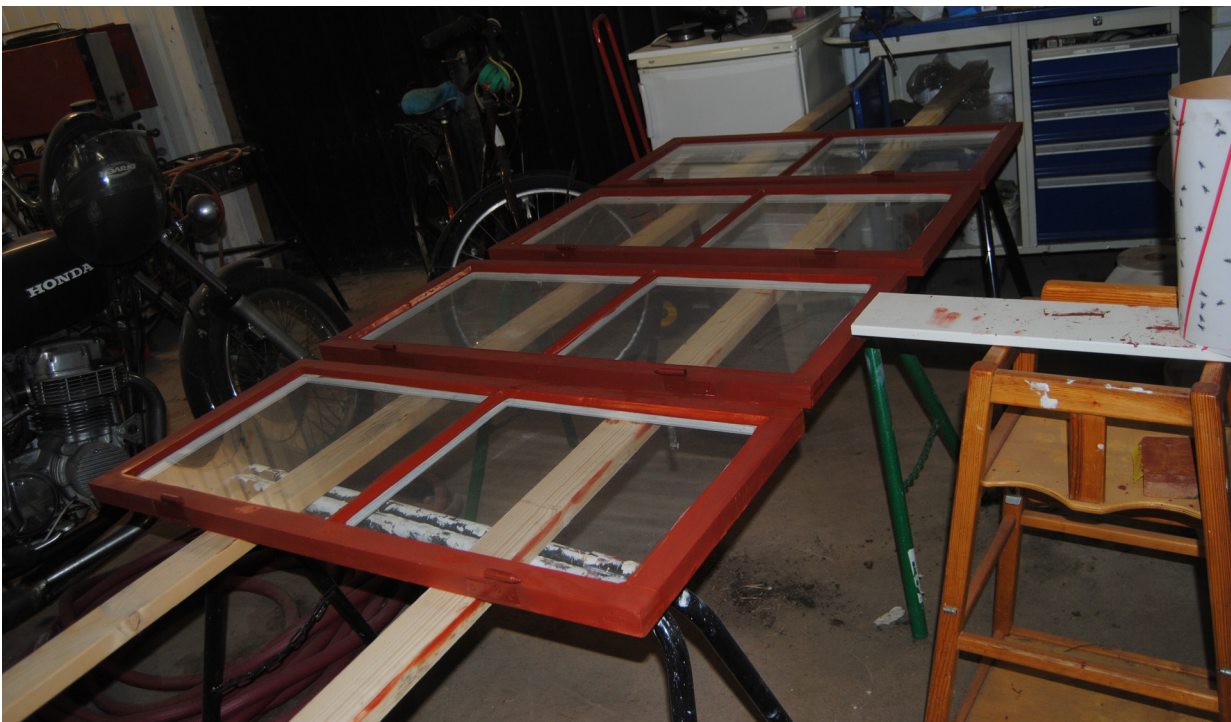
Ovan: Färdigrenoverade fönster på plats vid mejeriets gavel. Nedan: Målade fönsterbågar som ej hunnit hängas upp på plats.
