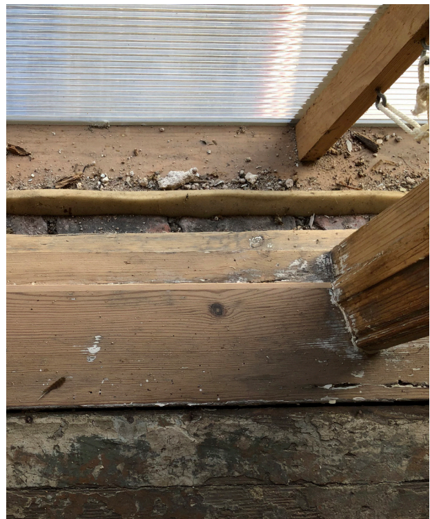
Karm som rengjorts från färg. I mitten av bilden syns en trälagning mot kanten där båge möter karm.
