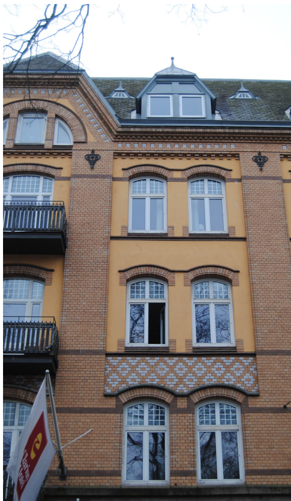
Fasaden mot Norra vägen har en detaljrik och påkostad utformning. Utmärkande är t.ex. de mönstermurade partierna.
