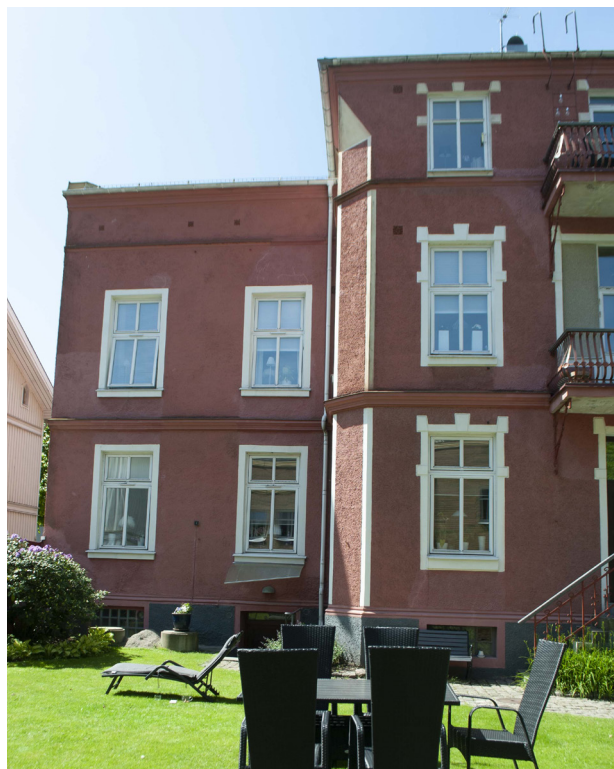
Trapphusets fönster har en mer dekorativ omfattning än fönstren på den ursprungliga fasaden.
