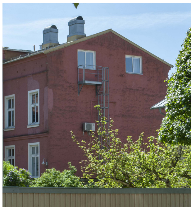
Gavlarna är slätputsade med fönster endast på vindsvåningen. Mot norr är fönstren relativt sentida. Det flacka sadeltaket är täckt med slätplåt.
