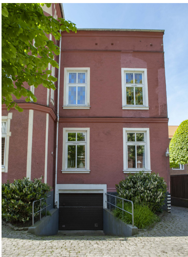
I den norra delen finns en relativt sentida garagedfart till källaren. Gården är belagd med smågatsten.
