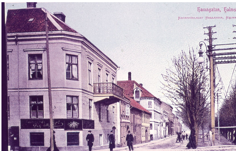
Här syns byggnaden med sin ursprungliga fasadutformning. Taket är täckt av tegel och fönstren är korspostfönster. Foto: Hallands konstmuseum.
