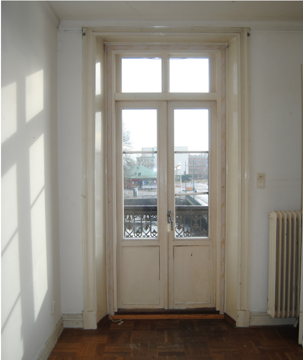
Balkongdörren. Dörrfoder är ursprungliga men dörren har ersatts av en modernare variant, med liknande indelning som originalet.
