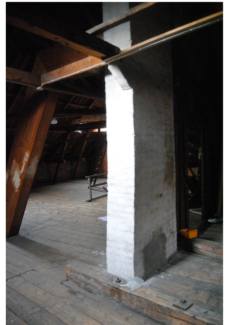
På vinden syns murstockarna och takkonstruktionen är synlig.
