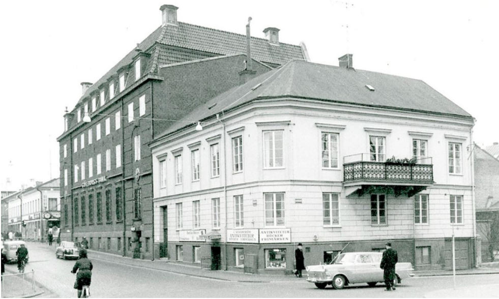
Här syns den fönsterutformning som tillkom på 1930-talet. Under en period hade byggnaden korrugerat plåttak, vilket syns på bilden.
