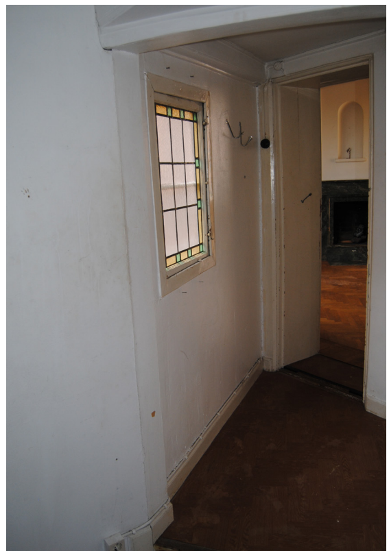
I gårdshuset finns små, enkla utrymmen med lågt i tak. Notera den blyspröjsade innerbågen.
