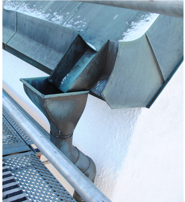
Koppartaket har fotränna, som i norr och söder avslutas med utkastare till stuprörens vattenkupa.
