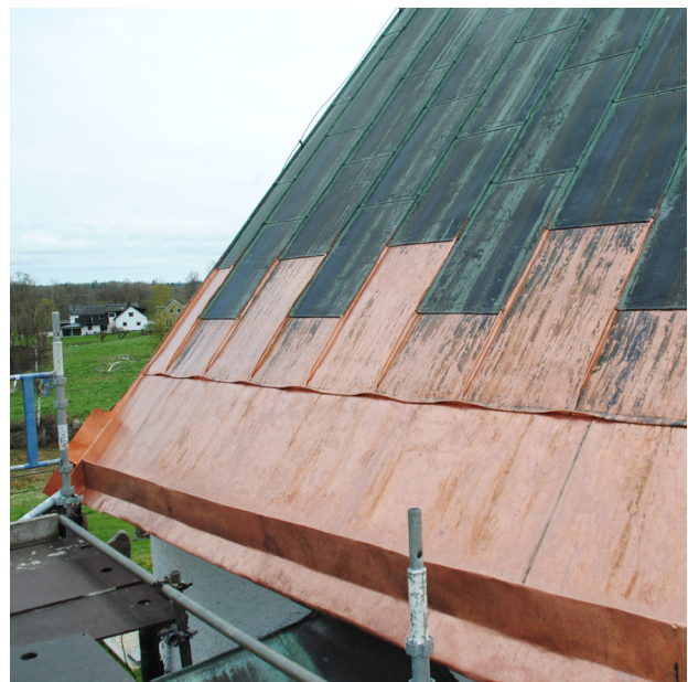
Nordöstra hörnet på takets norra sida. Det nya koppartäckningen som skarvats ihop med den gamla.
