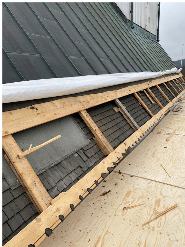
Under det nuvarande koppartaket finns ett tjärat spåntak.
