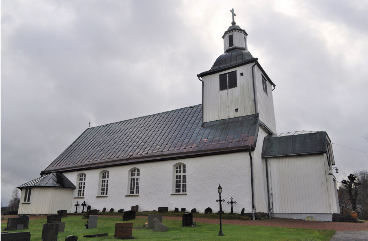
Kinnareds kyrka efter lagning och kontroll av takfoten på norra sidan. Efter en tid har den nya koppartäckningen mörknat och lagningen är inte längre lika påfallande.
