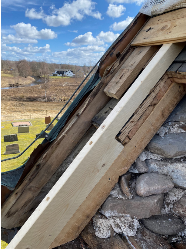
Takstolen mot muren har reparerats. En ny regel har lagts ovanpå det gamla undertaket för att komma upp i samma nivå som undertaket till koppartaket.
