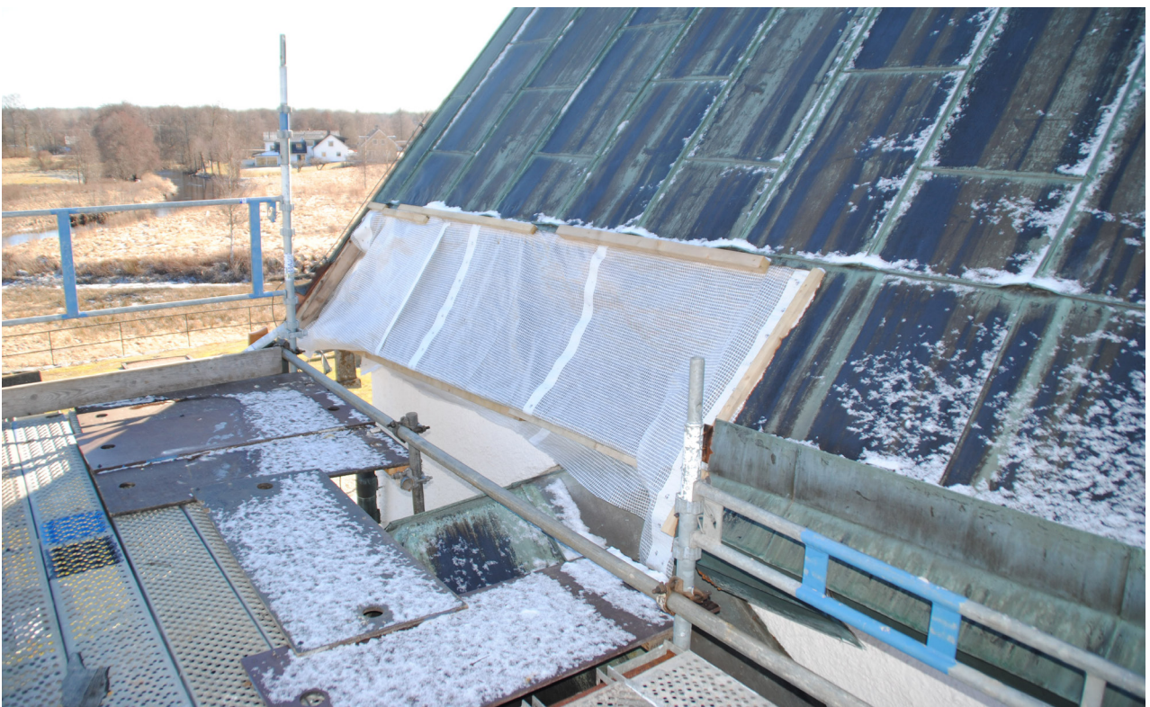
Den bit av takfoten som öppnades upp i slutet av 2020, för att undersöka takstol och remstycken.
