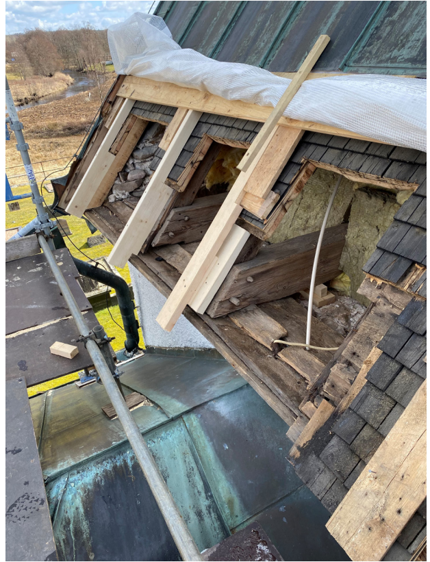
Koppartaket ligger på ett uppreglat undertak ovanpå spåntaket. Där de gamla reglarna tagits bort har nya lagts på.
