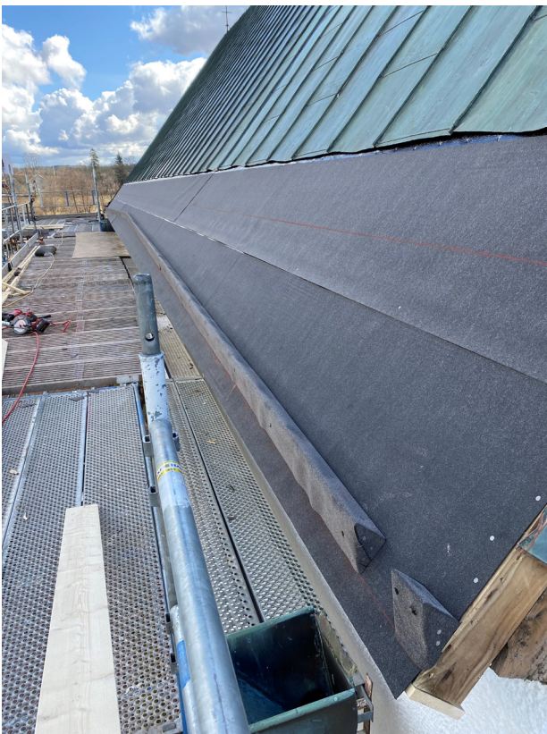
Ovanpå undertaket har ny underlagspapp lagts. Trästocken för fotrännan har också klätts in i papp.
