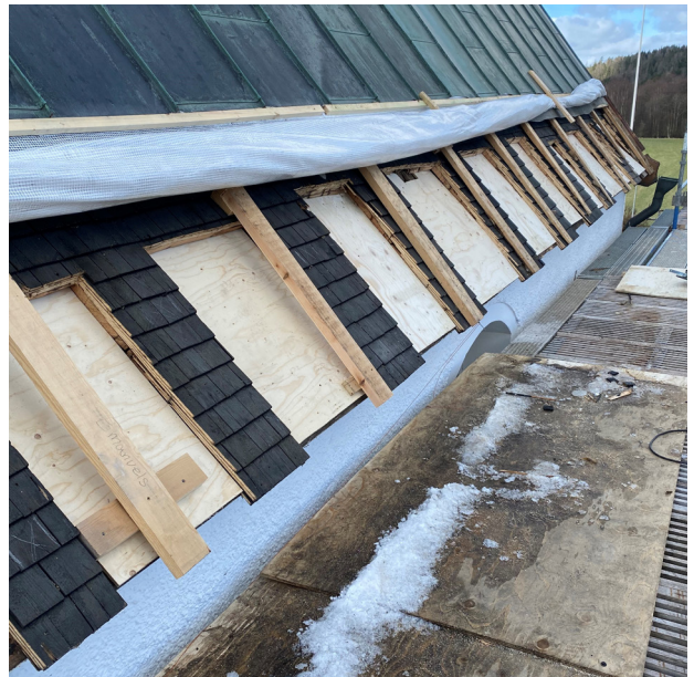
Ovan: Hålen längs takfoten har satts igen med plywoodskivor.
