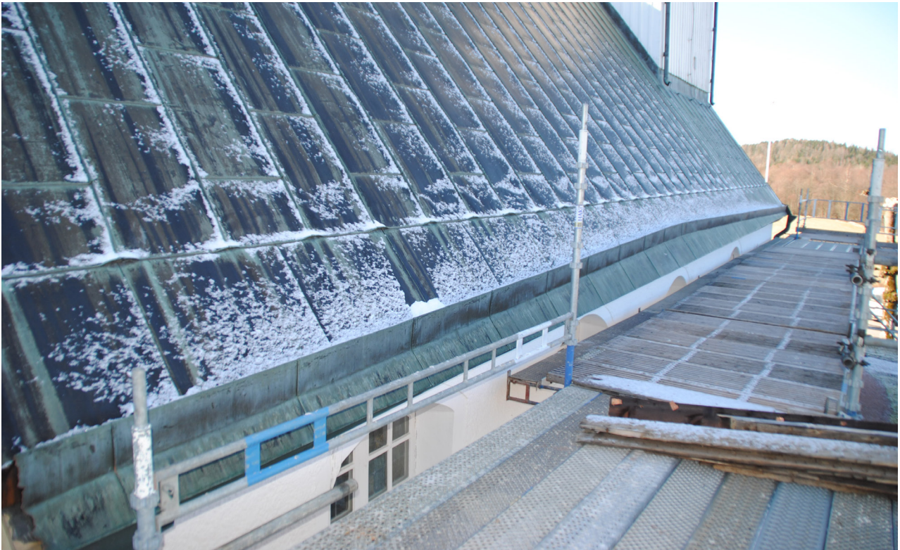
Nedre delen på koppartaket har fotplåt och fotränna. Fotrännan är som högst mitt på långskeppet och lutar mot gavlarna där utkastare och sturprören finns.
