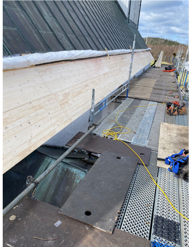
Ny råspont har spikats ovanpå reglarna för koppartaket.
