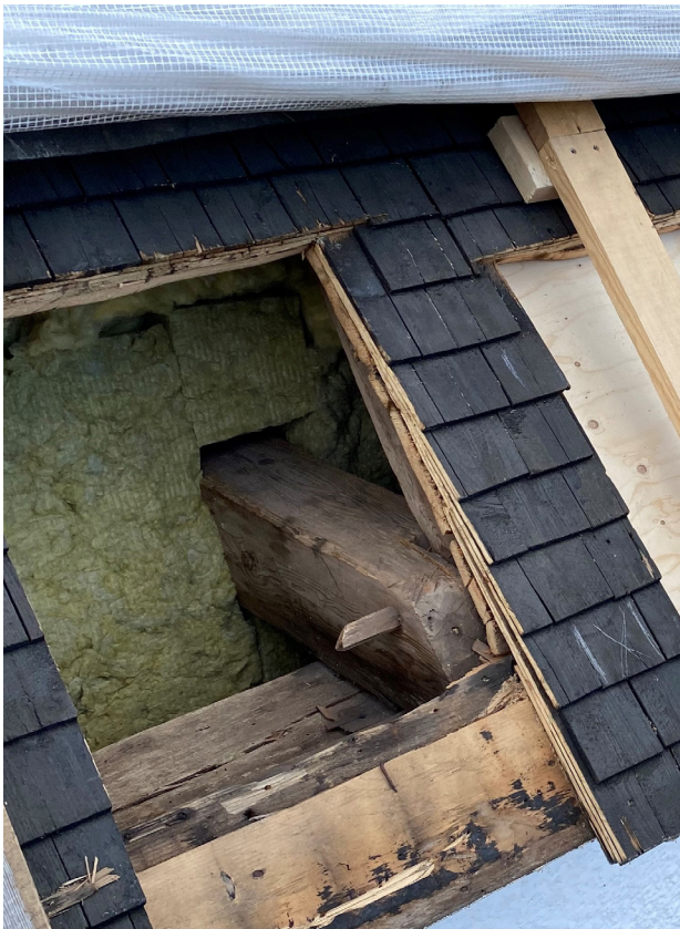
Takstolen mot muren har reparerats. En ny regel har lagts ovanpå det gamla undertaket för att komma upp i samma nivå som undertaket till koppartaket.
