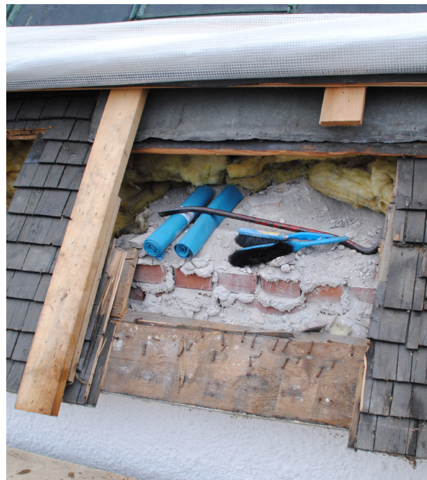
Mitt på långhustaket har det troligen funnits en skorsten som idag är kapad under taket.
