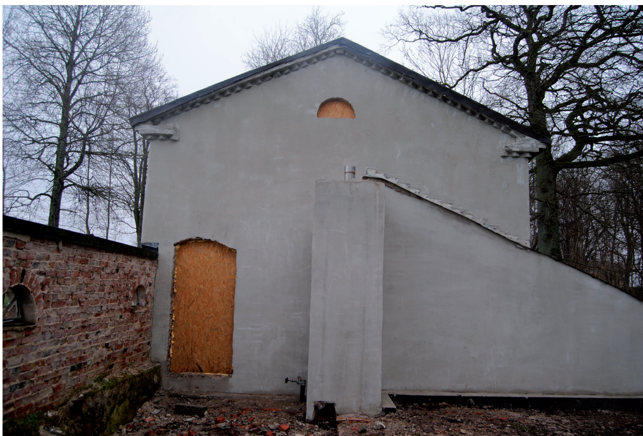
Östra fasaden under renoveringen.
