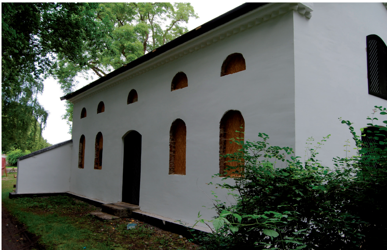
Den södra fasaden efter renovering. Montering av fönster kvarstår vilket omfattas av ett separat beslut från länsstyrelsen.
