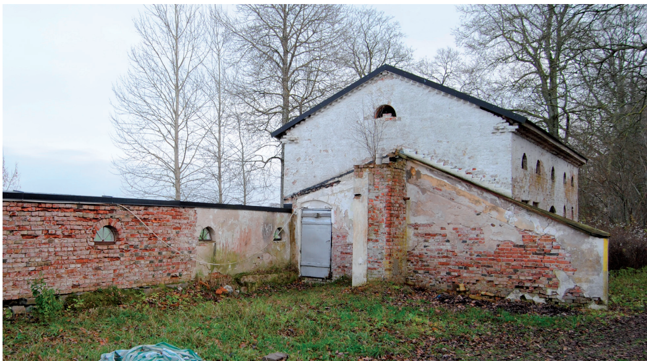
Östra fasaden innan renoveringen.
