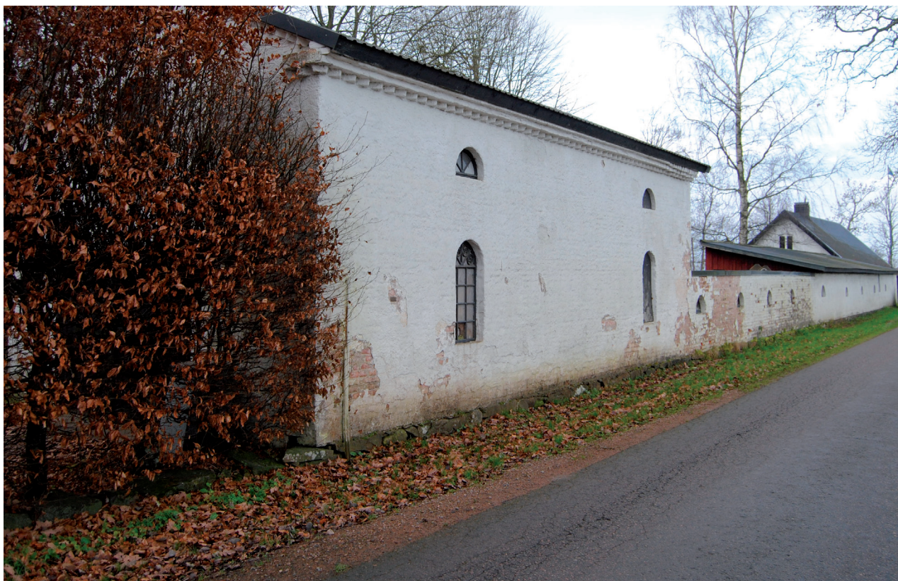
Norra fasaden innan renovering. Här syns det gamla gjutjärnsfönstret som fanns kvar och som nu använts som förlaga/mall inför tillverkning av nya gjutjärnsfönster.
