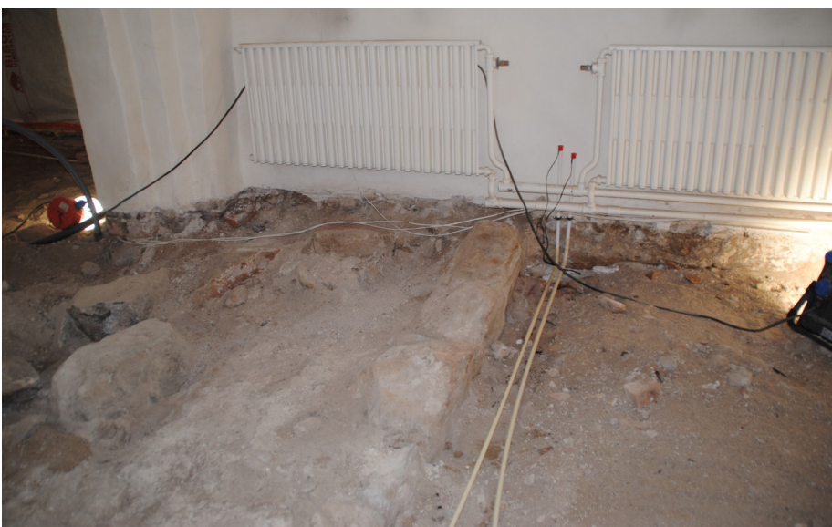
Elledningar intill den funna västmuren på södra sidan.
