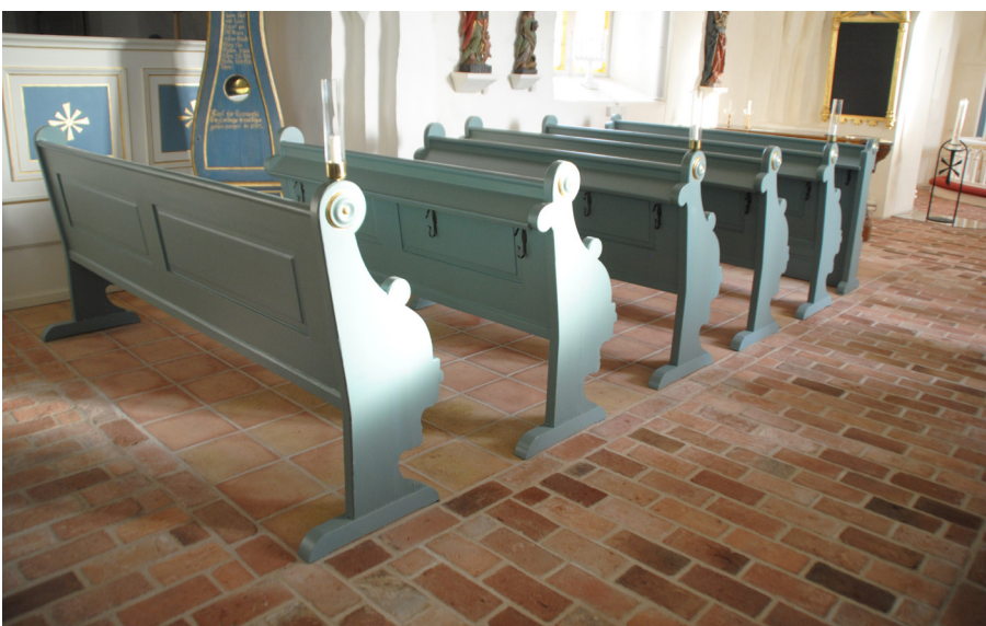
I bänkkvarteren har golvet lagts med nytillverkade kvadratiska golvtegelplattor från Qvesarum.
