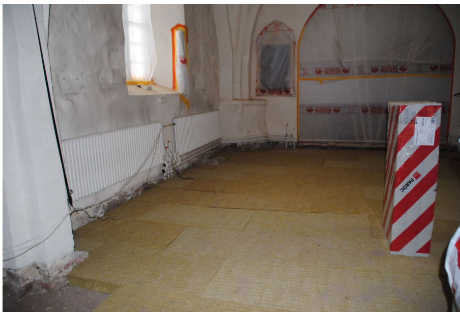
När marken i kyrkan jämnats till lades isolerande golvskeivor direkt på marken.
