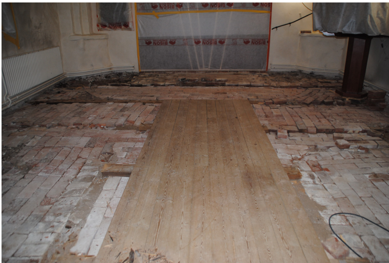
Större delen av trägolvet har brutits upp framåt i kyrkan. Mittgången lämnades tillfälligt kvar för att underlätta när tegelgolvet skulle tas upp.
