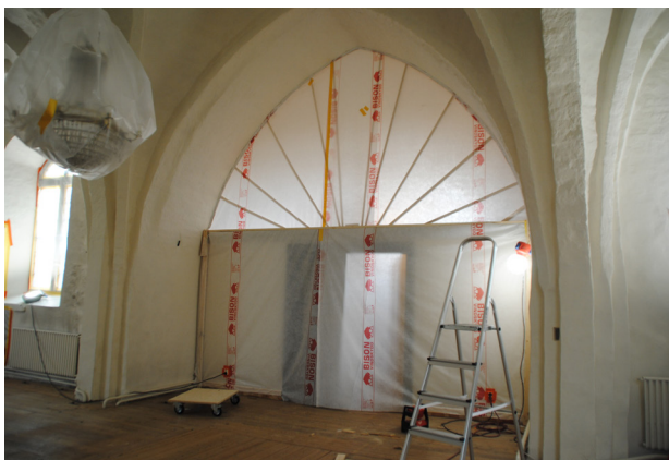
Koret, sidoskeppen samt inventarier som takkronor, psalmtavlor och predikstol täcktes in under renoveringen.
