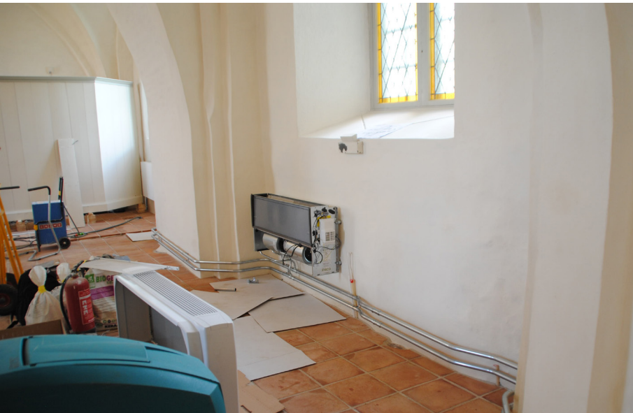
En av de nya radiatorerna har monterats på väggen.
