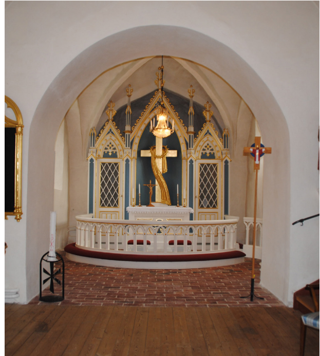
Korets golv renoverades 1997, då trägolvet togs bort och det underliggande tegelgolvet togs fram.
