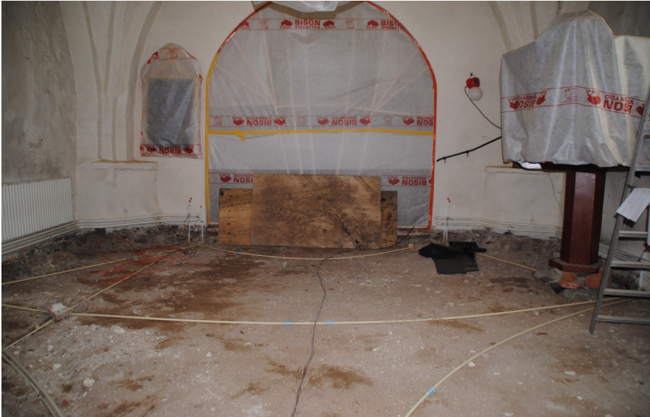
När marken i kyrkorummet jämnats till drogs elledningarna ut i rör till de platser där det behövs eluttag och högtalare.
