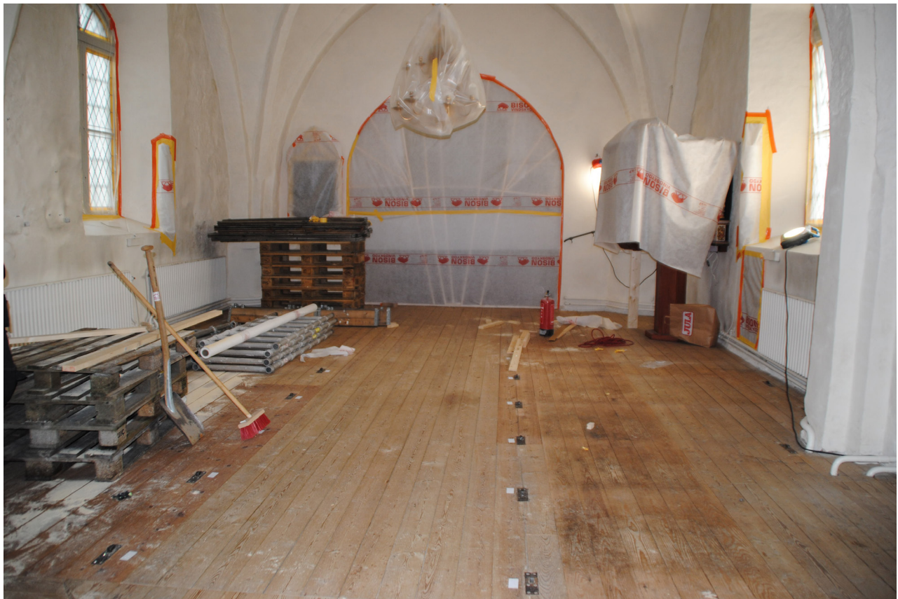
Trägolvet efter att bänkarna tagits bort
