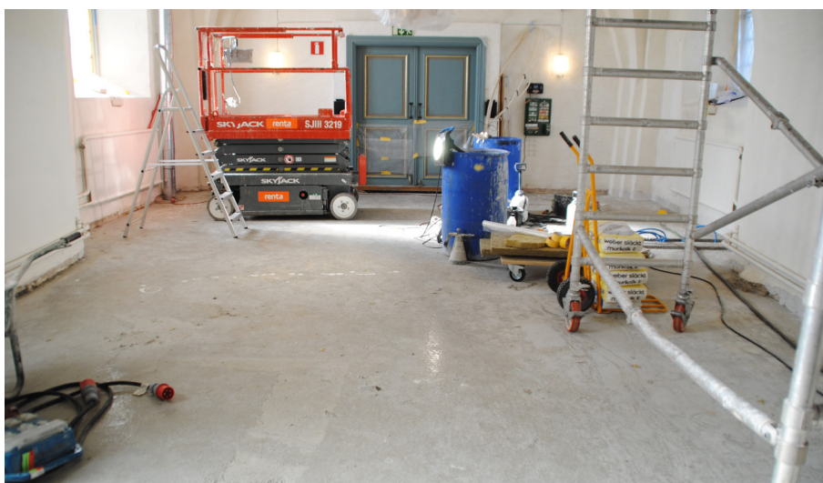
På markskivorna gjöts en tunn betongplatta.
