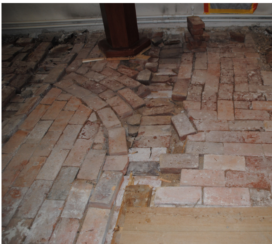
Större delen av trägolvet har brutits upp framåt i kyrkan. Mittgången lämnades tillfälligt kvar för att underlätta när tegelgolvet skulle tas upp.
