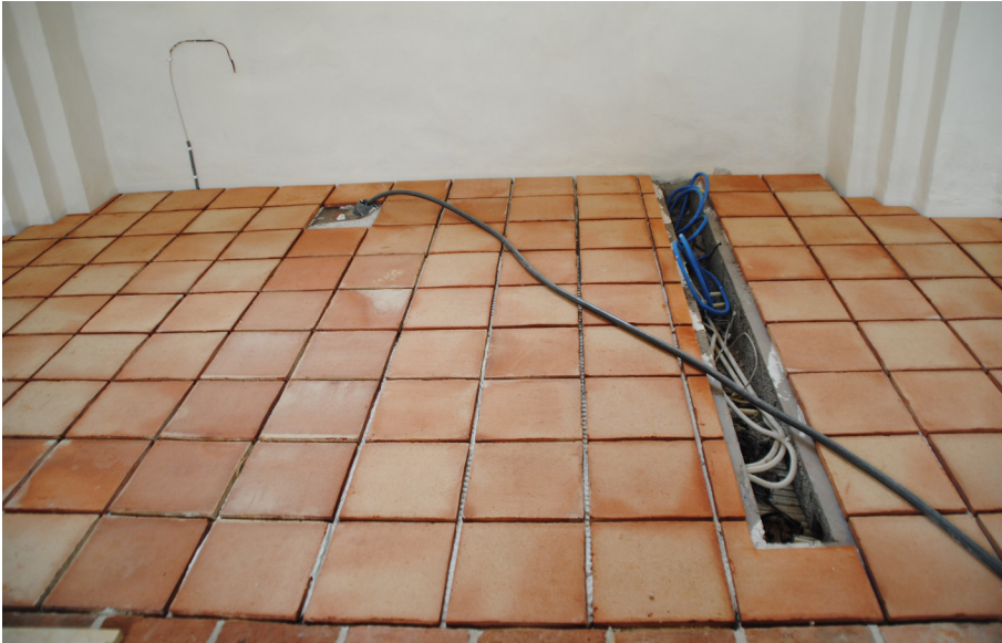
Golvet i det nordvästra bänkkvarteret håller på att läggas med nytillverkade kvadratiska tegelplattor från Qvesarum. En ränna för dragning av el mm till vaktmästarplatsen har skapats i golvet.
