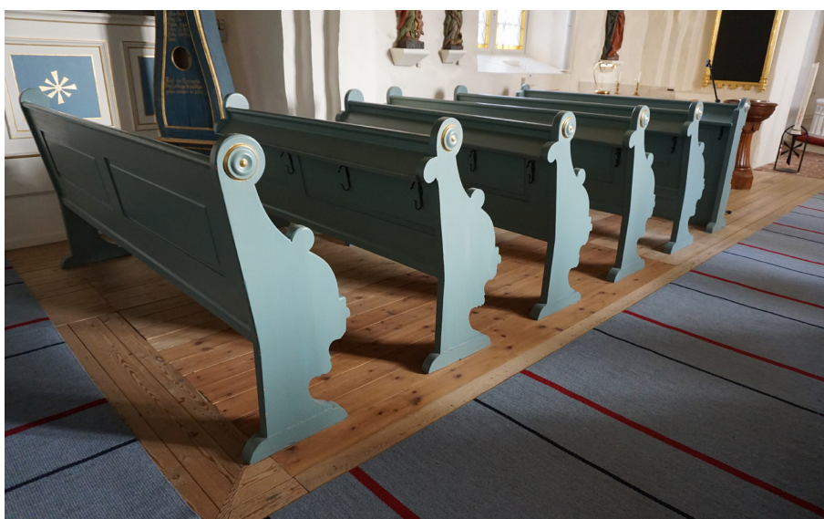
Nordöstra bänkkvarteret innan renovering. Bakom bänkkvarteret finns tvärgången med brädorna lagda i nordsydlig riktning.
