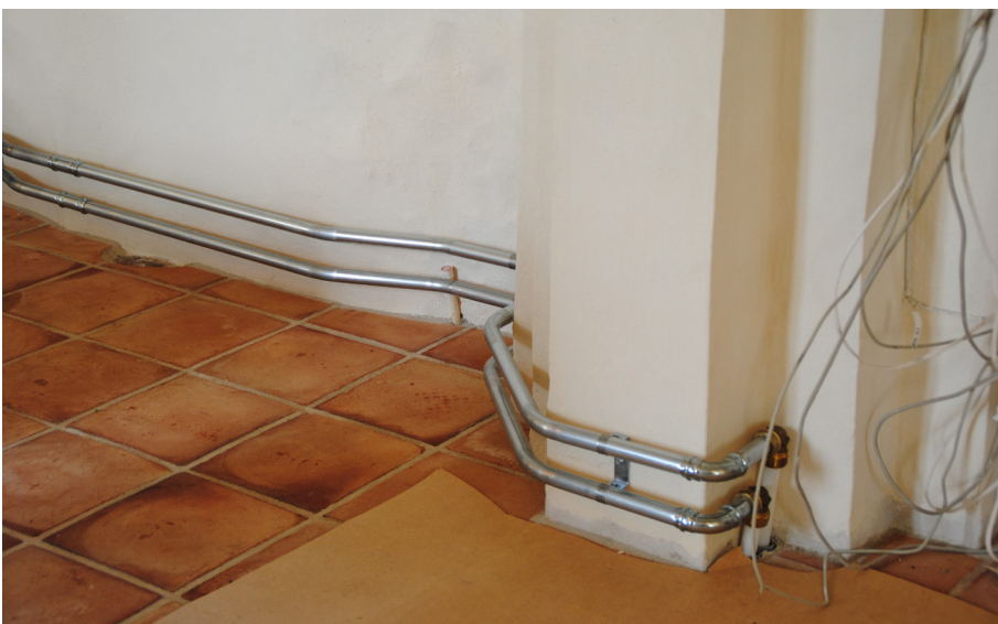
Rördragningar görs längs med väggarna som tidigare. Förbindelse mellan norrsidan där pannrum finns och sydsidan har gjorts under golvet i trägolvet, liksom tidigare.
