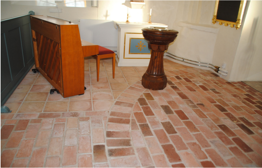
Det nya tegelgolvet i det nordöstra hörnet vid dopfunten och dopaltaret.
