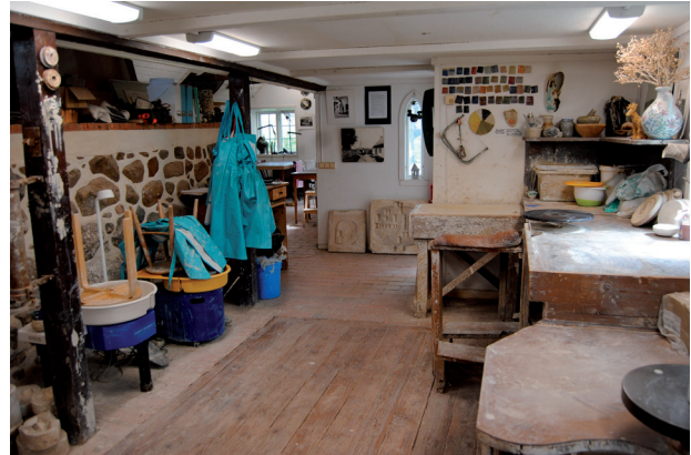
Den gamla ateljén, den södra utbyggnaden. Stolparna finns kvar efter den gamla innerväggen mellan verkstaden och den södra utbyggnaden. I denna del finns även det gamla brädgolvet kvar.
