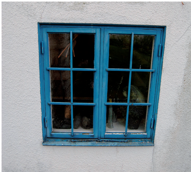
Ett av fönstren på den äldre delen av byggnaden.
