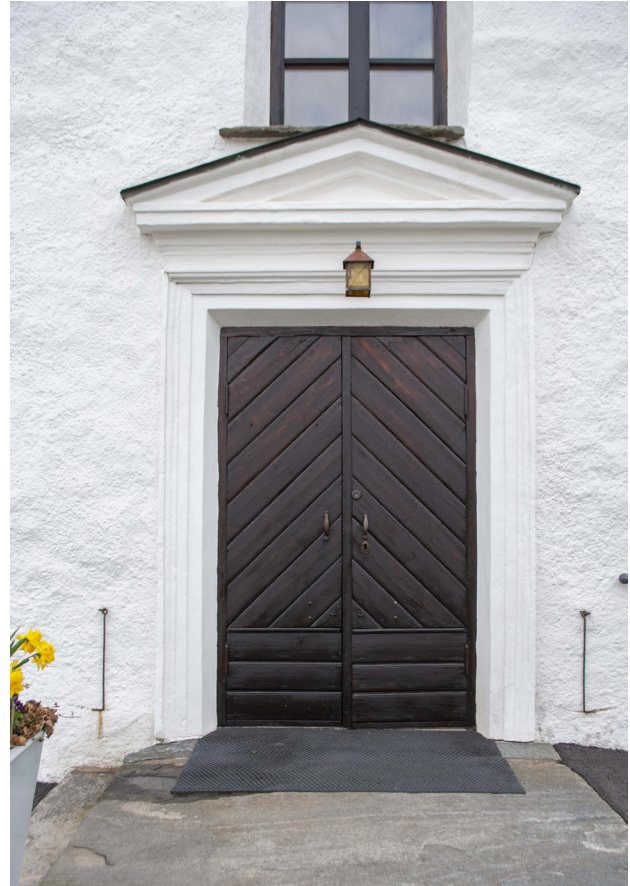
Då portar och fönster underhålls regelbundet fanns inga påtagliga skador mer än att ytskiktet bleknat något, som här på porten på västgaveln.
