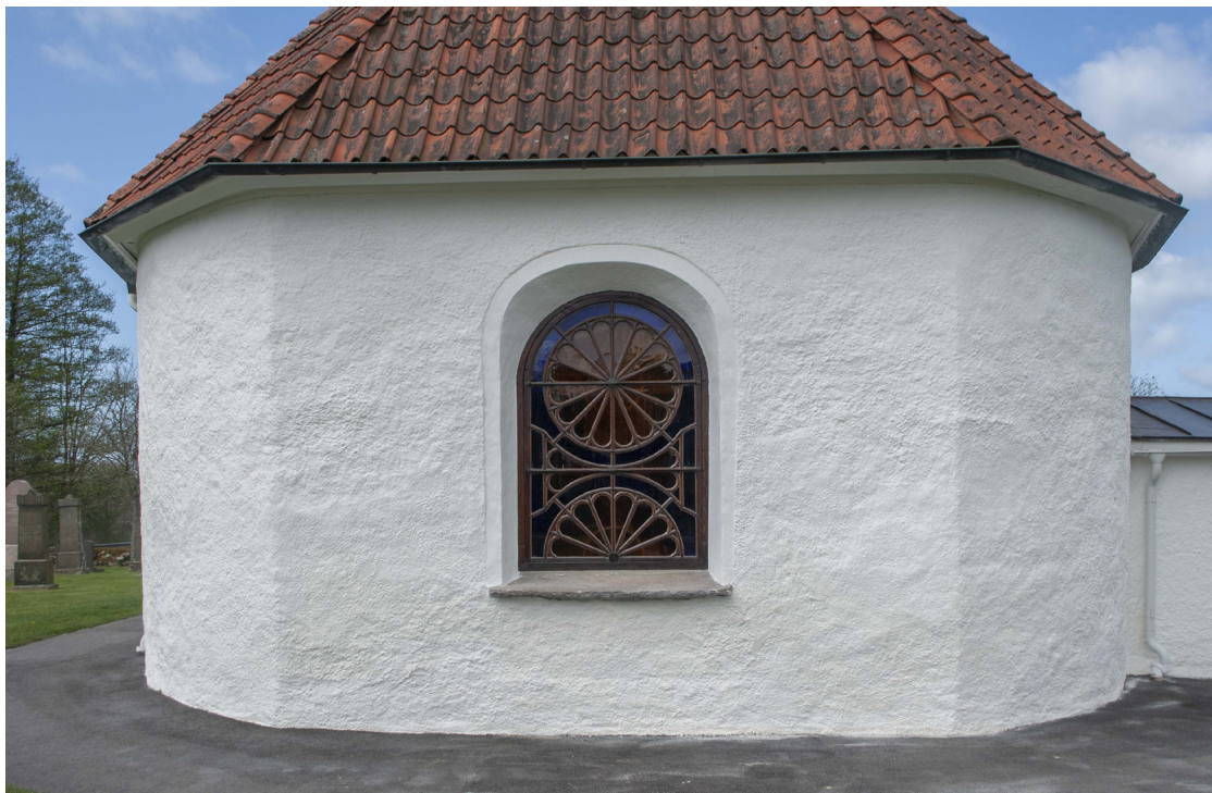
Koret efter åtgärd.
