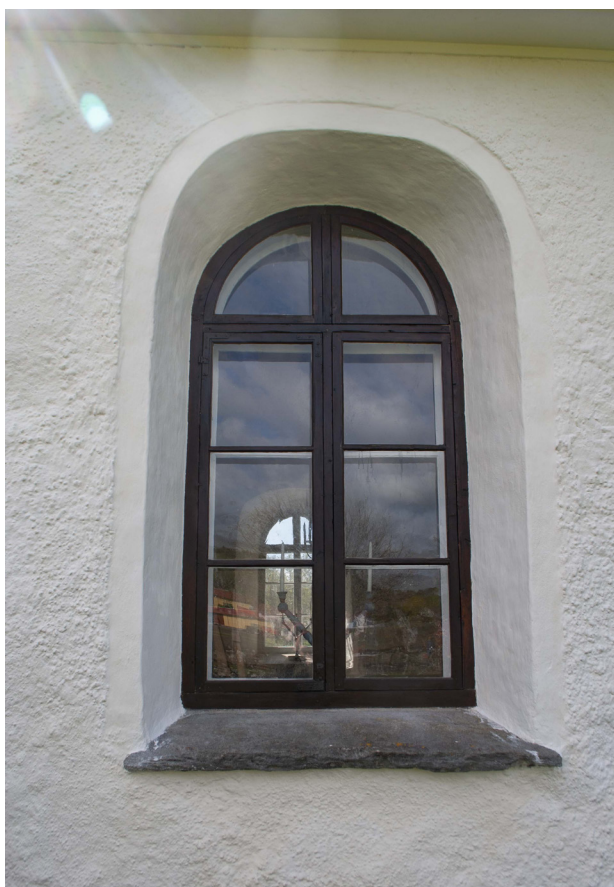
Ett fönster mot norr som behandlats med roslagsmahogny.
