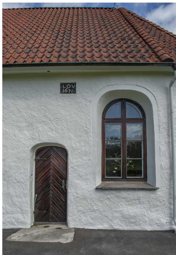
Då behandlingen av portar och fönster utfördes under år 2021 har ytskikten mot söder redan börjat blekna något. Det är därför mycket bra att underhållet sker regelbundet.
