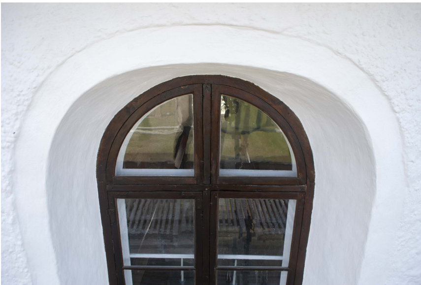
Fönster och fönsternisch sedd från ställningen.
