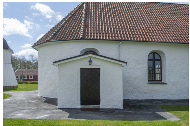
Sakristian efter åtgärd.
