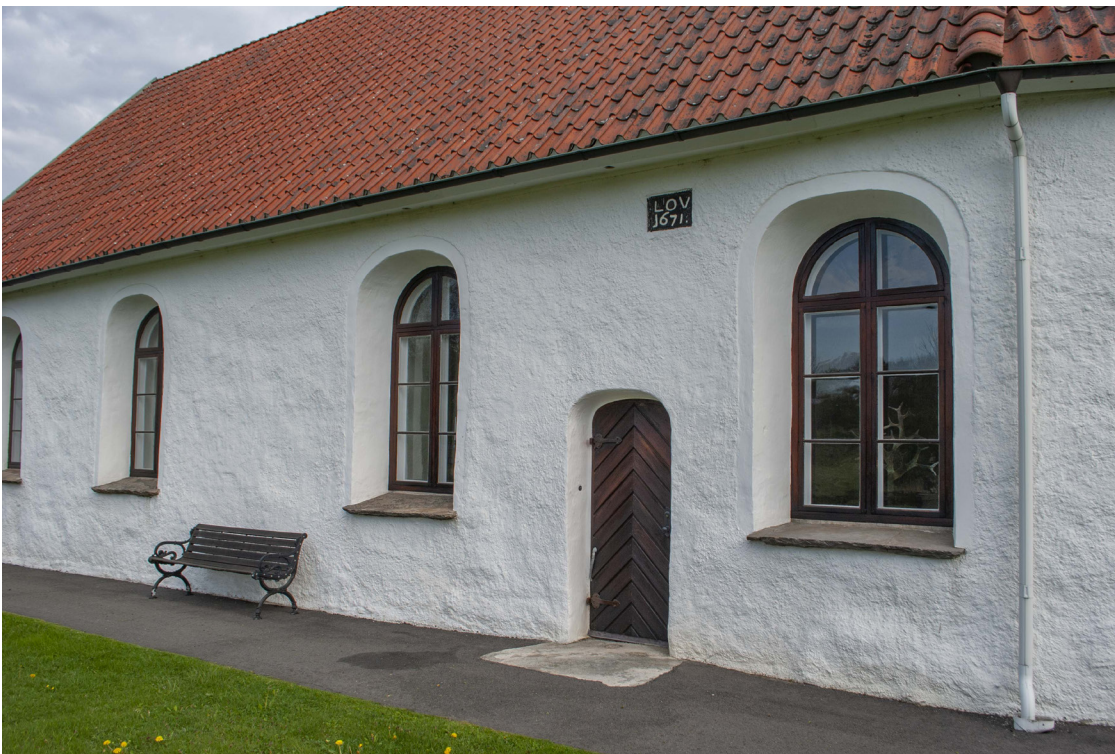
Södra långhussidan innan åtgärd. Även här är skicket gott men med viss smuts och små skador längst ned på fasaden mot marken. Ytskiktet på fönster och dörrar har bleknat något mer på södra sidan.
