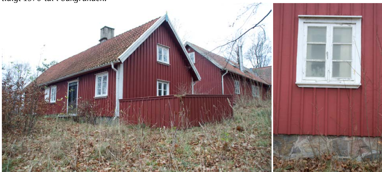
Stugan från sydost, med kompost vid gaveln, yngre byggnaden i bakgrunden. Fönstren är troligen nya sedan flytten, men stämmer överens med hur de äldre fönstren sett ut. Grunden är en modern gjuten konstruktion, men med stenar ingjutna.
