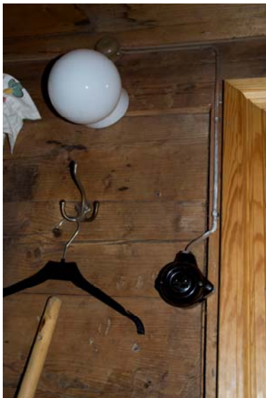
Timmerväggarna är synliga i köket. Elinstallationerna har till viss del äldre utförande, även om armaturer ofta är helt moderna som lysrör. Spegeldörrarna med äldre lås är ett bevarandevärt kulturarv.
