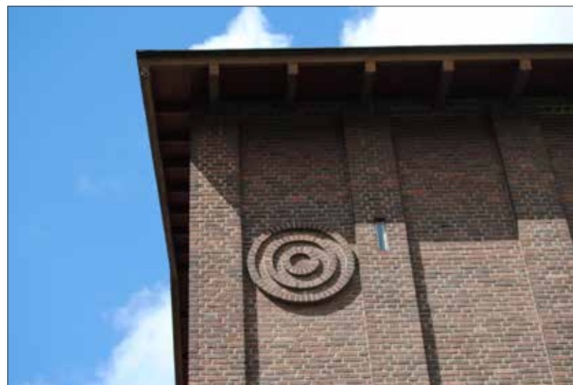
Detalj fasad baksidan, med det lilla kyrkfönstret i kapellrummet.
