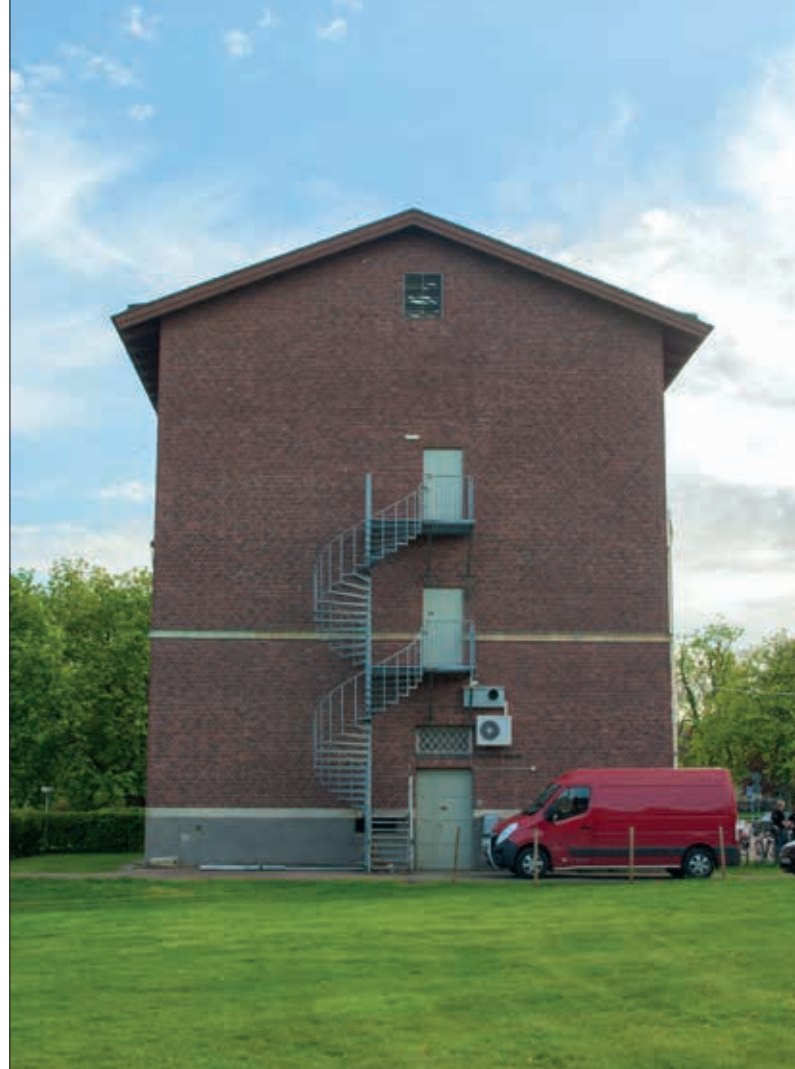
Fasad mot norr/gaveln.
