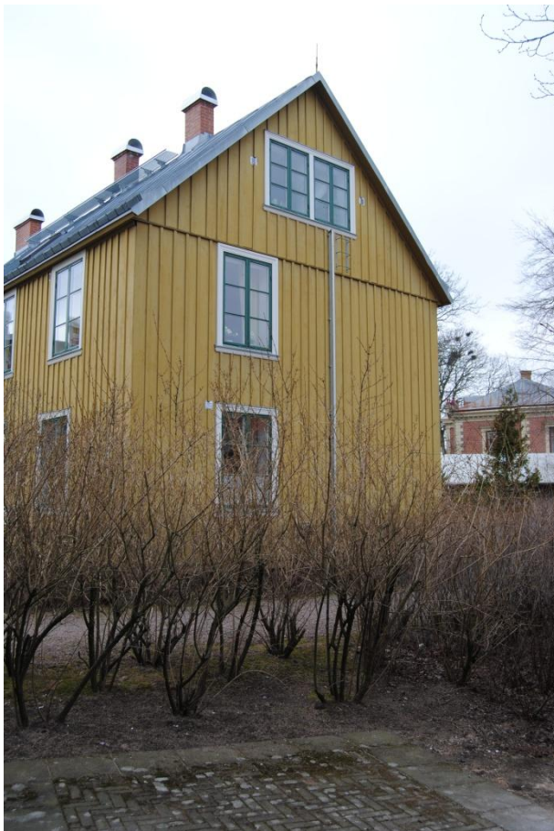
Byggnadens nordligaste gavel.
