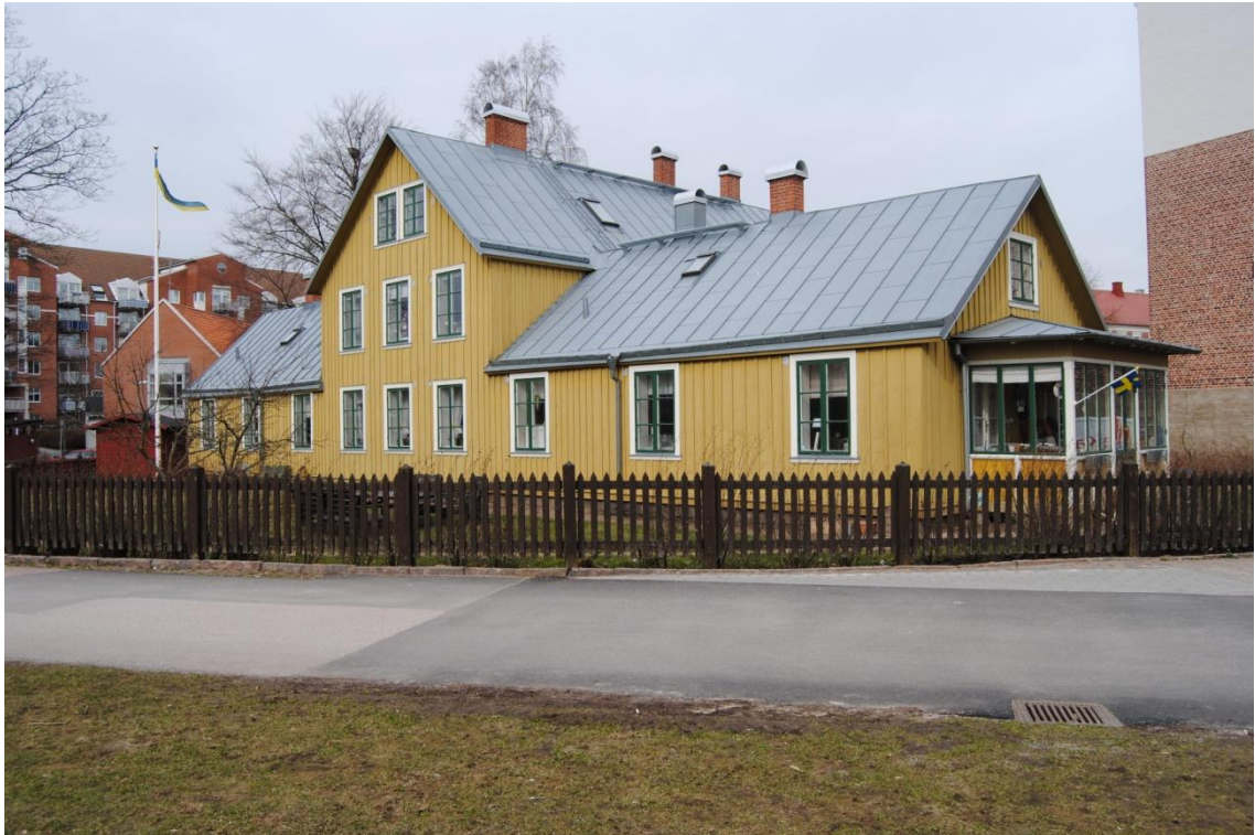
Byggnaden från söder.
