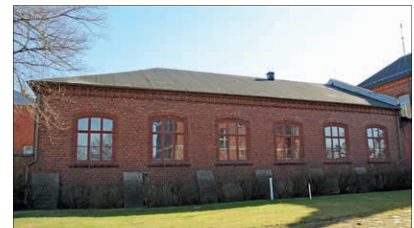
Fasaden mot trädgården. Mellan fönstren sitter gjutna strävpelare, troligen tillkomna som grundförstärkning.
