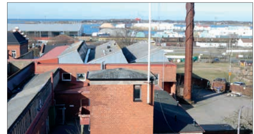
Sågtandstaket i den förhöjda delen skymtar bortom portvaktshuset.
