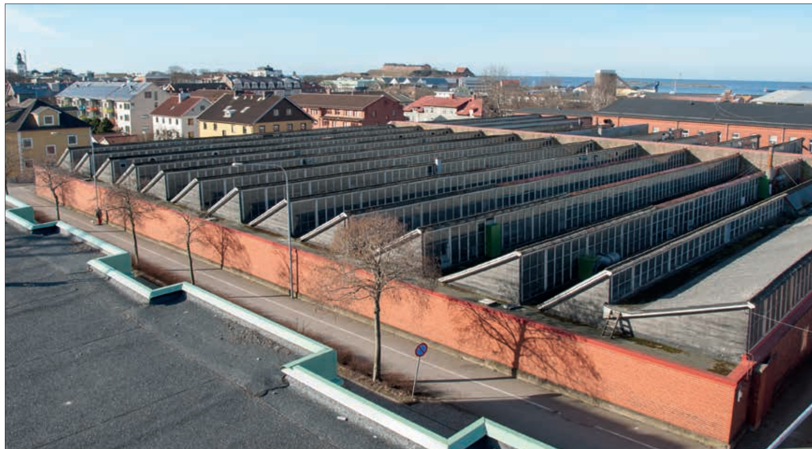
Sågtandstaket är ett av de viktigaste karaktärsdragen i fabriksbyggnaden.
