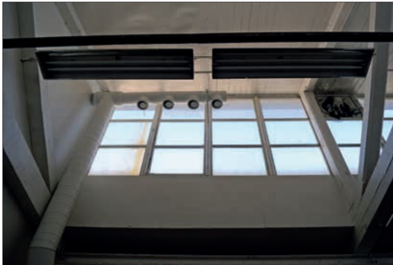
Fönstersektion i sågtandstaket. Hela takkonstruktionen är vitmålad.
