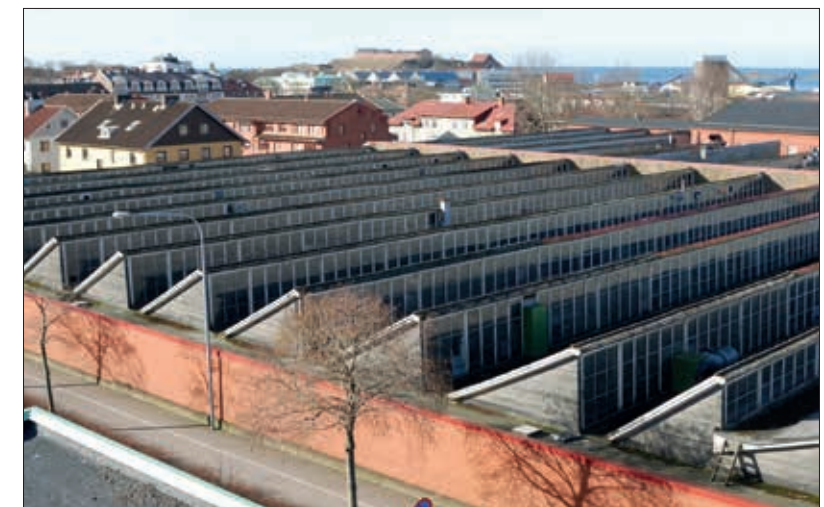
Fabriksbyggnaden sedd från polishusets tak. Notera den genomgående brandmuren. Vy mot sydväst.
