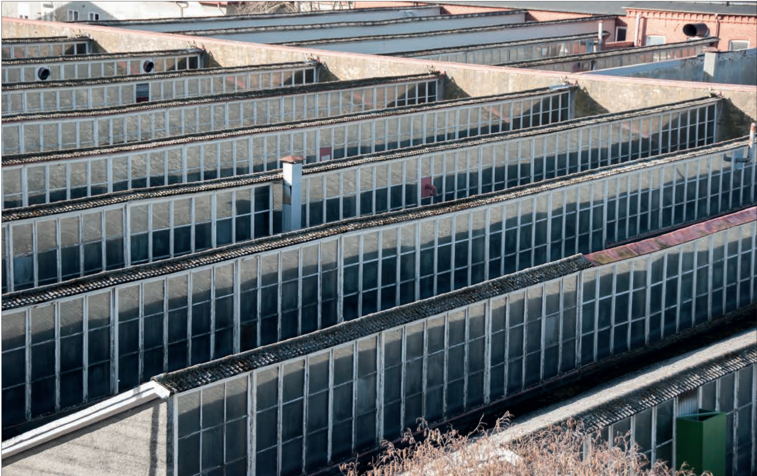
Sögtandstakets många fönster gav ljus till interiören.
