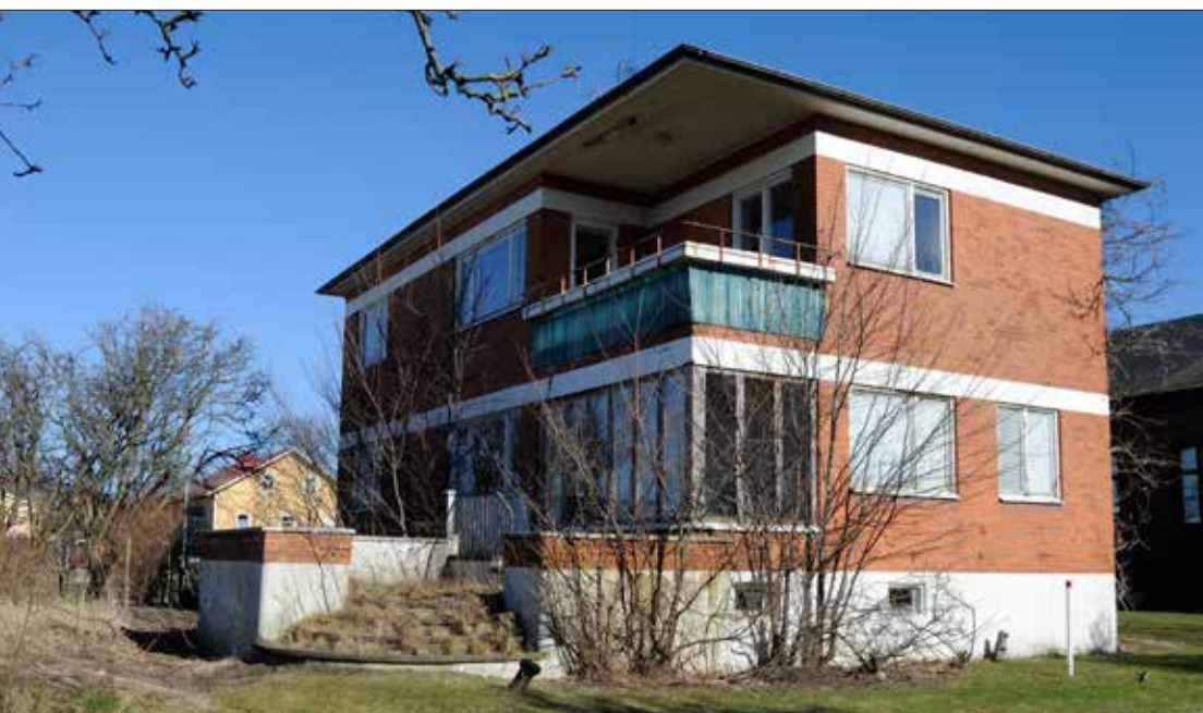
Byggnaden är mer sluten mot öster, där entrédörren ligger. Innanför det stora fönstret ligger den genomgående trapphallen.
