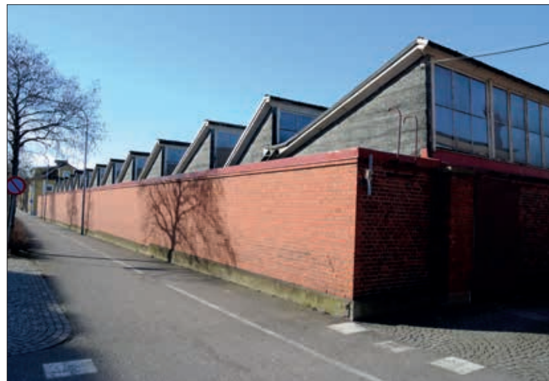
Muren utmed Östra Långgatan. Vy mot sydväst.
