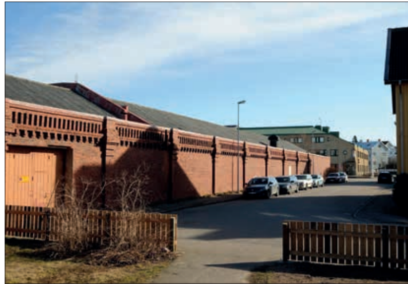
Den södra fasadmuren mot Gamlebygatan. Vy mot nordost.
