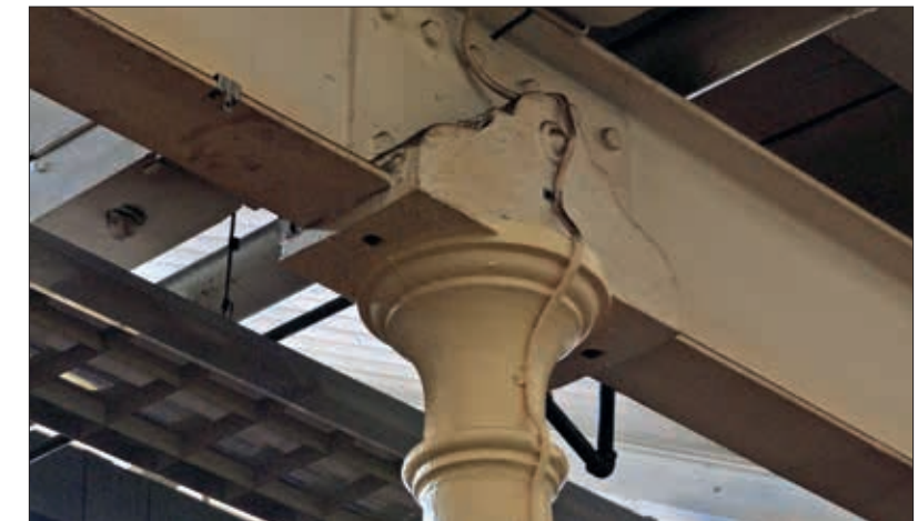
Detalj av gjutjärnsspelare med upplag för I-balk
