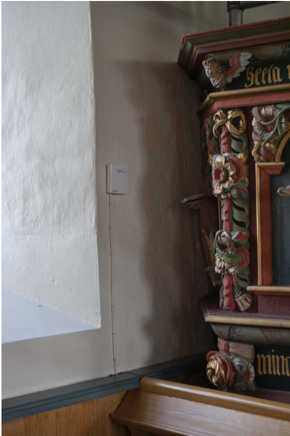
Givare vid predikstolen som mäter relativa luftfuktigheten i zon 1.
