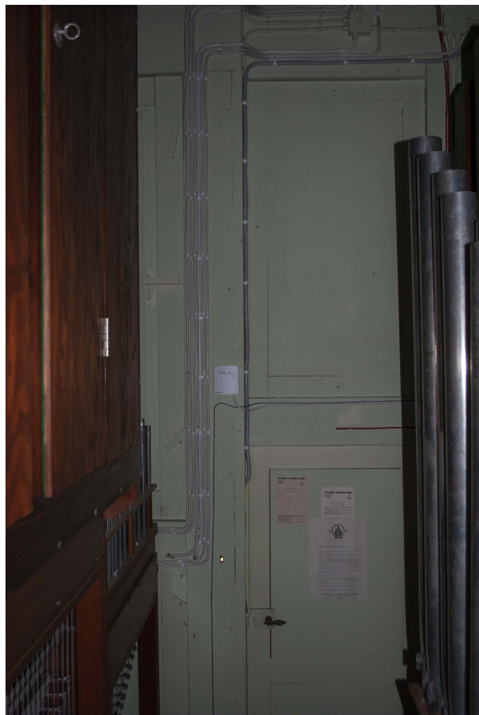
Givare på takfotslisten uppe på läktaren, som mäter relativa luftfuktigheten i zon 3.
