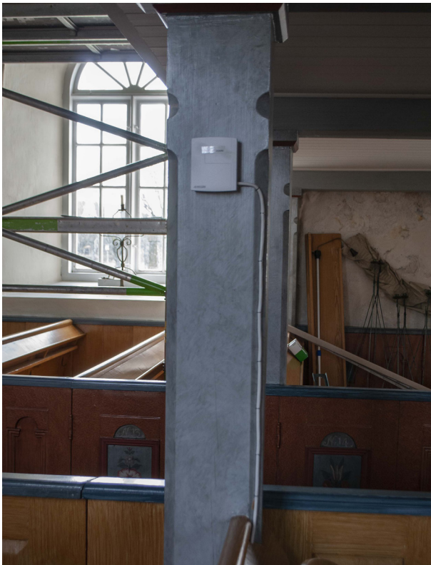
På en pelare under läktaren sitter en givare som mäter klimatet längst bak i kyrkan, i zon 2.
