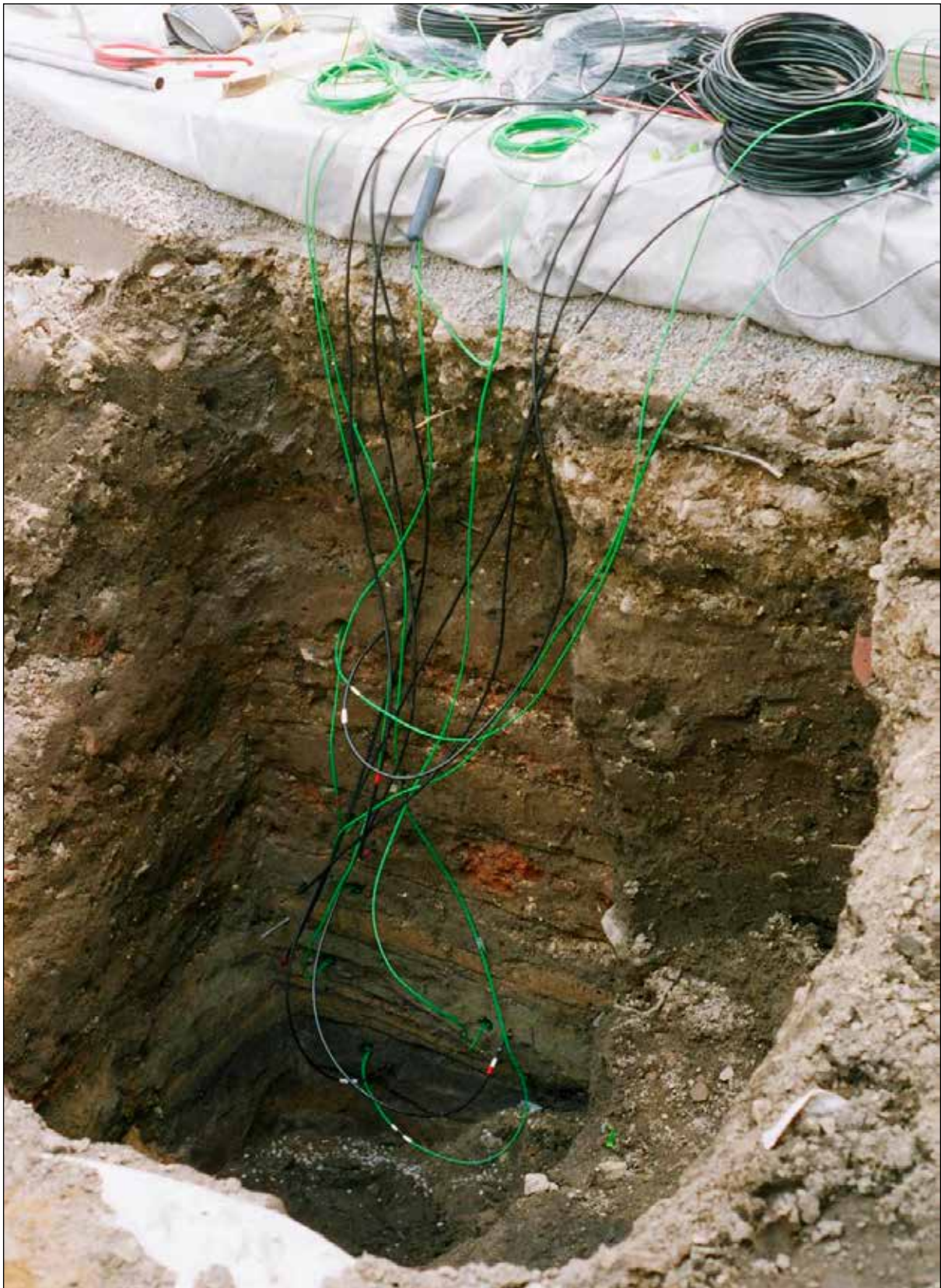
Fig. 3. Installerade sensorer i provgrop 8, södra sektionen. Fotograferad mot syd. Foto: Erik Rosengren. (fotonr K4900-17).
