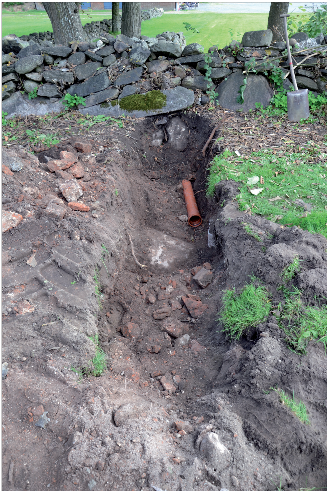
Fig 5. Schaktet med stenarna, K10460 och K10473 samt det nya röret. Mot ost. Fotograf: Lena Bjuggner (fotonr 2013-17-191).
