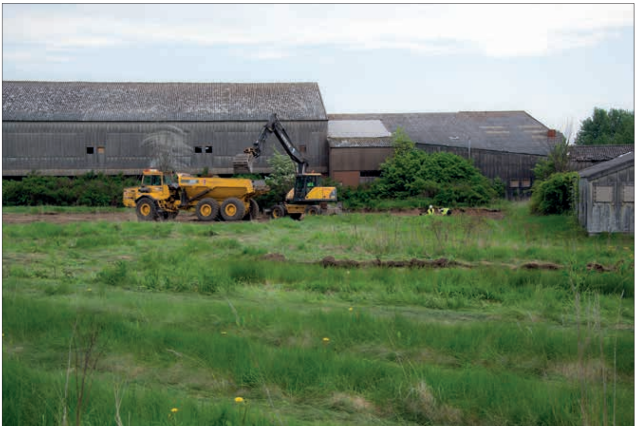
Fig 2. Avbaning pågår. Foto mot nordnordost. Foto: Kerstin Svensson, (Fotonr:2014-16-15).
