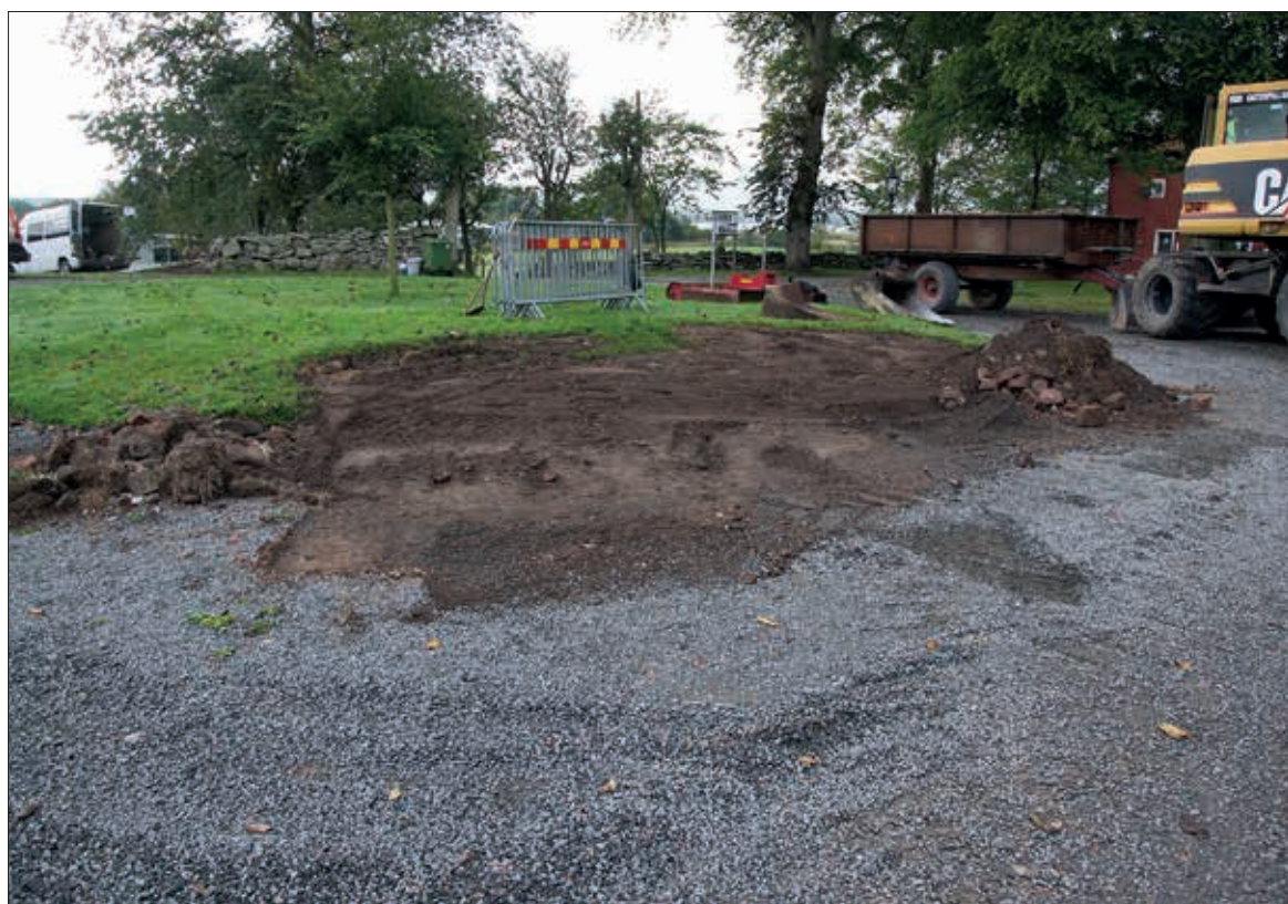
Det igenfyllda schaktet. Mot syd (fotonr 2014-70-259).
