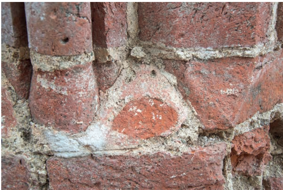
Fig 22. Rödfärgade fogar på portalens nordsida. Foto: Erik Rosengren (fotonr 2014-70-227).
