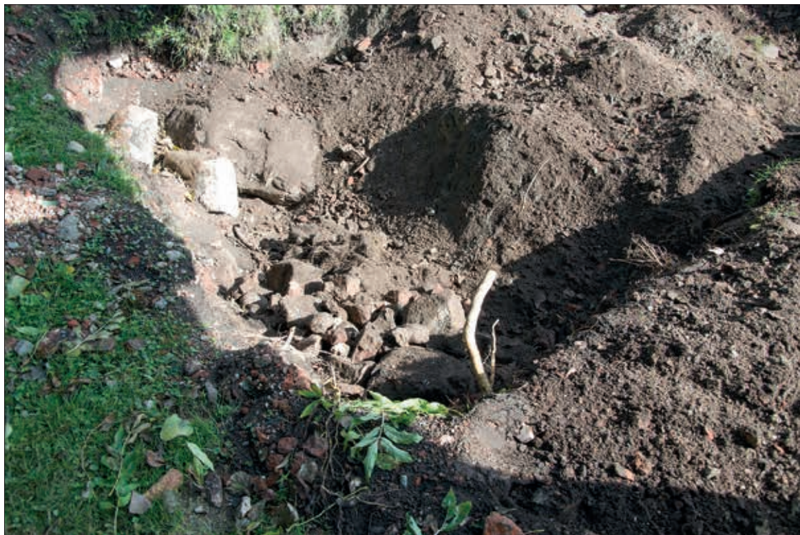
Större stenar och tegelstenar läggs i den del av schaktet som inte innehåller murar. Mot nordost (fotonr 2014-70-266).
