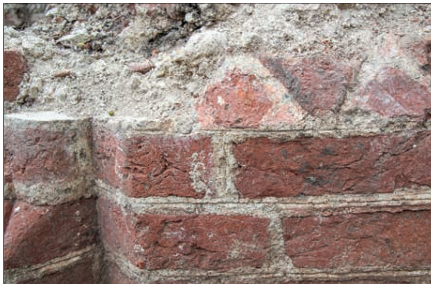
Fig 17. Ritsade fogar på portalens sydsida (K12977). Lägg även märke till den fragmentariskt bevarade rödfärgningen. Foto: Erik Rosengren (fotonr 2014-70-232).
