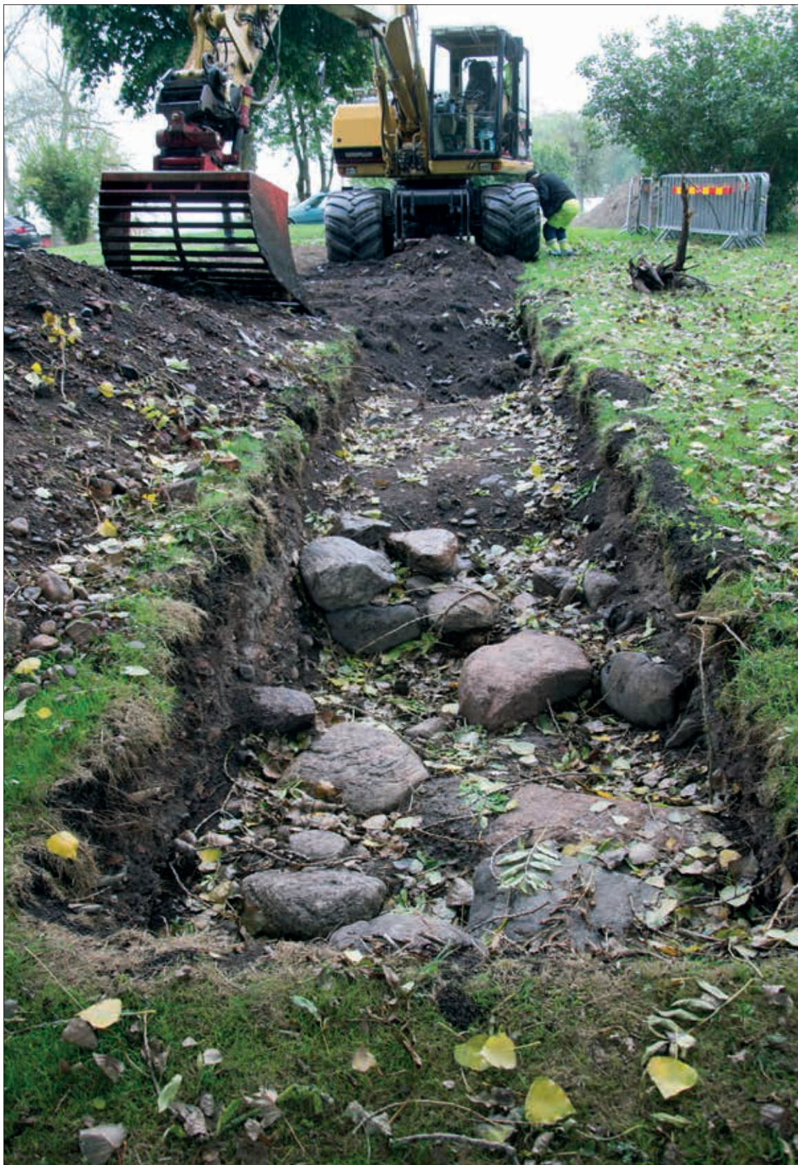
Schaktet fylls successivt igen med de uppgrävda massorna. Mot ost (fotonr 2014-70-261).
