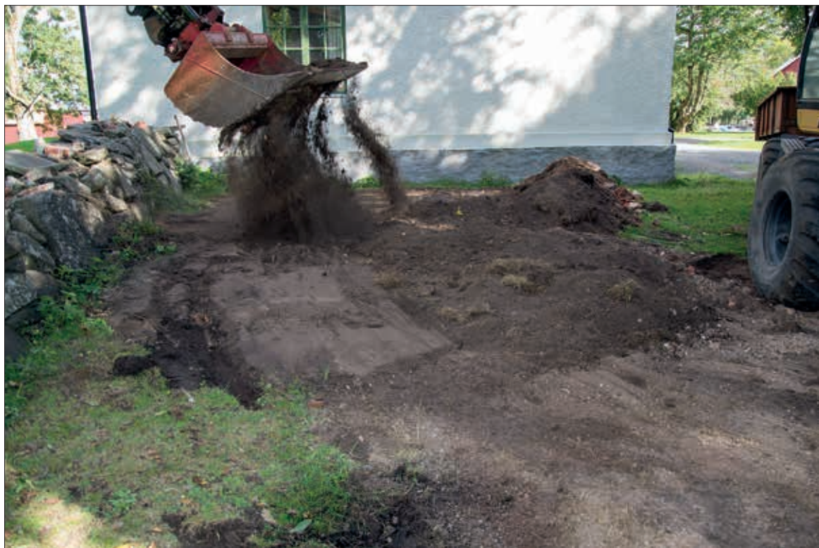
Det nästan igenfyllda schaktet. Mot ost (fotonr 2014-70-285).
