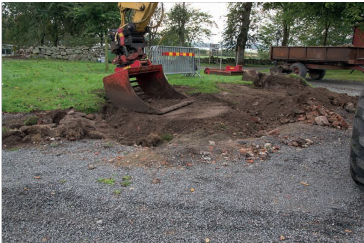
Jordmassorna packas försiktigt med hjälp av grävmaskinens skopa. Mot syd (fotonr 2014-70-258).
