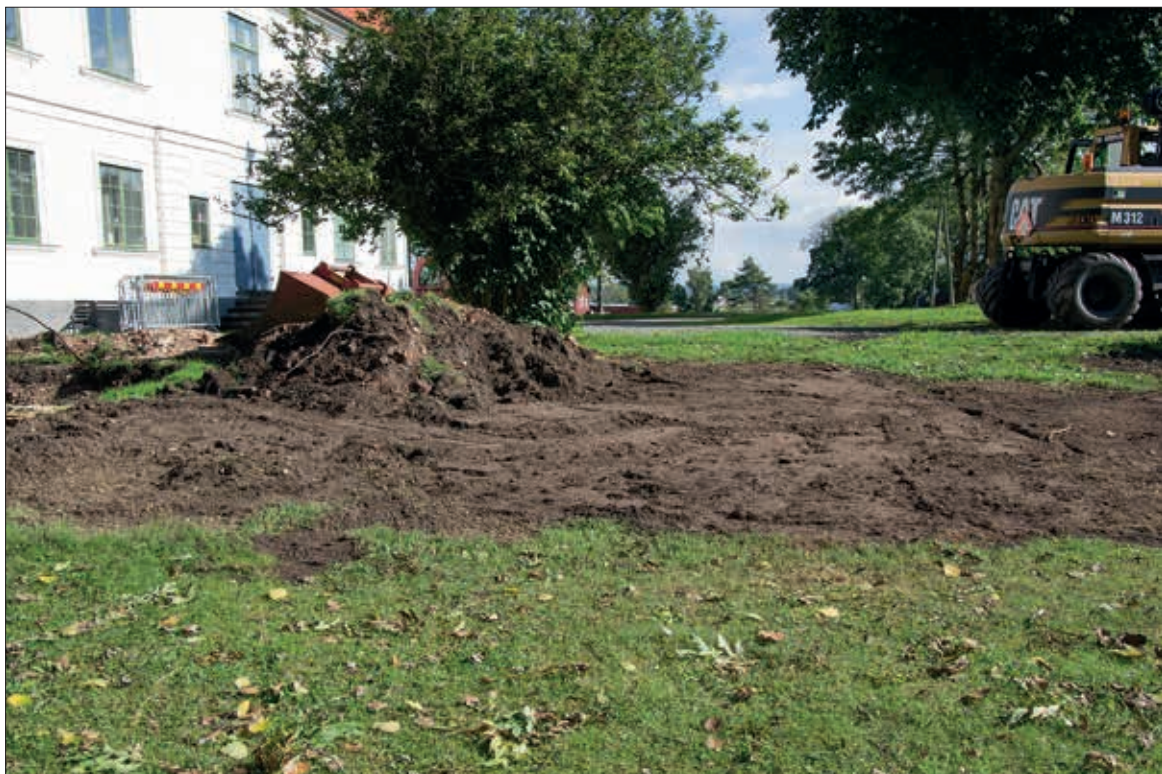
Det igenfyllda schaktet. Mot ost (fotonr 2014-70-268).
