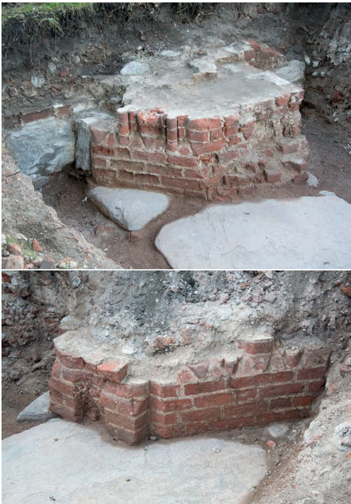
Fig 19. Norra (K12922) respektive södra (K12977) portalöppningen. Foto mot nordost respektive sydost. Foto: Lena Bjuggner (fotonr 2014-70-108 och 2014-70-103).
