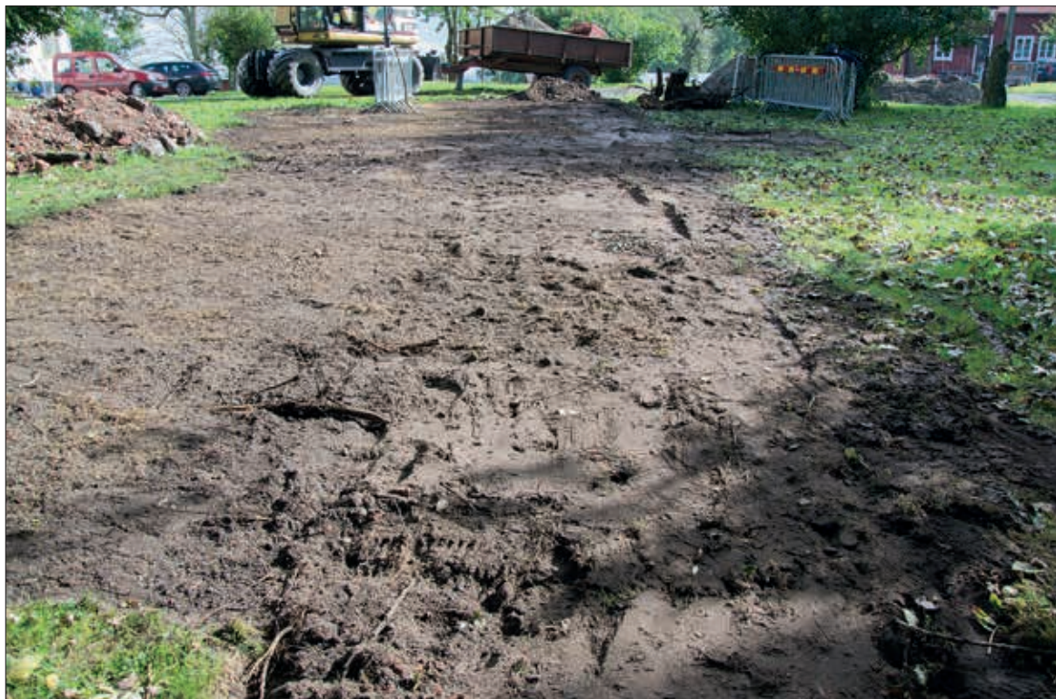
Det igenfyllda schaktet. Mot ost (fotonr 2014-70-262).
