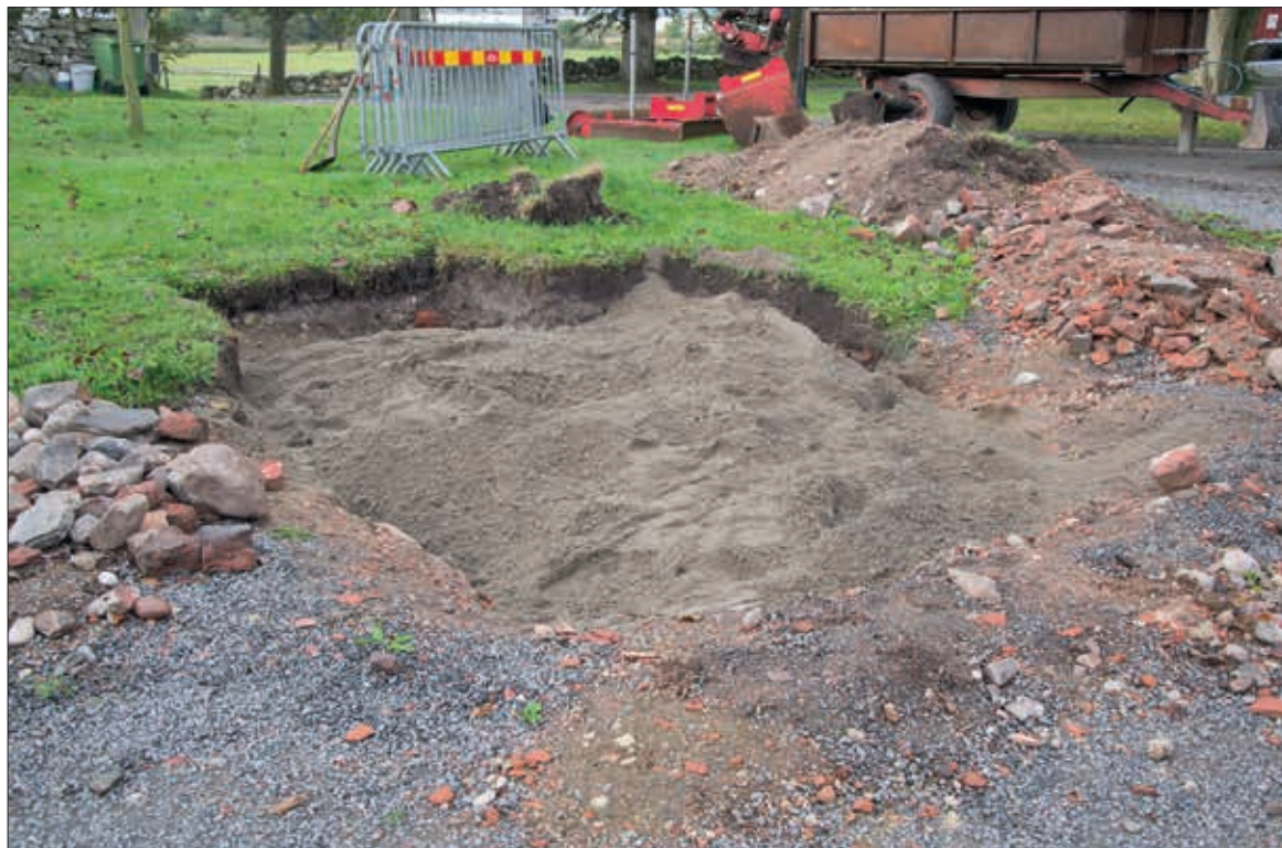
Sand fylls på upp till grusplans- och gräsmattenivå. Mot sydväst. Mot syd (fotonr 2014-70-256).
