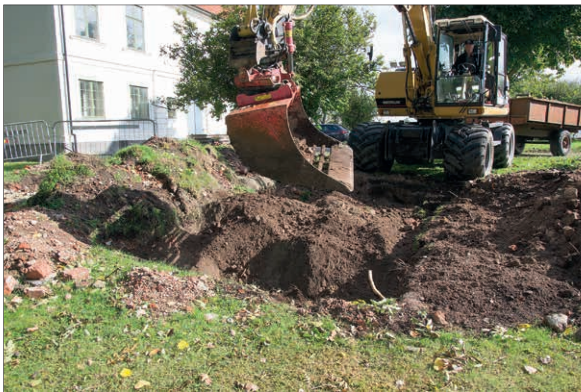
De uppgrävda massorna sållas från större stenar och tegelstenar och läggs ovanpå sanden. Mot nordost (fotonr 2014-70-265).
