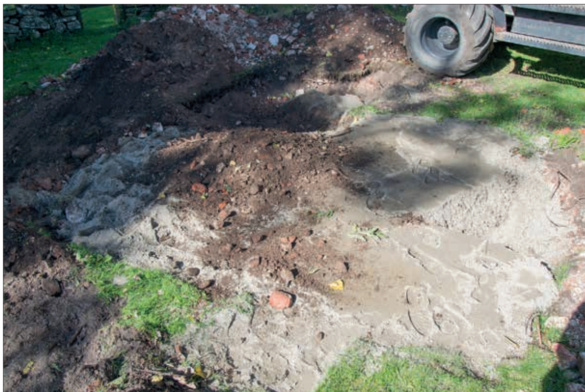
Uppgrävda massor sållas innan de läggs ovanpå sanden och packas försiktigt med grävmaskinens skopa. Mot nordost (fotonr 2014-70-272).
