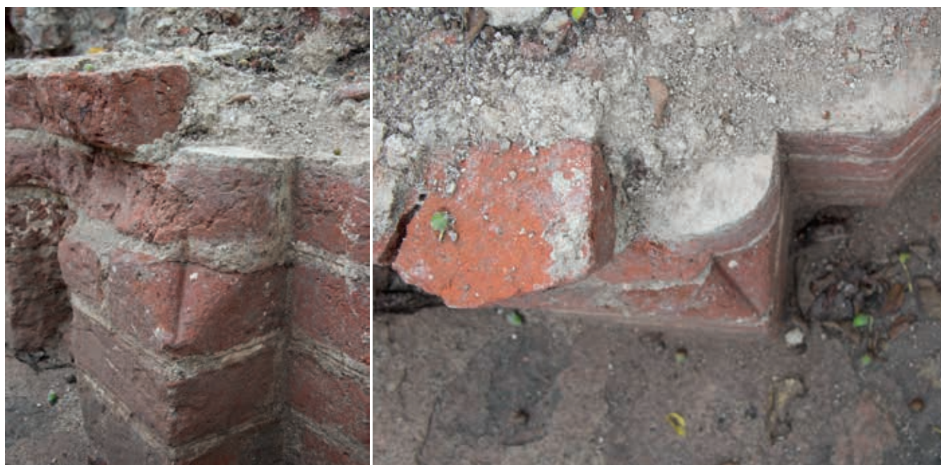
Fig 21. Portalens innersta språng är borthugget på norra sidan och delvis skadat på den södra sidan K12922. På den senare kunde man ana att den utsmyckats med en dubbel rundstav. Foto: Erik Rosengren (fotonr 2014-70-231 och 2014-70-241).
