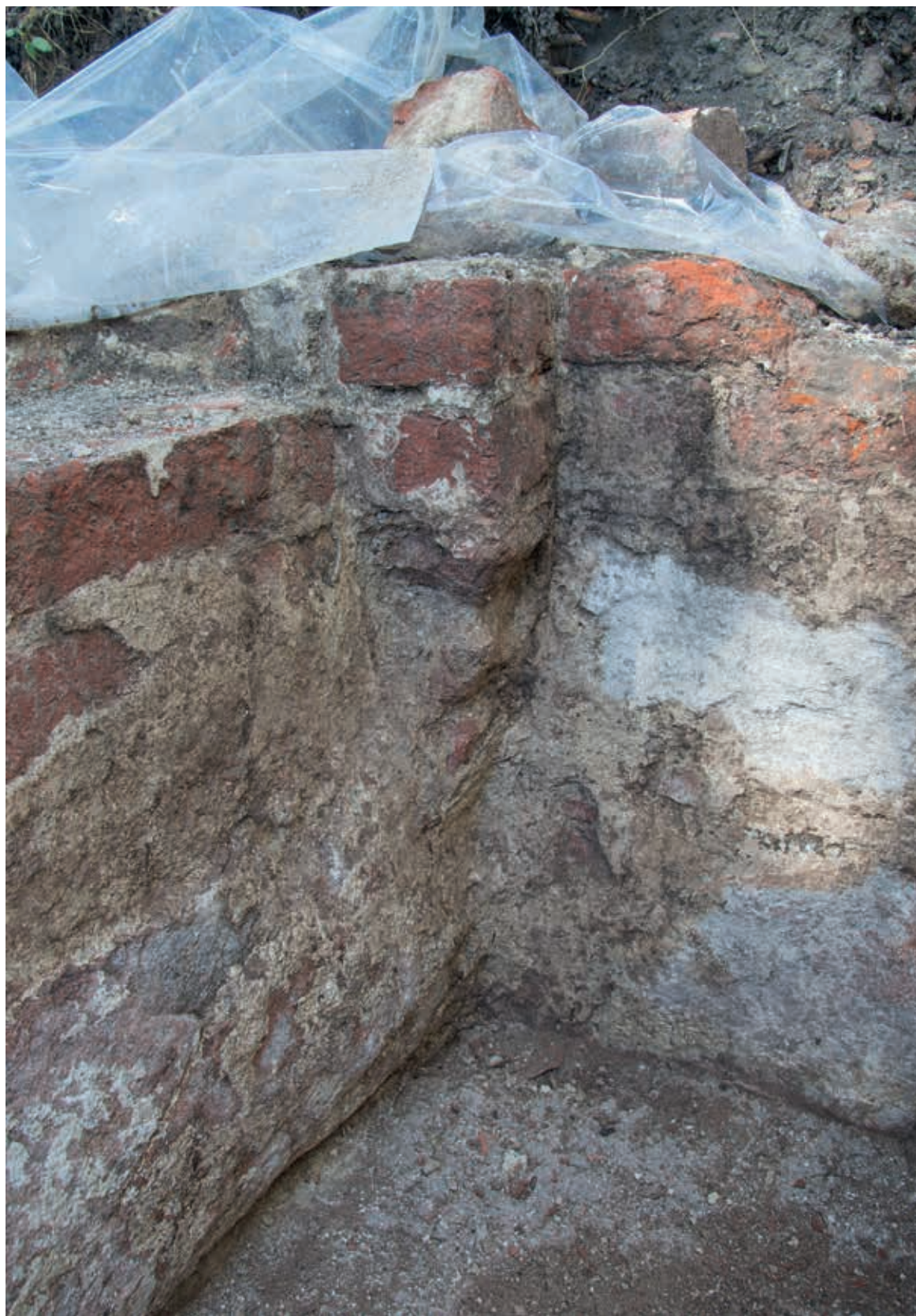
Fig 23. Valvkonsol och rester av puts i kyrkans inre, nordvästra del. Mot nordväst. Foto: Erik Rosengren (fotonr 2014-70-26 eller 2014-70-27).
