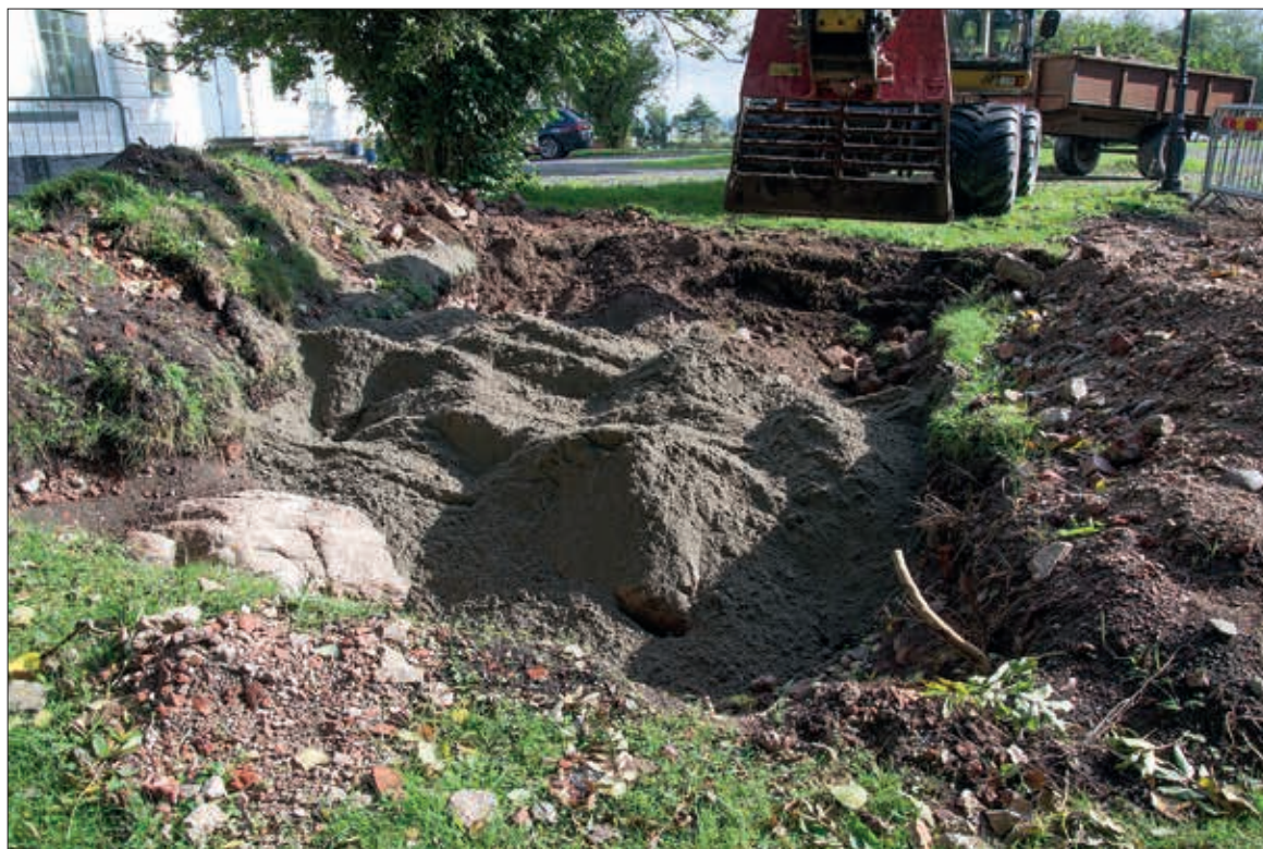
Sand läggs ovanpå och kring murarna. Mot ost (fotonr 2014-70-264).
