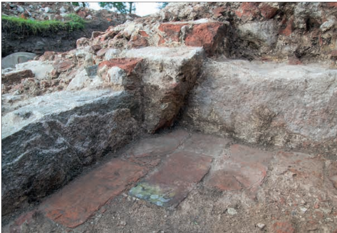
Fig 44. Konsol till valvribba i det invändiga sydvästra hörnet, mot sydväst. Foto: Lena Bjuggner (fotonr 2014-70-113).
