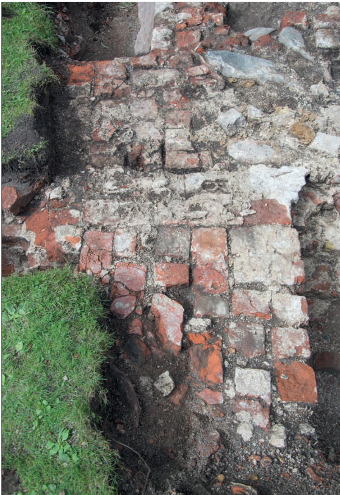
Fig 37. Pelaren och sprickbildningar i flera av de nord-sydliga fogarna. Foto: Martina Hjertman (fotonr 2014-70-67).
