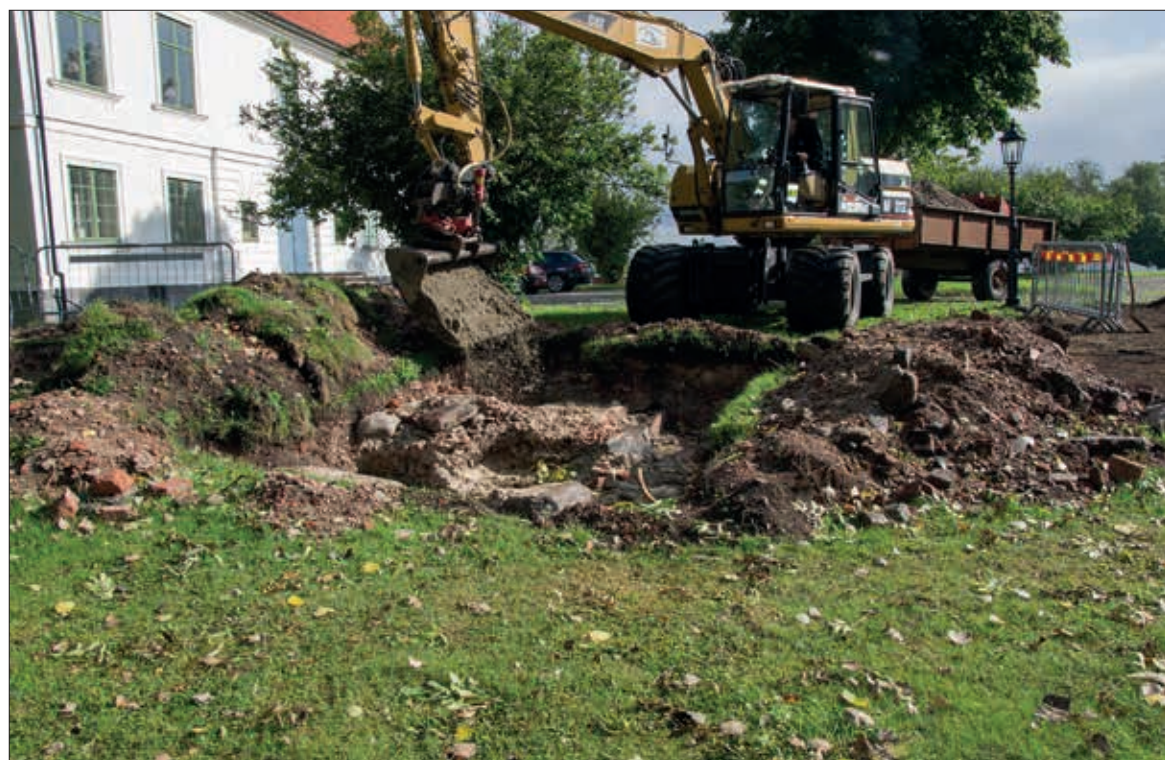
Påbörjad igenfyllning med sand. Mot nordost (fotonr 2014-70-263).
