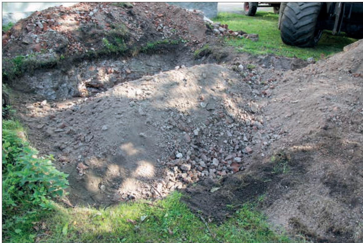
De uppgrävda massorna som sällas läggs ovanpå sanden och stenar/tegelstenar placeras i området utanför portalen. Mot sydost (fotonr 2014-70-284).
