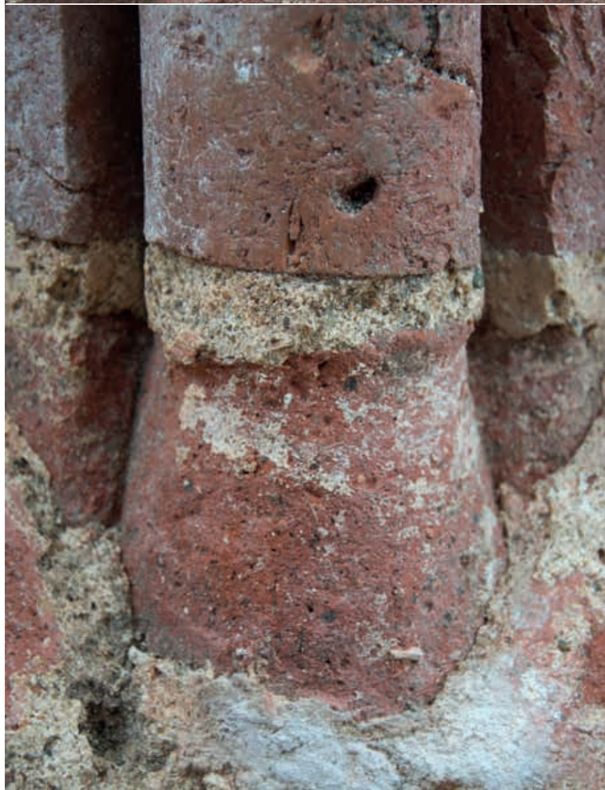
Fig 18. Rundstavarna vilade på en konformad bas som sjönk ned i ett sluttande plan. Portalens nordsida K12922. Foto: Erik Rosengren (fotonr 2014-70-219).
