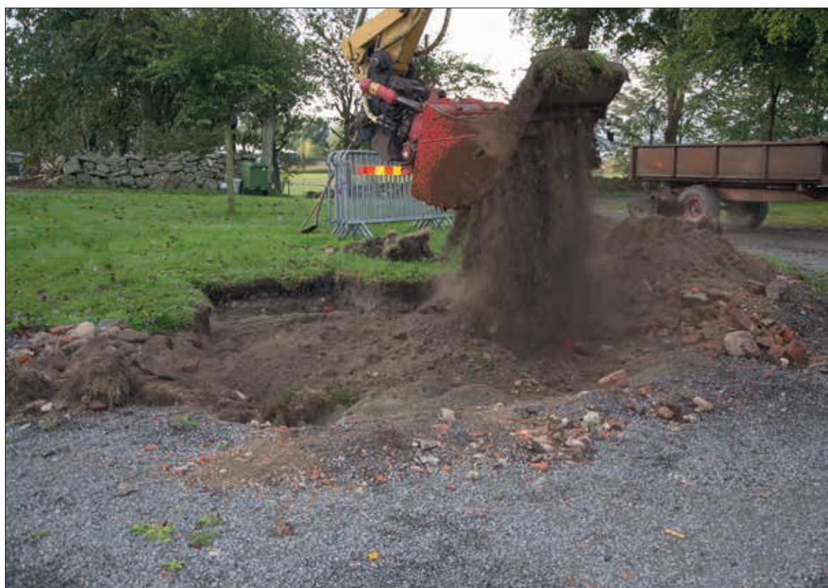
De uppgrävda massorna sållas för att sedan läggas ovanpå sanden. Mot syd (fotonr 2014-70-257).
