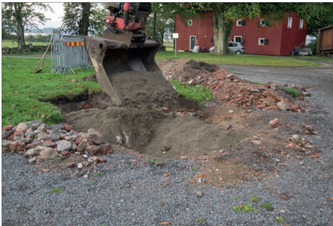
Påbörjad igenfyllning med sand ovanpå murarna. Mot sydväst (fotonr 2014-70-255).
