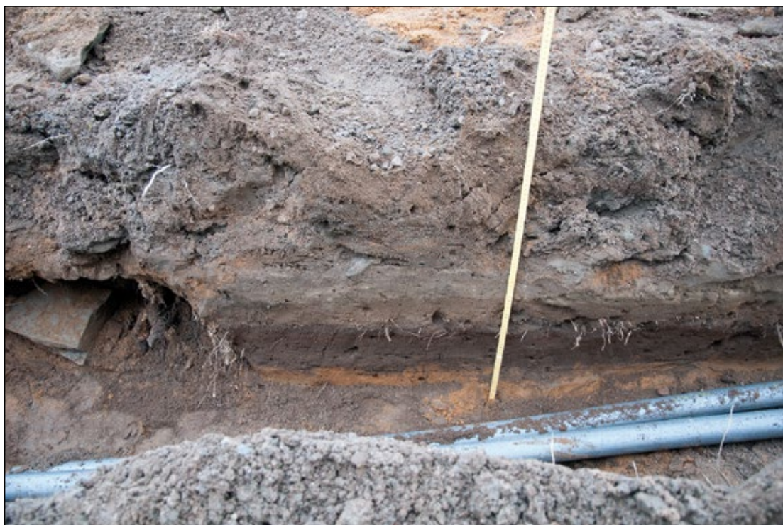
Fig 4. Del av sektionen i östra delen av schaktet. Foto mot norr. Fotograf: Fredrik Larsson. (Fotonr 2014-12-42).
