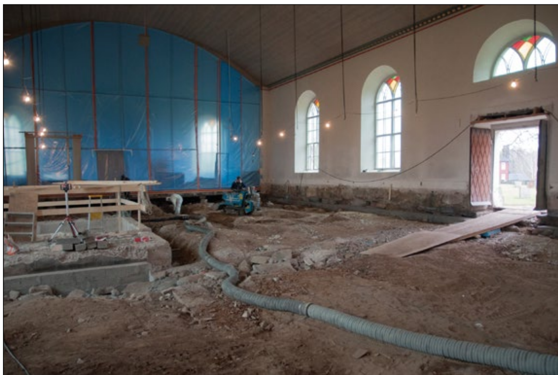
Fig 5. Fältarbetet påbörjas. Slangen till grävsugen i bild och södra långhusingången i höger bildkant. Foto mot sydost. Fotograf: Patrik Hallberg. (Fotonr 2014-12-57).
