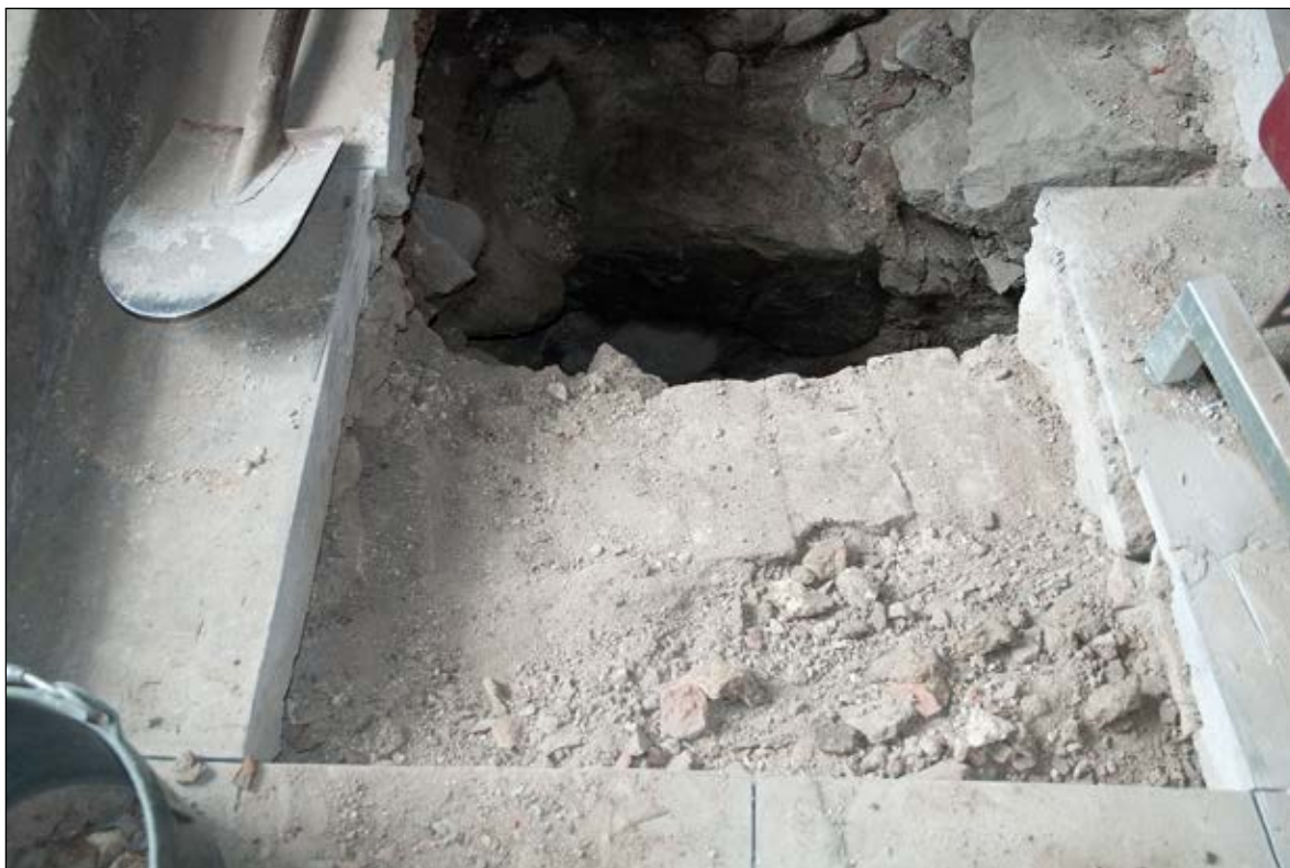
Fig. 32. Provgrop 5 utvidgas åt norr. Betonggolvet har avlägsnats och en murad tegelkonstruktion 2564 syns i ytan. Mot S. Fotonr: 2014-18-26. Foto: Stina Tegnhed.
