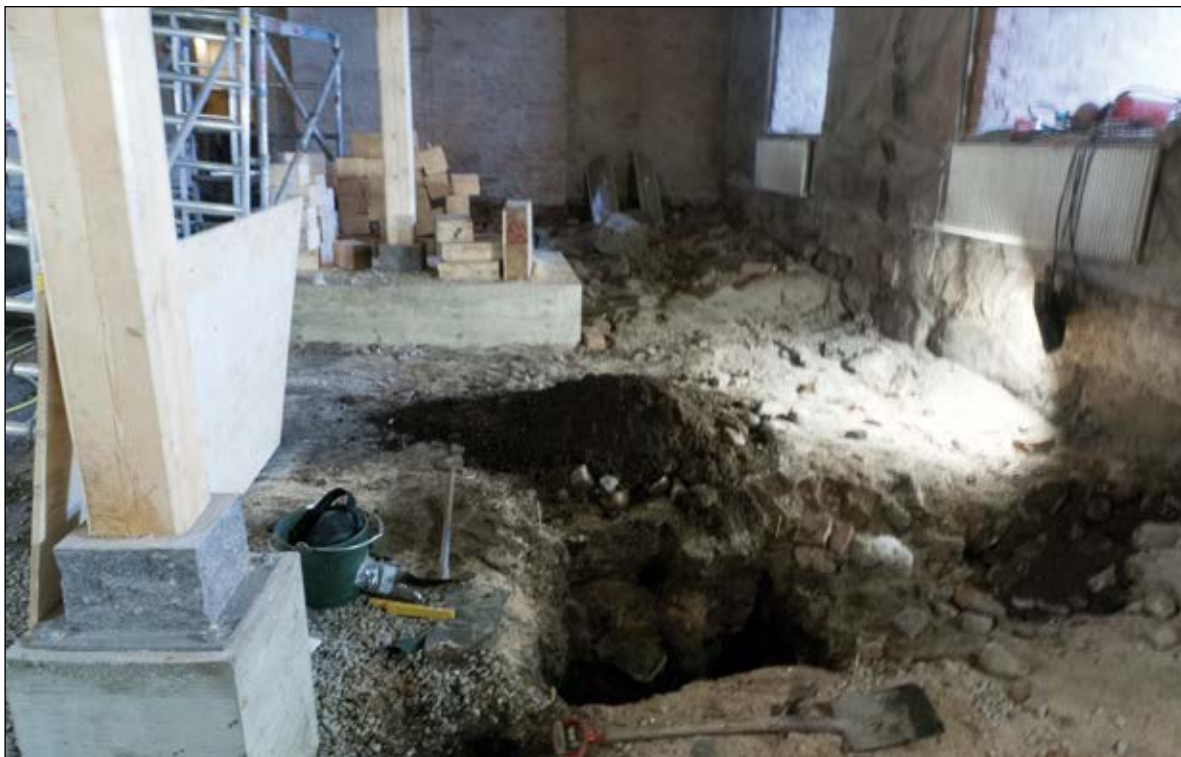
Fig. 7. Situationen i rum 1202 efter att rummet säkrats upp, mot S. Makadam och gjutna pelarfundament täcker lämningarna. Fotonr:2014-18-18. Foto: Stina Tegnhed
