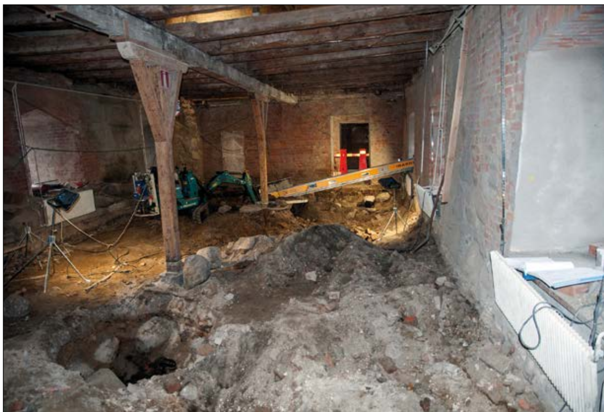
Fig. 8. Rum 1202 efter att betonggolvet rivits ut och vi arkeologer startade förundersökningen, mot N. Fotonr. 2014-18-5. Foto: Anders Håkansson
