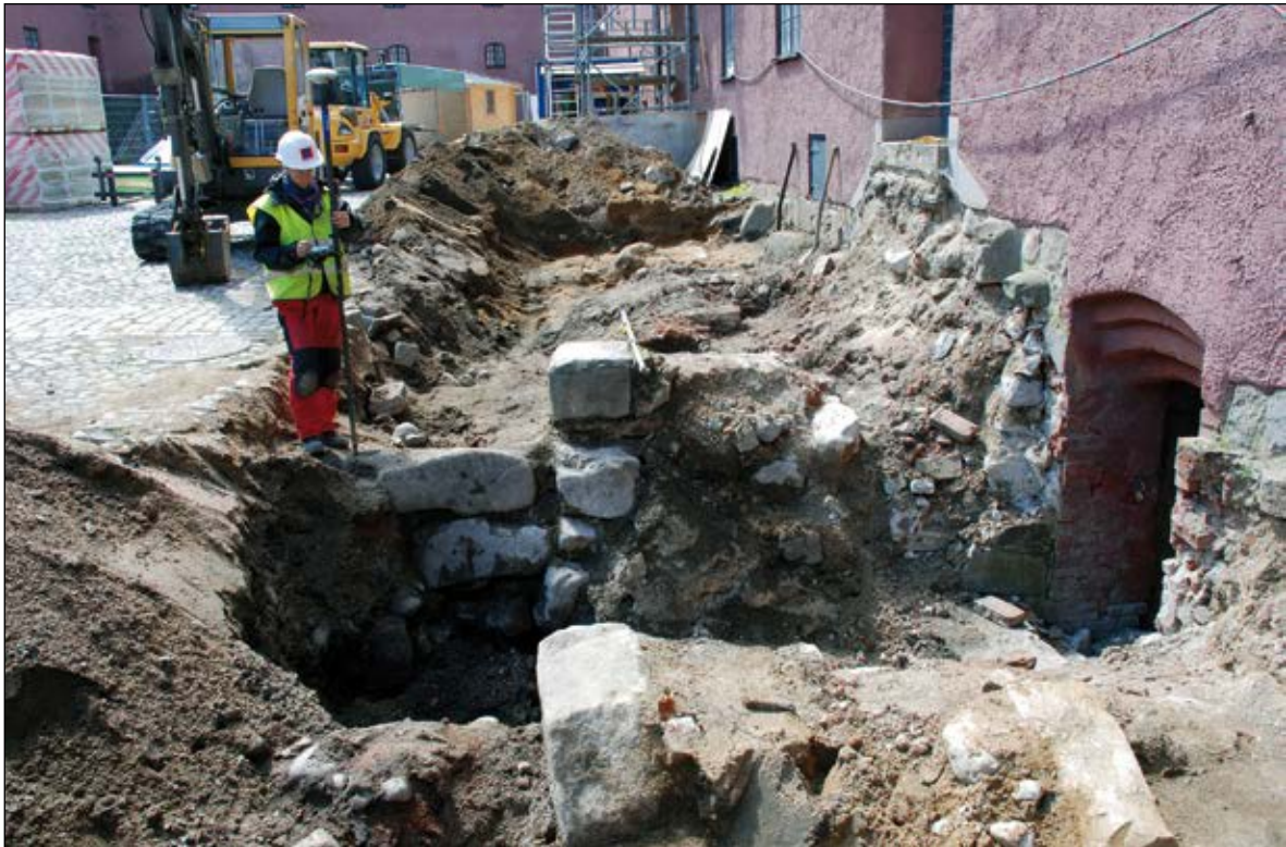
Fig. 38. Schaktningsövervakning på borggården inför anläggande av rum 1215. Den östra muren av den medeltida föregångaren till Västra längan syns. Stina Tegnhed mäter in tillbyggnaden, eventuellt resterna efter den s.k. "Fyrkanten". Mot S Fototr: 2014-18-29 Foto: Anders Håkansson
