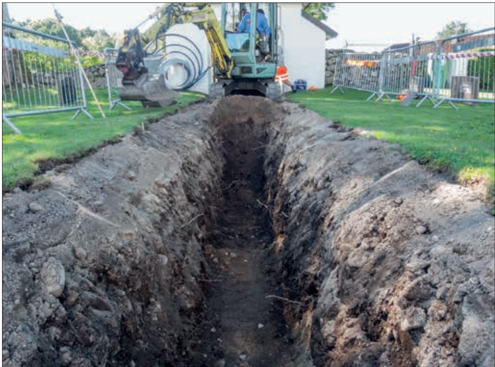
Fig. 7. Schakt med nedgrävningar för gravar, söder om kyrkan i den befintliga grusgången. Mot S Fotonr: 2015-43-22. Foto Stina Tegnhed
