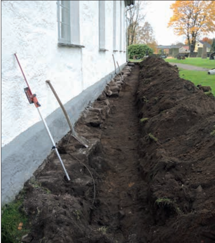
Figur 4. Schaktet norr om kyrkan mot V. Fotonr: 2016-60-3 Foto: Stina Tegnhed.
