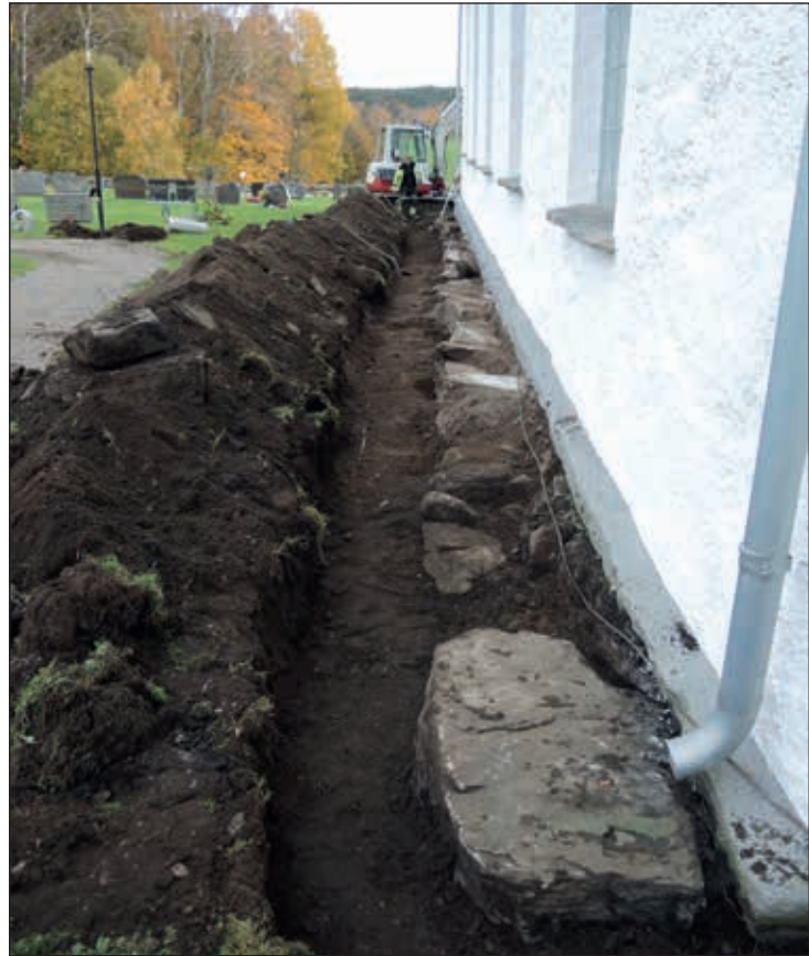
Figur 3. Schaktet norr om kyrkan mot Ö. Fotonr: 2016-60-4 Foto: Stina Tegnhed.
