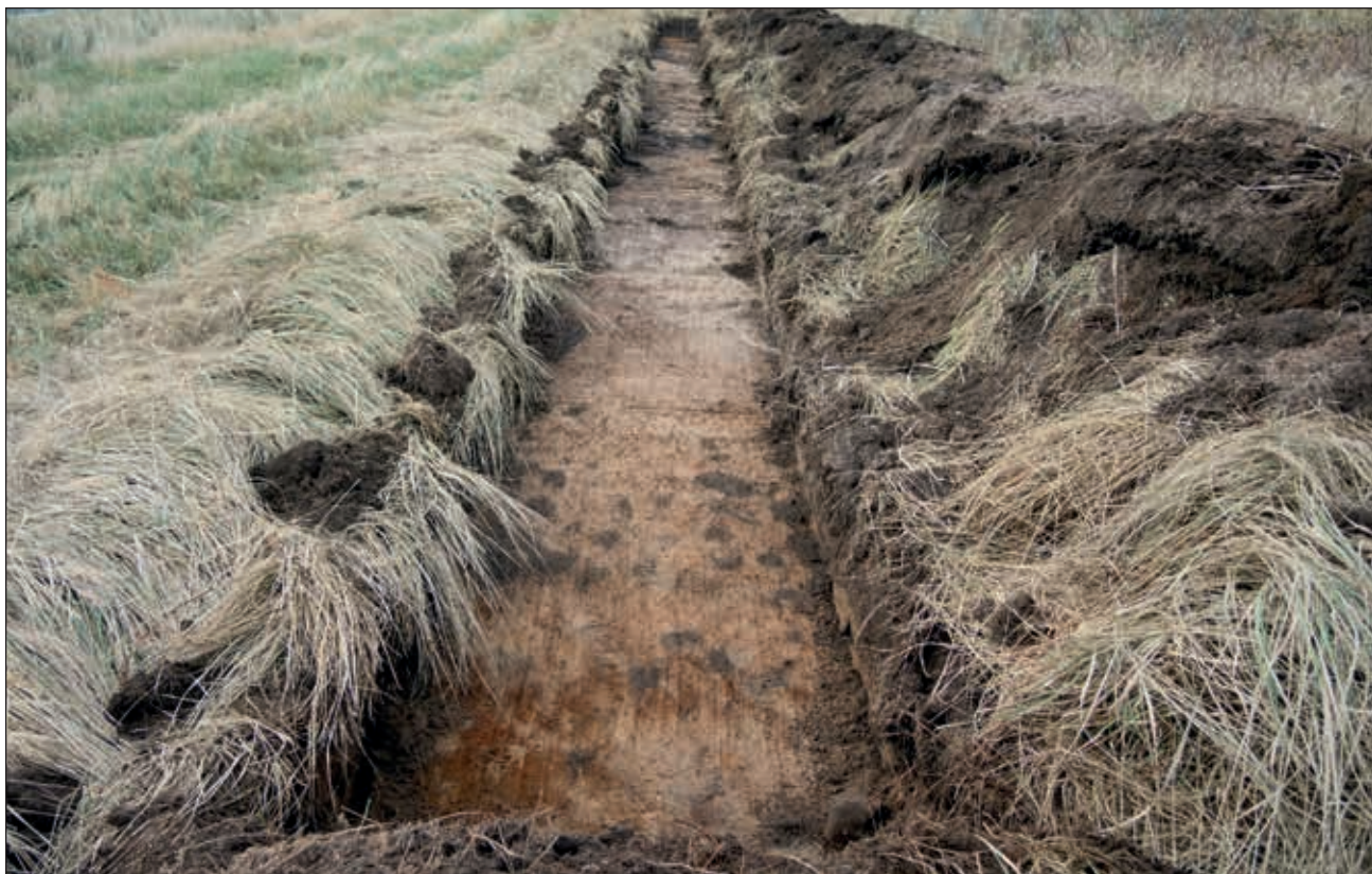
Fig 6 Schakt 239. Parallellt med fornlämning RAÄ Morup 104:1. Foto mot norr. Foto: Mats Nilsson. (Fotonr. 2016-54-07).
